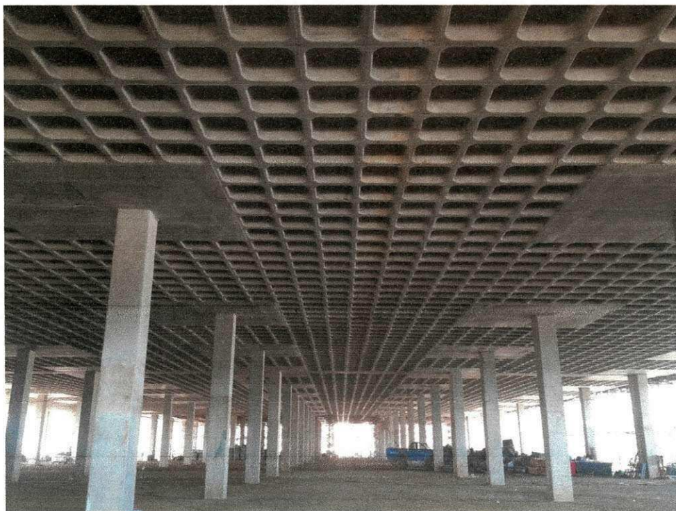
Figura 03 – Laje tipo cogumelo
