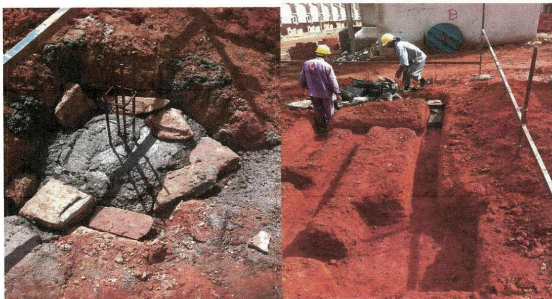
Figura 14– Sapatas& Locação da Obra
