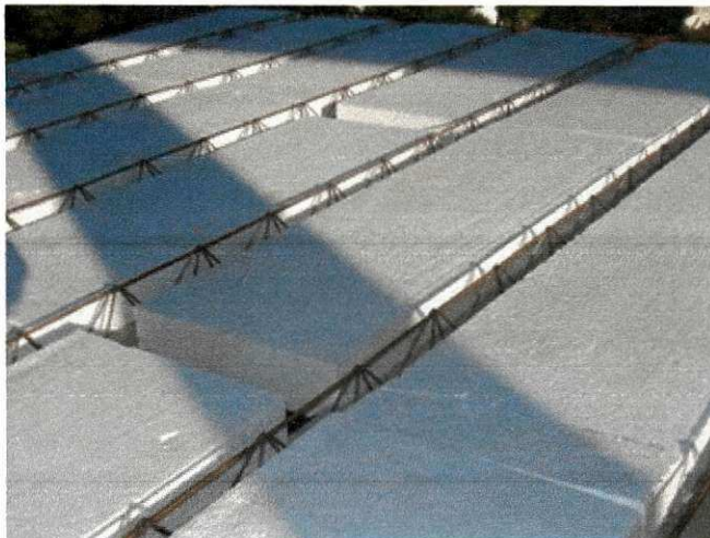
Figura 06 – Laje treçada com isopor
