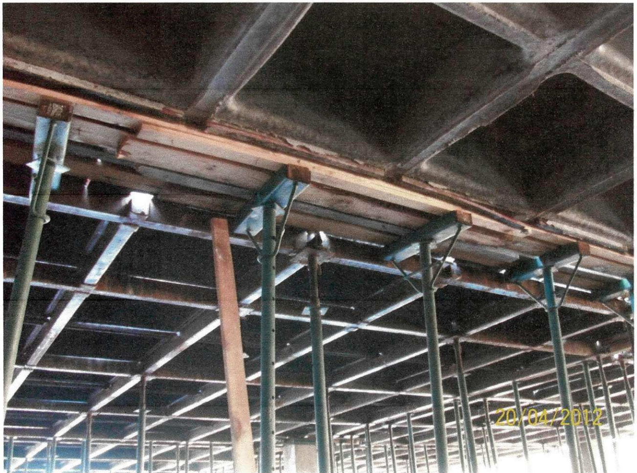
Figura 04 – Laje tipo nervurada
