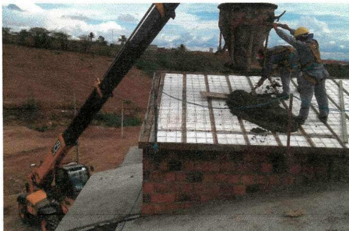
Figura 15 – Enchimento de Laje
