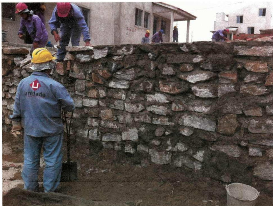
Figura 16 – Muro de Contenção
