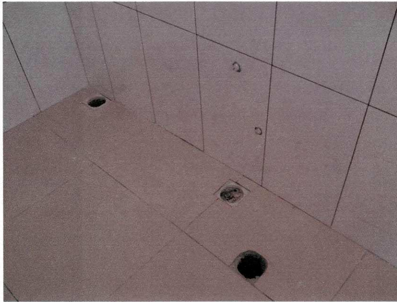
Figura 7- Tubulações de água fria e de esgoto sanitário.
