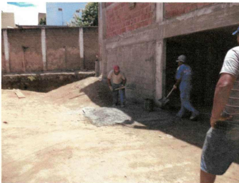
Figura 53- Preparo manual do concreto para preencher uma parte da laje.
