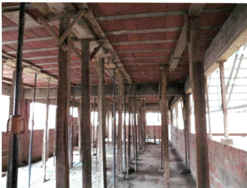
Figura 51- No pavimento inferior a vista dos escoramentos.
