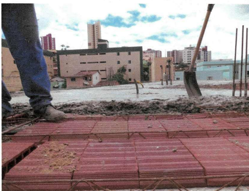
Figura 50- Concretagem de uma das lajes dos escritórios da empresa Aço Brazil.
