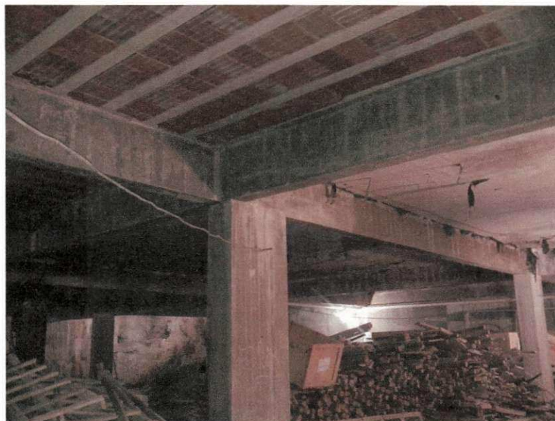
Figura 19- Detalhe das lajes maciças e pré-fabricadas no subsolo do Edifício Portal da Serra.
