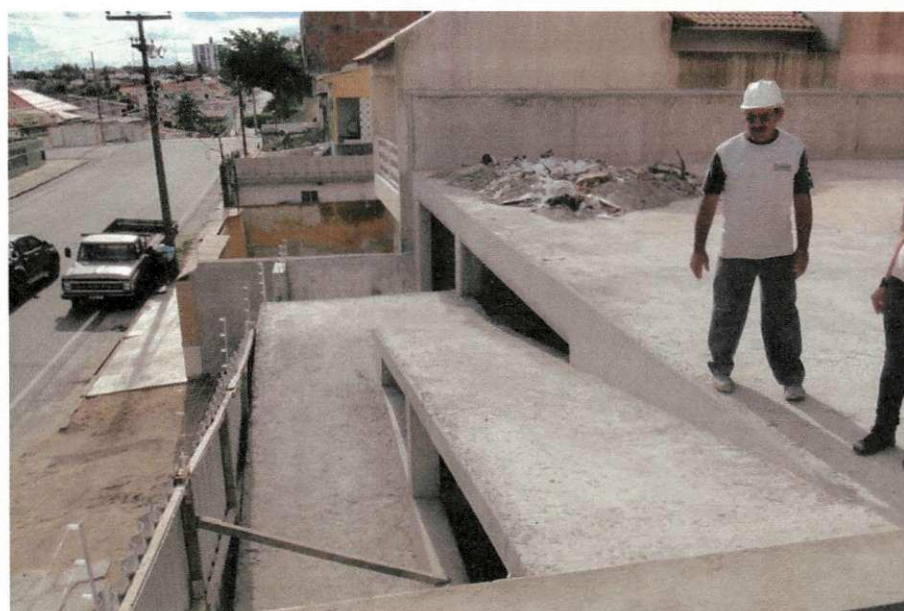
Figura 42-Rampa de acesso ao 1º pavimento.
