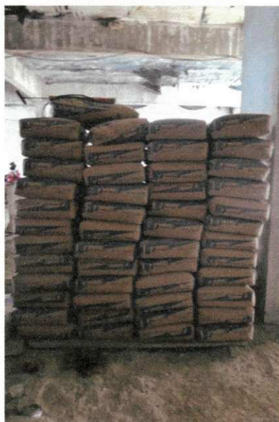
Figura 18- Armazenamento do cimento
