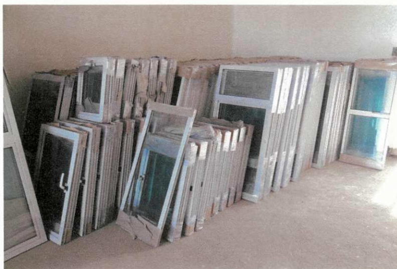
Figura 44- Esquadrias de alumínio.
