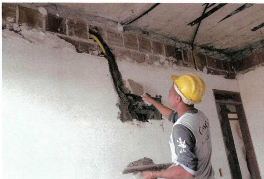
Figura 37-Execução da pré-instalação de sprinter
