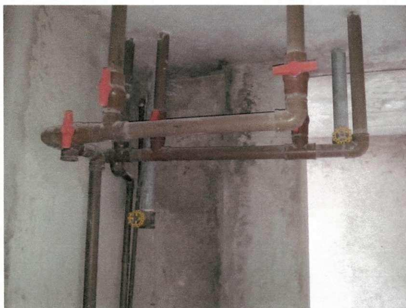
Figura 30- Detalhe do barrilete do reservatório do Portal da serra.
