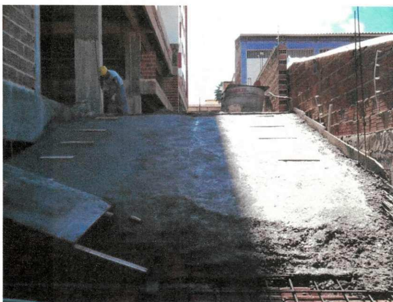
Figura 23- Vista da rampa (pelo térreo) no dia da concretagem
