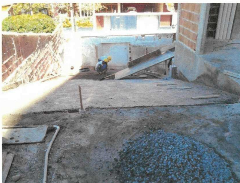
Figura 24- Vista da rampa no final da concretagem
