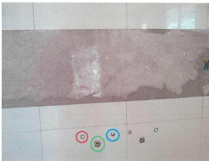
Figura 8- Detalhe das tubulações da pia da cozinha.
