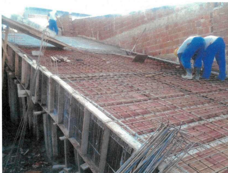
Figura 22- Ferragens da rampa de acesso à garagem.
