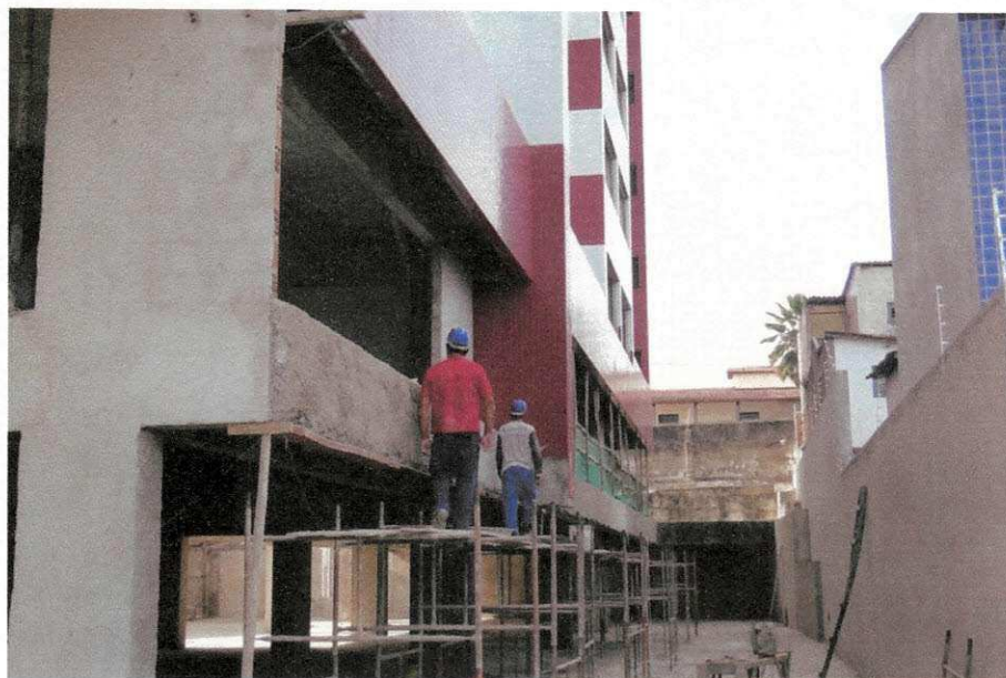
Figura 26- Aplicação dos revestimentos na saia do edifício
