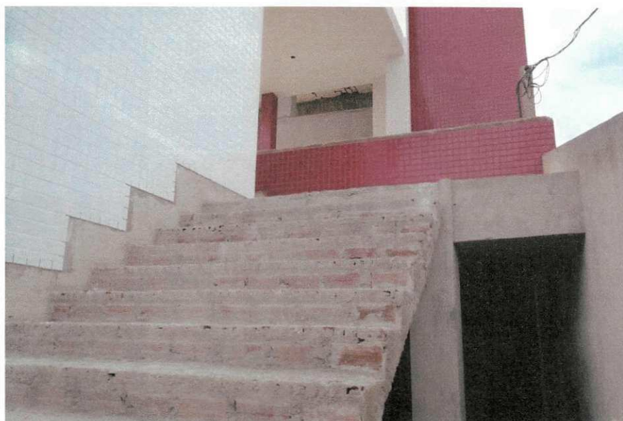
Figura 43- Escada de acesso ao 1º pavimento.
