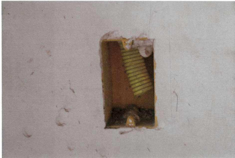
Figura 33- Dispositivos de pré- instalação da rede elétrica.
