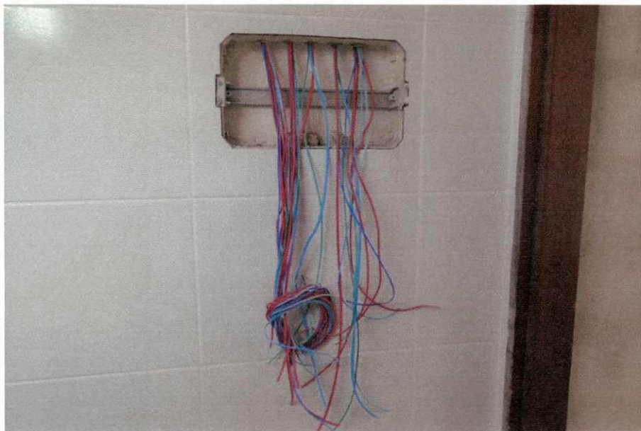
Figura 34- Quadro geral de distribuição.
