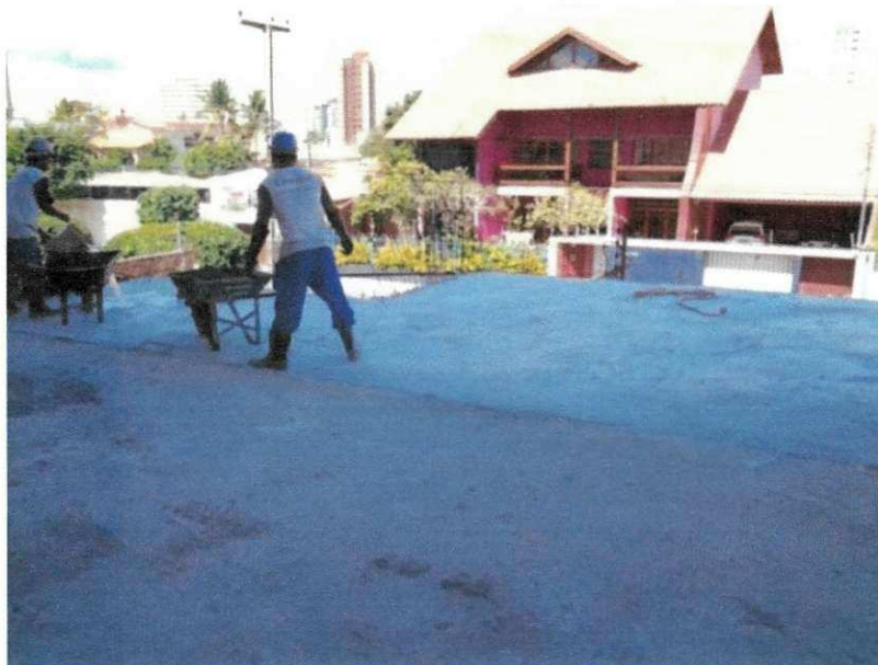
Figura 21- Acesso à rampa pela laje do 1º pavimento- garagem.
