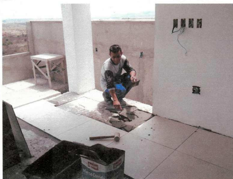
Figura 9-Execução do piso externo.
