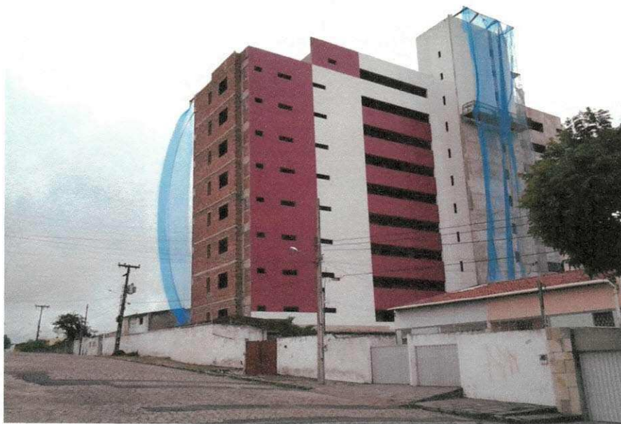
Figura 25-Fachada oeste do Portal da serra.
