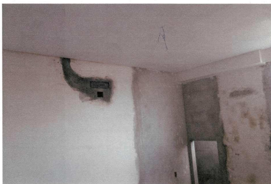
Figura 38- Pré- instalação de sprinter
