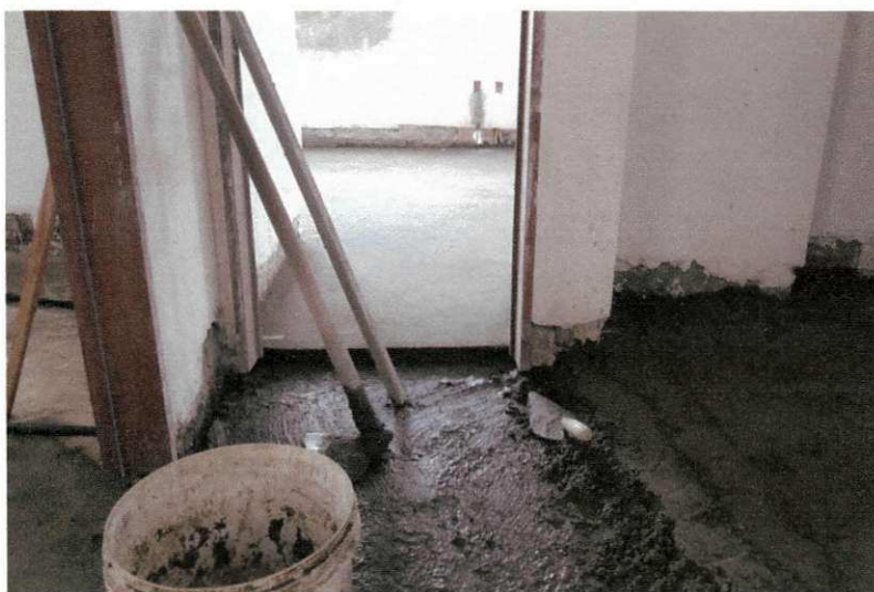
Figura 40- Contrapiso de concreto
