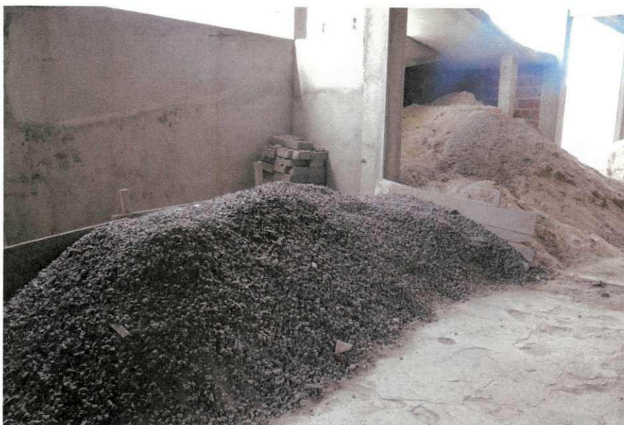
Figura 17- Armazenamento dos agregados brita e areia
