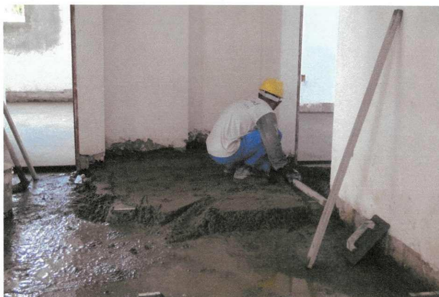
Figura 41- Execução do contrapiso de concreto
