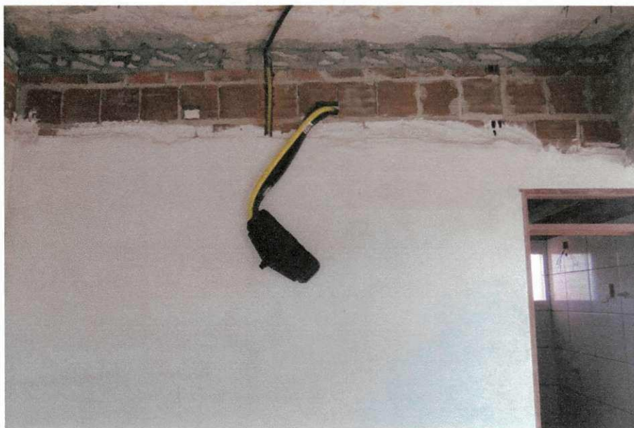
Figura 36- Caixa de pré-instalação de sprinter
