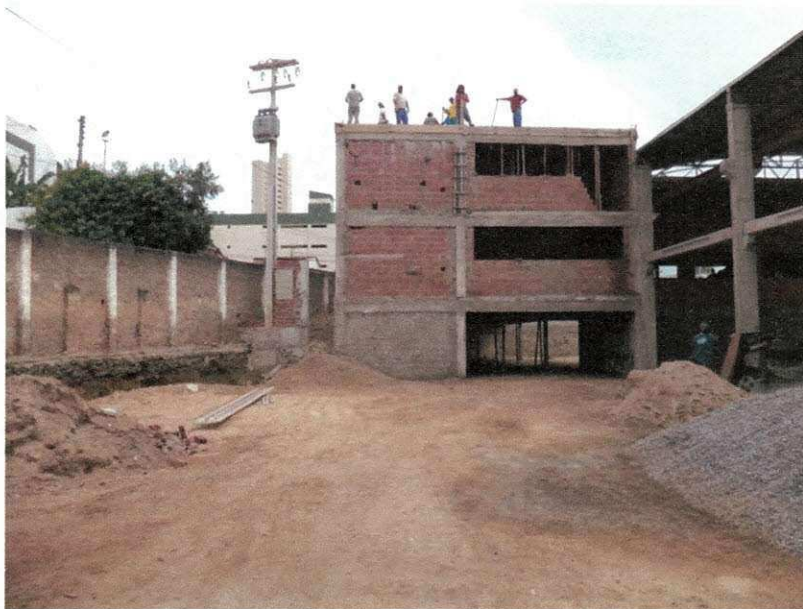
Figura 49-Vista da construção pelo portão principal.
