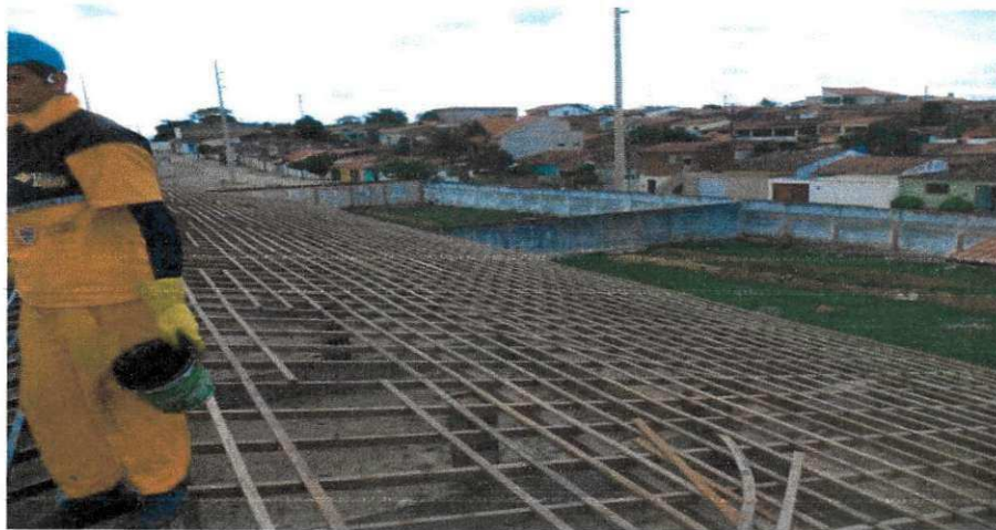
Figura 24 - Recuperação da estrutura de madeira dos telhados onde houve necessidade.
