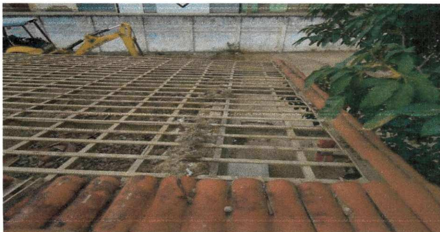
Figura 23 - Demolição de telhas cerâmicas para recuperação do madeiramento do telhado.
