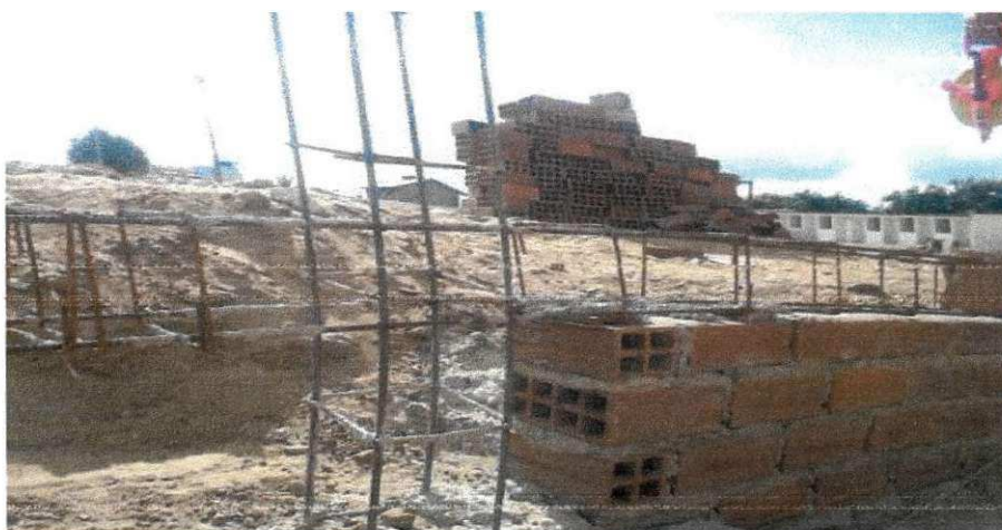
Figura 9 - Alvenaria de nivelamento e armadura do pilar e da cinta inferior.
