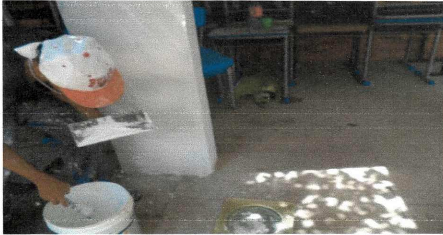
Figura 42 - Aplicação de massa corrida.
