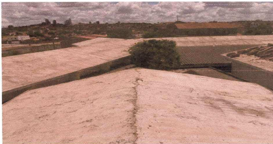
Figura 47 - Demolição de telhas cerâmicas.
