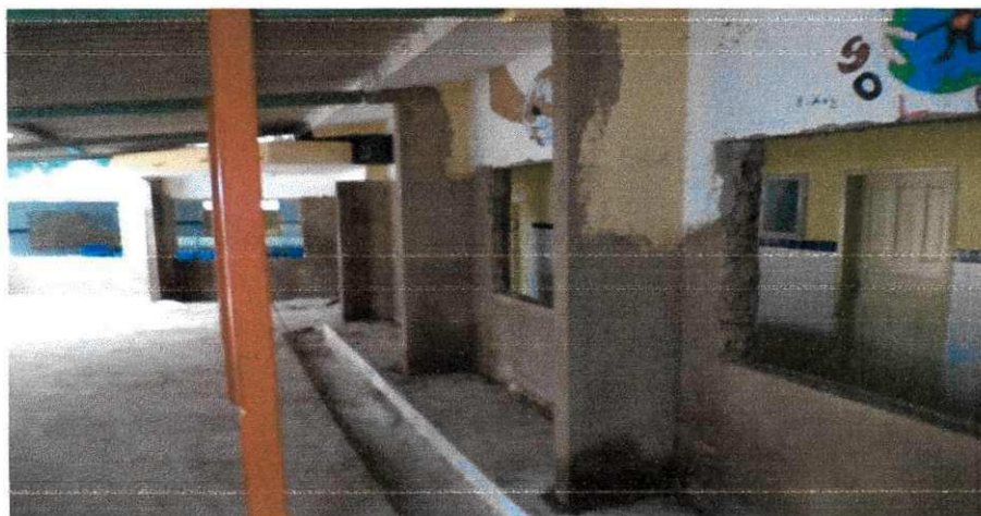
Figura 55 - Recuperação dos pilares.
