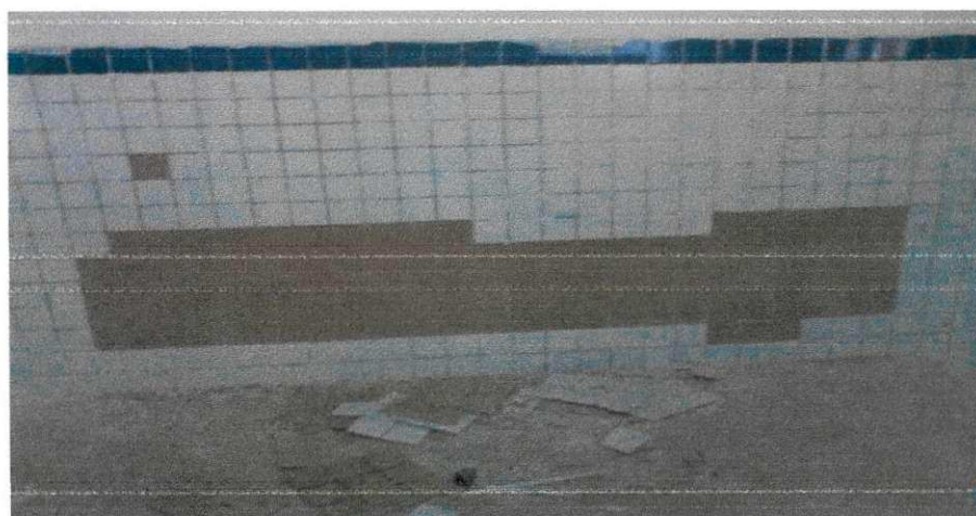
Figura 59 - Demolição de revestimento cerâmico.
