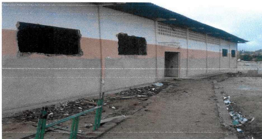
Figura 56 - Demolição de alvenaria para abertura de janela.
