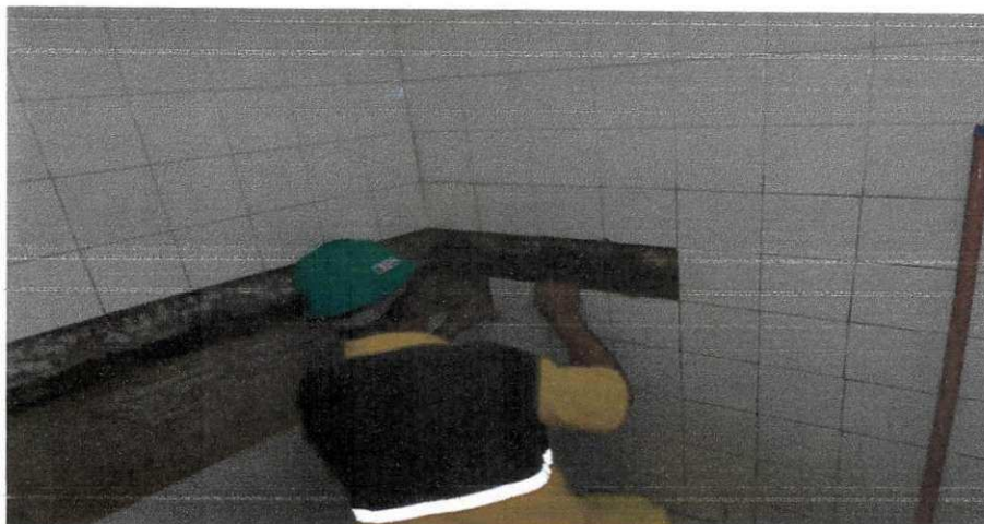
Figura 16 - Assentamento de revestimento cerâmico na cozinha.
