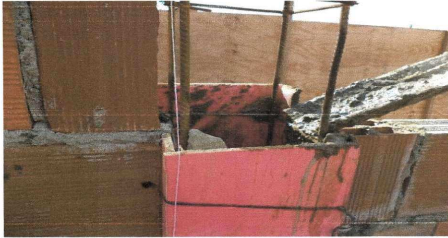
Figura 10 - Lançamento de concreto no pilar do muro.
