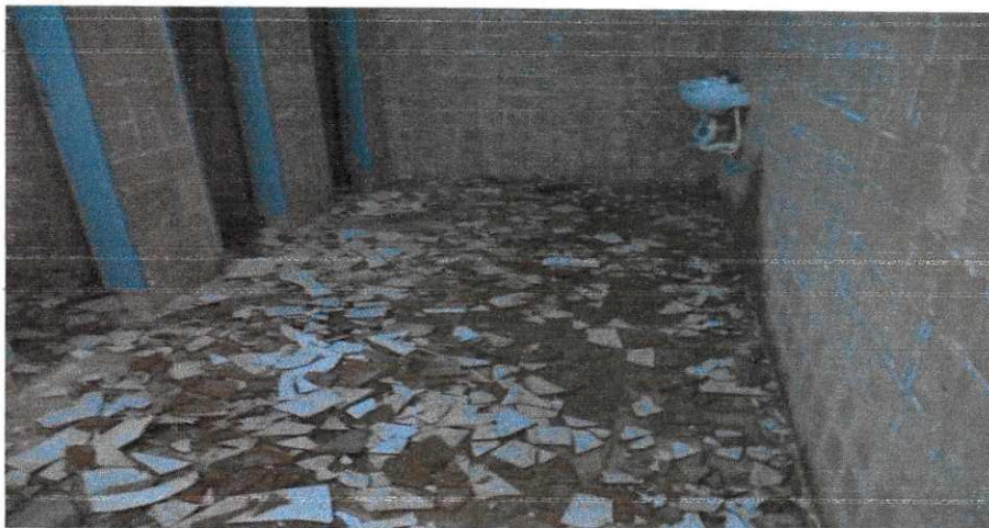
Figura 14 - Demolição de azulejo dos banheiros.
