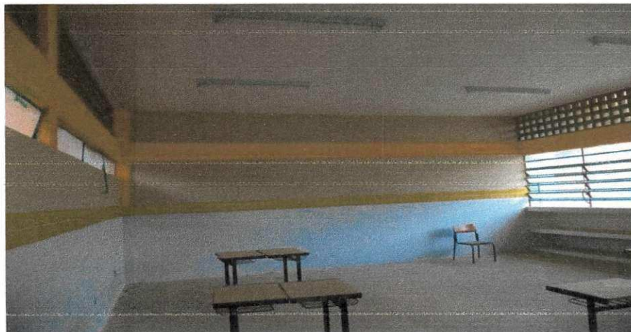
Figura 43 - Pintura da sala de aula.
