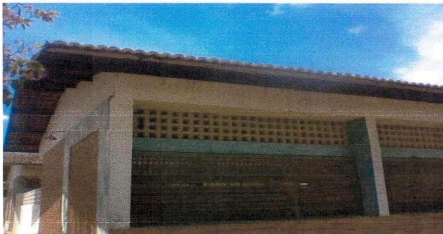
Figura 27 - Execução de beire bico no acabamento das telhas cerâmicas.
