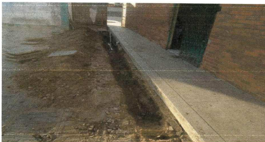
Figura 30 - Escavação para troca de tubulação danificada da cozinha.
