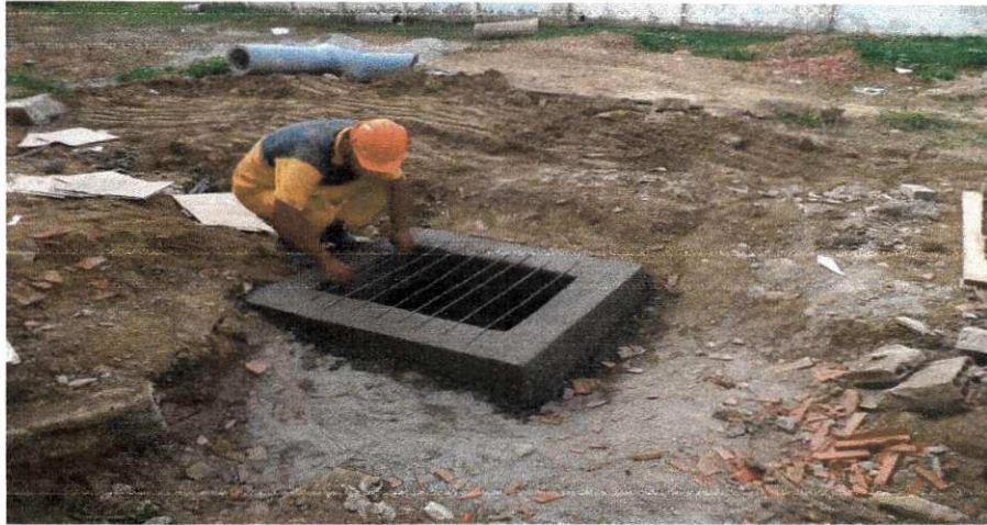
Figura 36 - Execução de caixa de passagem.
