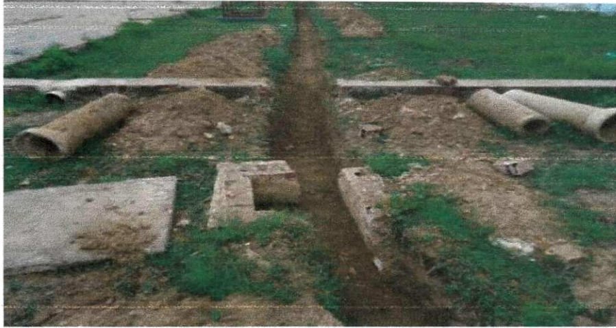
Figura 28 - Escavação para retirada e troca das maninhas cerâmicas.
