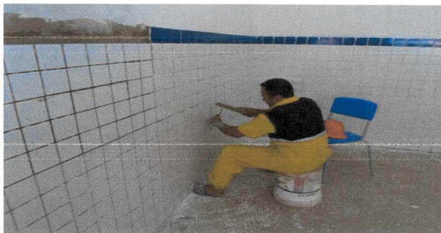
Figura 58 - Retirada de rejunte.
