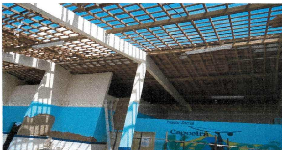
Figura 49 – Recuperação do telhado e da estrutura de madeira do telhado.
