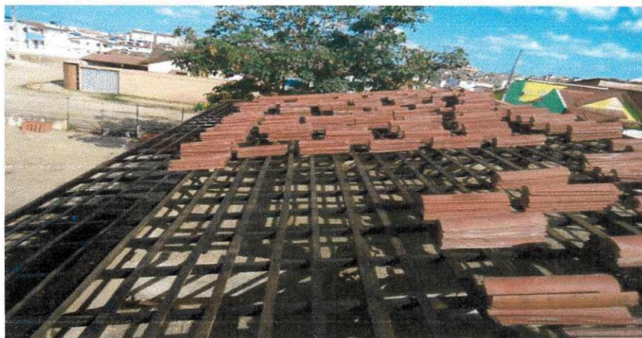
Figura 25 - Impermeabilização do madeiramento do telhado.
