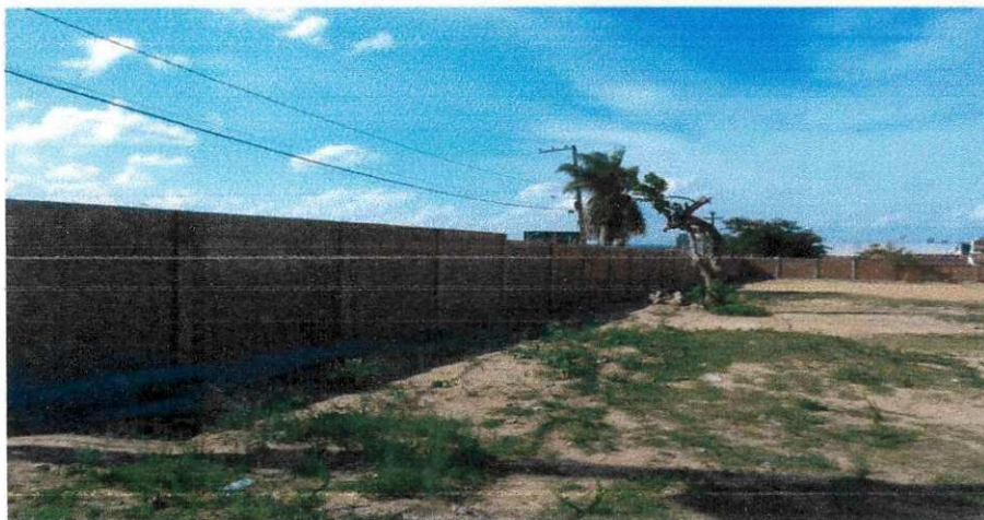
Figura 11 - Levantamento de alvenaria do muro.
