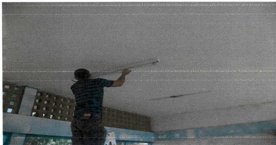
Figura 39 - Retirada de calhas elétricas danificadas.
