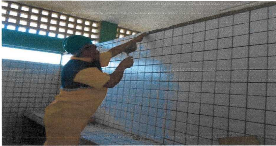
Figura 38 - Assentamento de revestimento cerâmico da cozinha.
