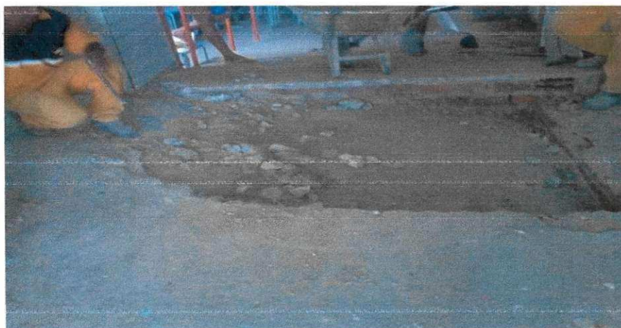
Figura 57 - Demolição da rampa de entrada para projeto de acessibilidade.
