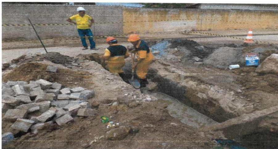
Figura 34 - Retirada de paralelepípedo e escavação para recuperação da tubulação.
