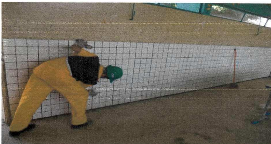
Figura 22 - Assentamento de revestimento cerâmico nas salas de aulas.
