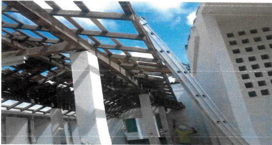
Figura 12 - Demolição de telhas cerâmicas - Recuperação do telhado.
