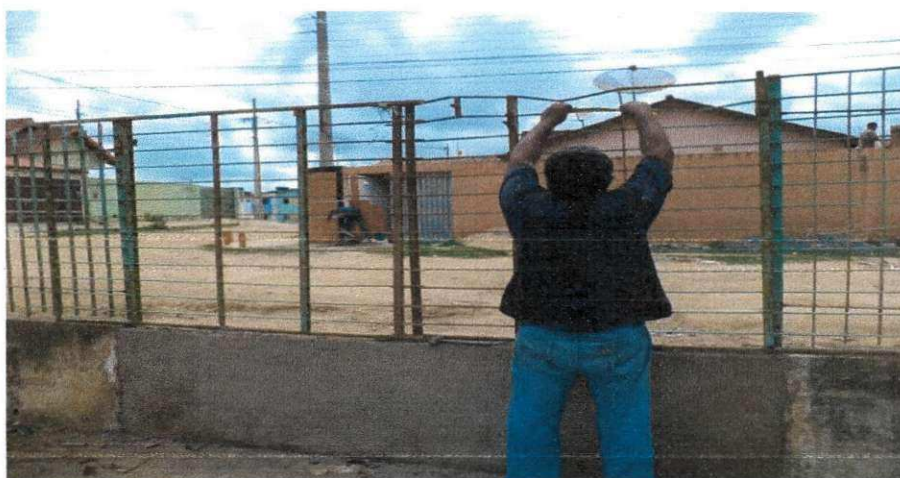
Figura 45 - Recuperação de esquadrias metálicas.
