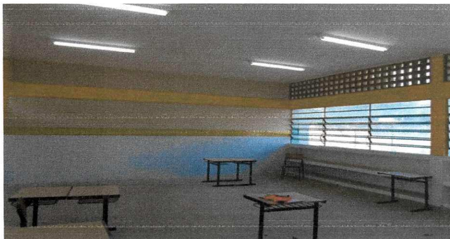
Figura 40 - Colocação de calhas elétricas novas nas salas de aulas.
