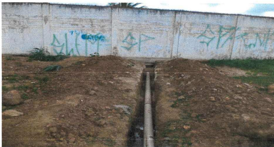
Figura 32 - Recuperação da tubulação de esgoto.
