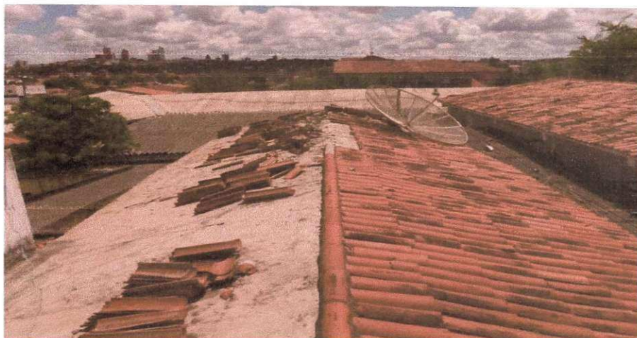
Figura 48 - Demolição da cumeeira cerâmica.
