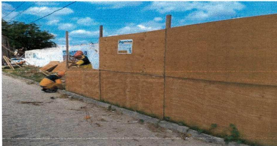
Figura 5 - Colocação de tapume para recuperação do muro.
