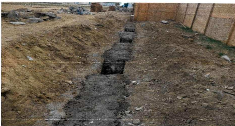
Figura 8 - Alvenaria em pedra rachão.
