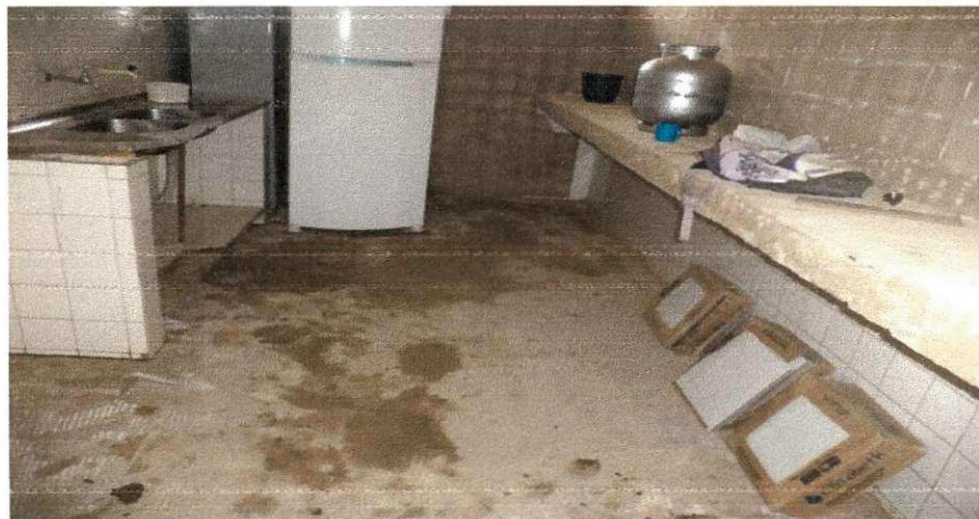
Figura 37 - Demolição de revestimento cerâmico da cozinha.
