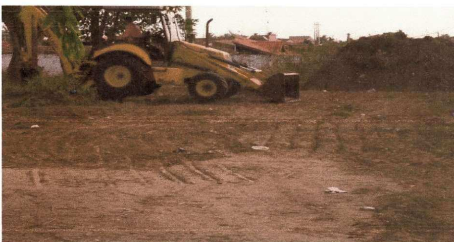
Figura 19 - Limpeza mecanizada na área externa da escola.
