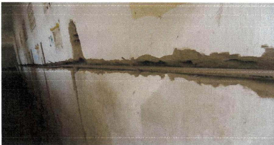
Figura 15 - Rasgo em alvenaria para retirada e recuperação da tubulação de água fria dos banheiros.
