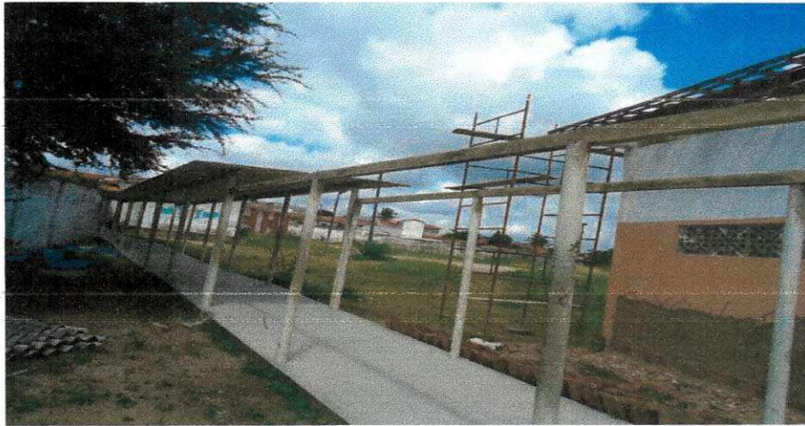
Figura 46 - Demolição de estrutura de madeira e de telhas ondulares.
