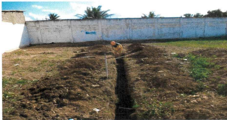
Figura 29 - Escavação para troca das tubulações danificadas.
