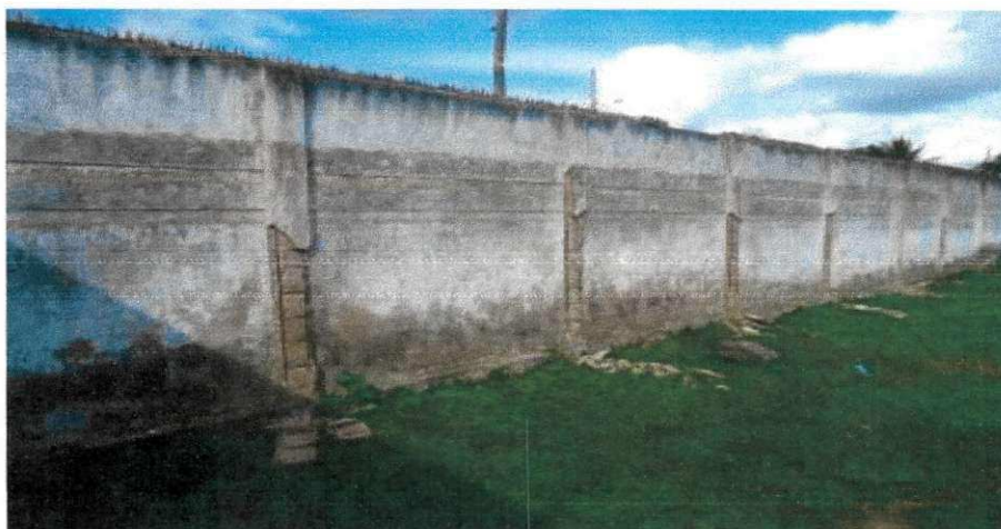
Figura 35 - Demolição de camada de concreto para recuperação da estrutura metálica dos pilares.
