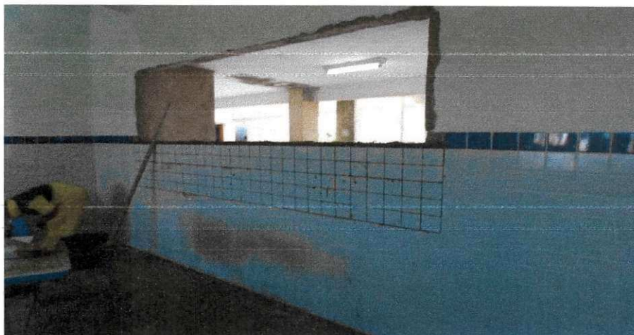
Figura 60 - Assentamento de revestimento cerâmico.
