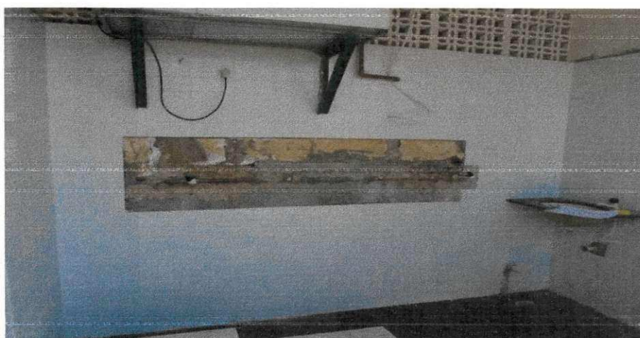
Figura 17 - Assentamento de revestimento cerâmico nos painéis do bebedouro.
