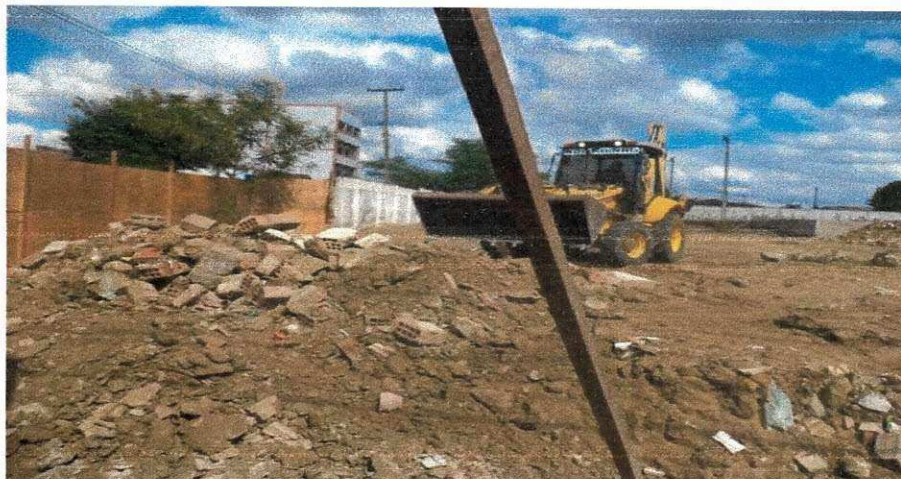
Figura 6 - Demolição do muro, cintas e pilares da murada principal.
