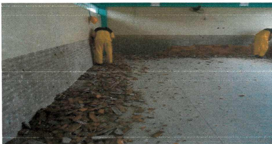
Figura 21 - Demolição de revestimento cerâmico das salas de aulas.
