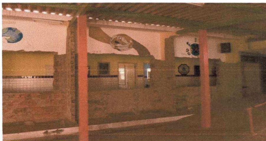
Figura 51 - Demolição de argamassa.
