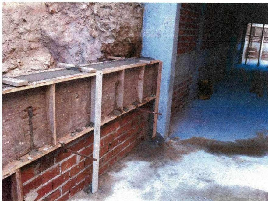
**Figura 15** – Vigas “Cintas” Utilizadas em um dos Pavimentos de Garagens.
