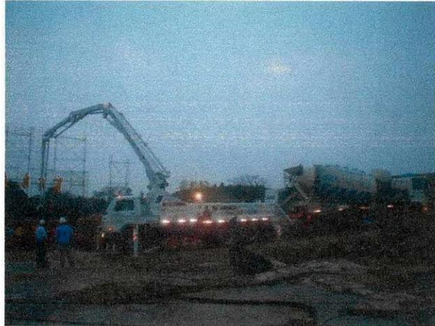
**Figura 9**–Caminhão Bomba com Lança para Concreto. (FONTE: Lançamix)
