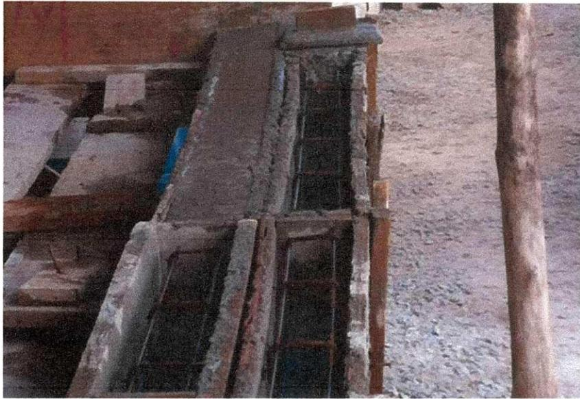
**Figura 21** –Moldagem e Armação de uma Verga.
