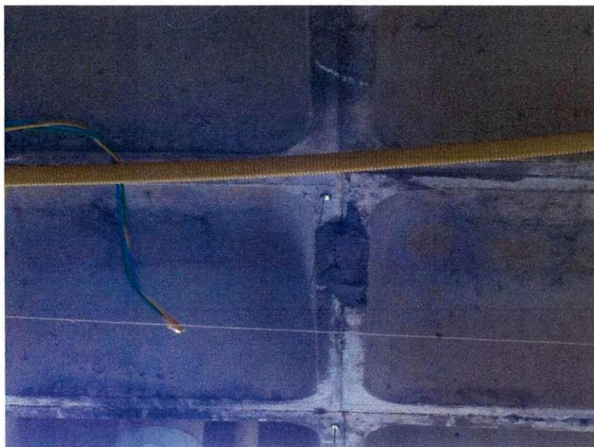
**Figura 25** – Rebite com Arame Preso na Laje de Concreto.
