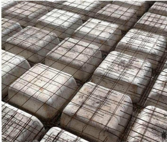
**Figura 12** – Laje Nervurada Armada para Pavimento-Tipo.
