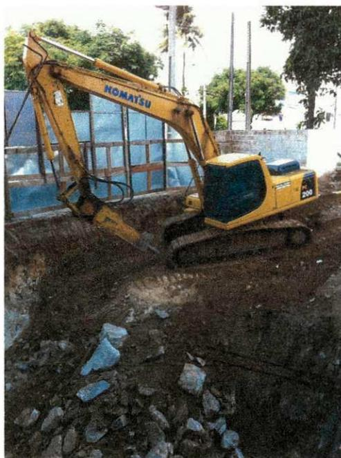
**Figura 5 -** Movimentação de Terra e Rompimento de Rocha.
