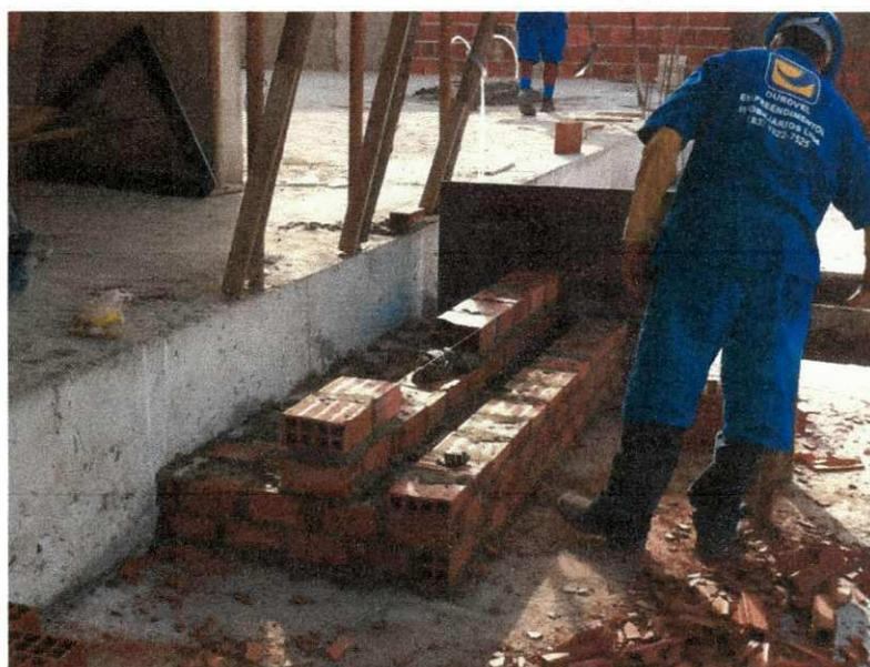
**Figura 20** – Execução de Alvenaria em Escada.
