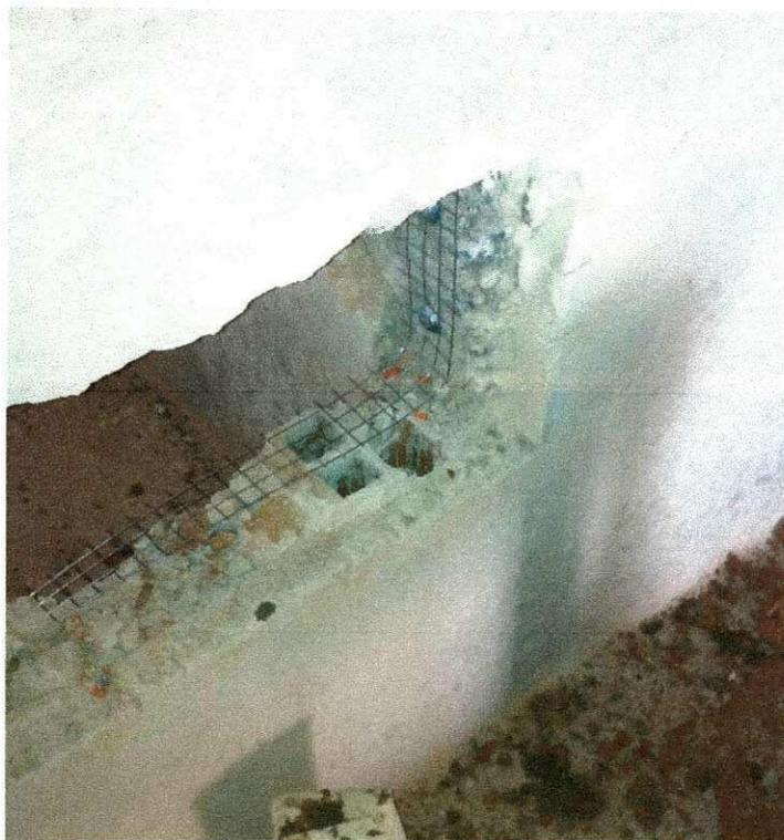
**Figura 37** –Aplicação da Tela Metálica para Alvenaria.
