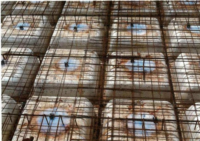
**Figura 13** – Laje Nervurada Armada para Piscina.
