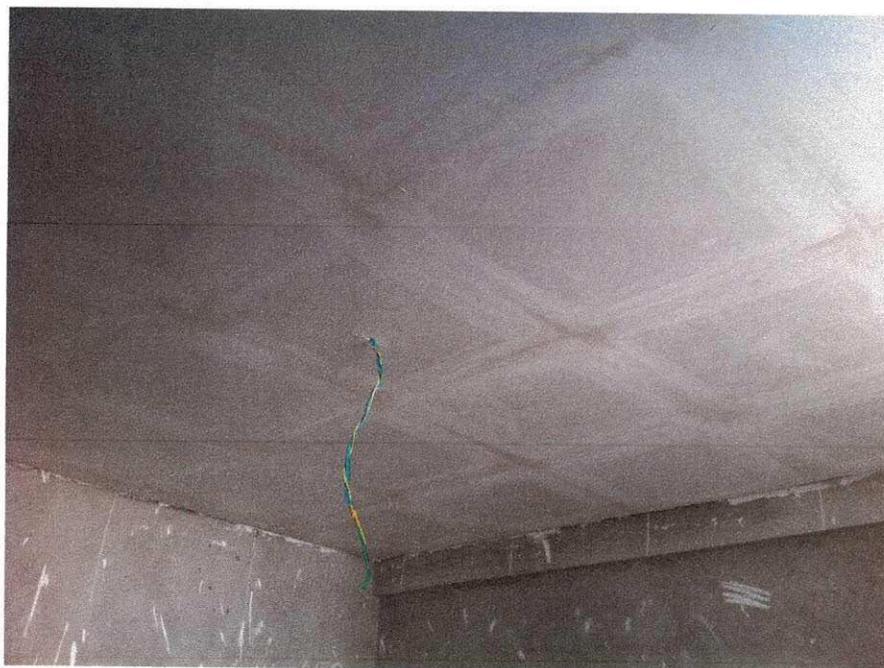
**Figura 29** – Acabamento Feito com Gesso nas Juntas.
