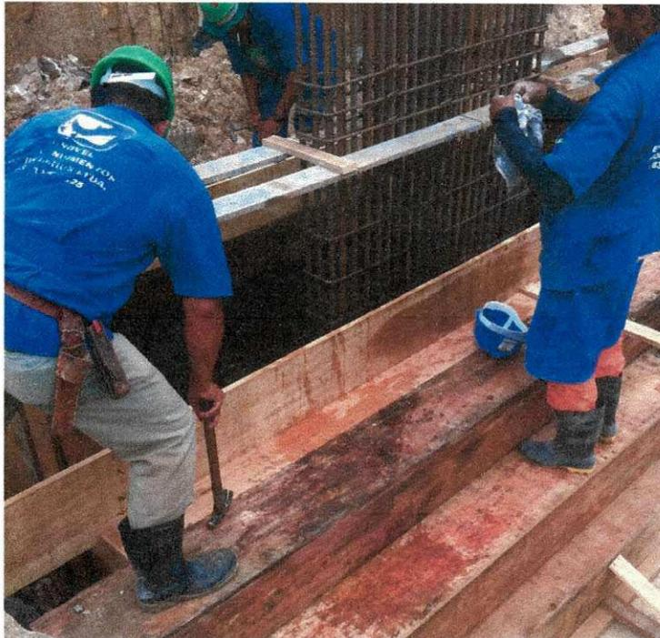
**Figura 7–** Armadura da Sapata.
