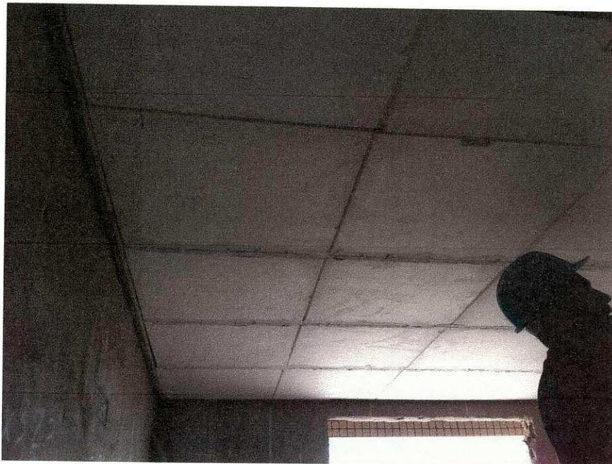
**Figura 28** – Placas de Gesso Encaixadas em Cantoneiras e entre si.
