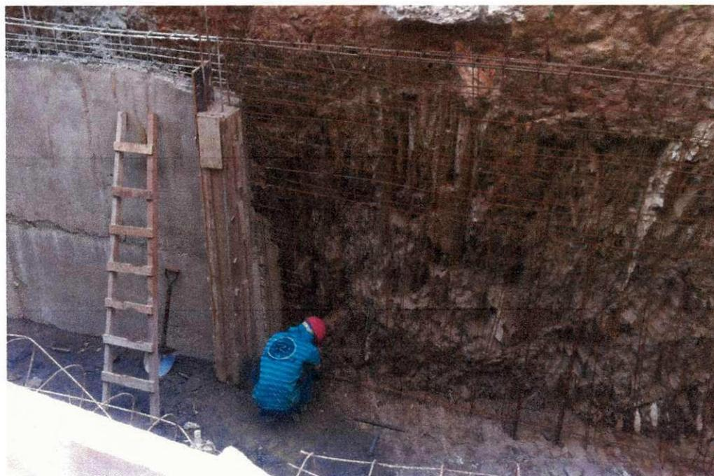
**Figura 14** – Viga-Parede Concretada e Armadura.
