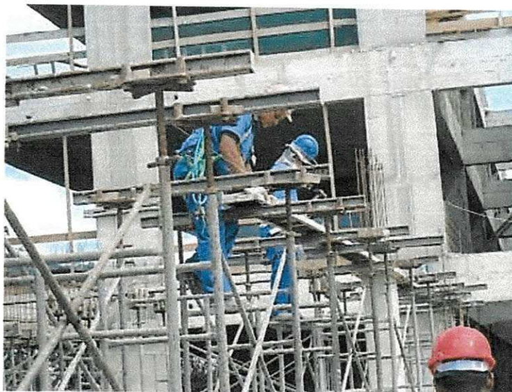
Figura 38 – Operários montando a forma de uma viga
