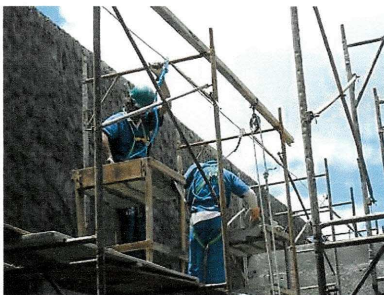
Figura 54 – Pedreiros rebocando faixa
