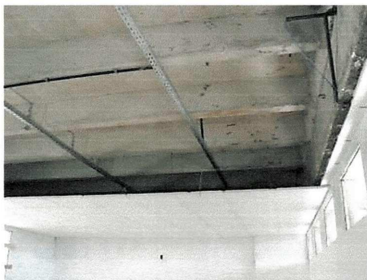
Figura 63 – Forro de gesso sendo colocado
