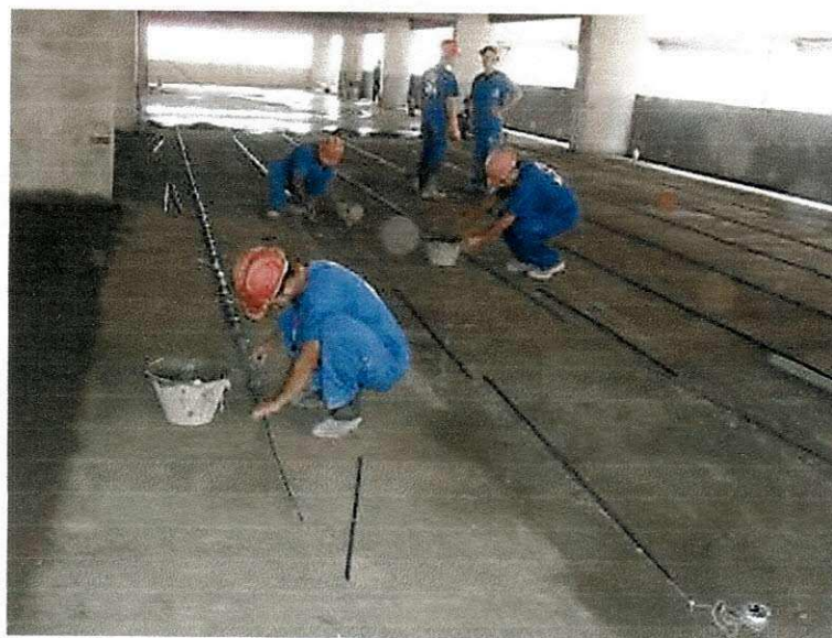
Figura 60 – Pedreiros colocando juntas do granilite
