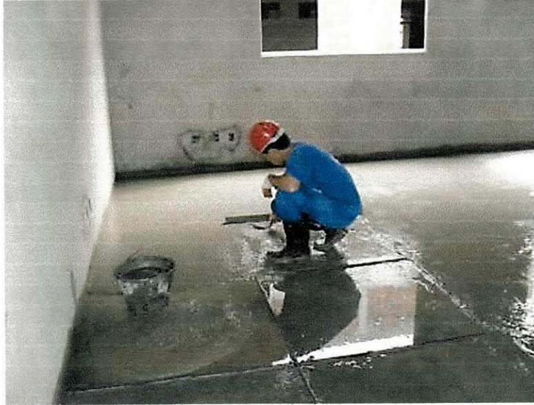
Figura 61 – Pedreiro aplicando o granilite
