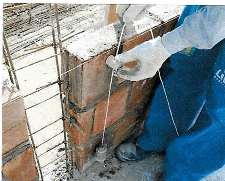
Figura 50 – Pedreiro verificando prumo da alvenaria
