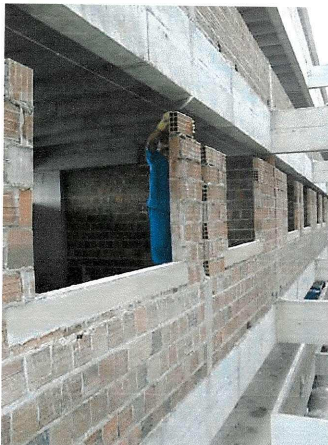
Figura 49 – Pedreiro assentando última fiada de alvenaria
