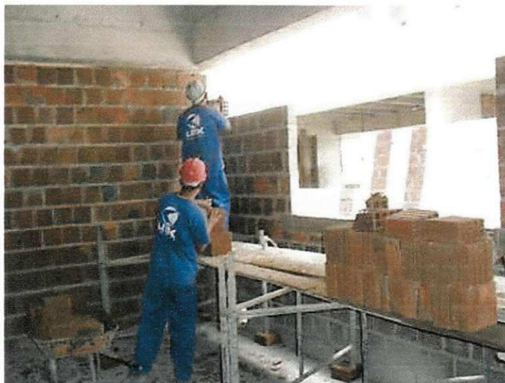
Figura 48 – Pedreiro assentando alvenaria
