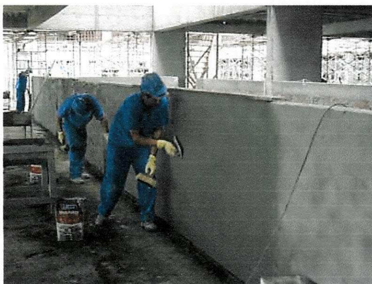
Figura 56 – Pedreiro rebocando parapeito
