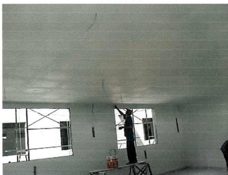
Figura 64 – Forro de gesso pronto
