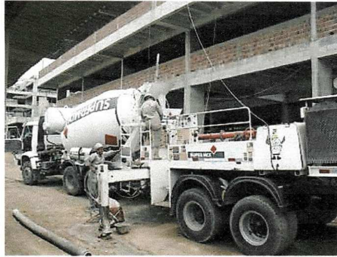
Figura 45 – Caminhão betoneira e bomba da usina de concreto
