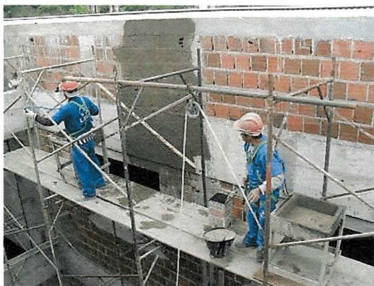
Figura 53 – Pedreiros chapiscando faixa
