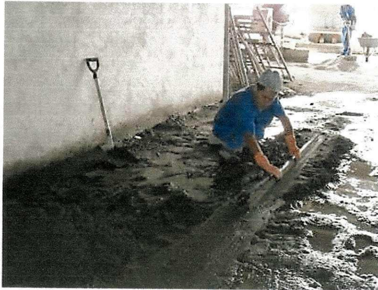
Figura 59 – Pedreiro fazendo contrapiso
