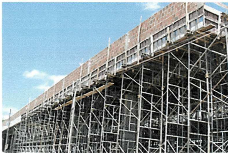
Figura 43 – Escoramento da estrutura
