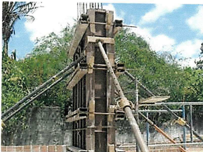
Figura 40 – Fôrma de pilar
