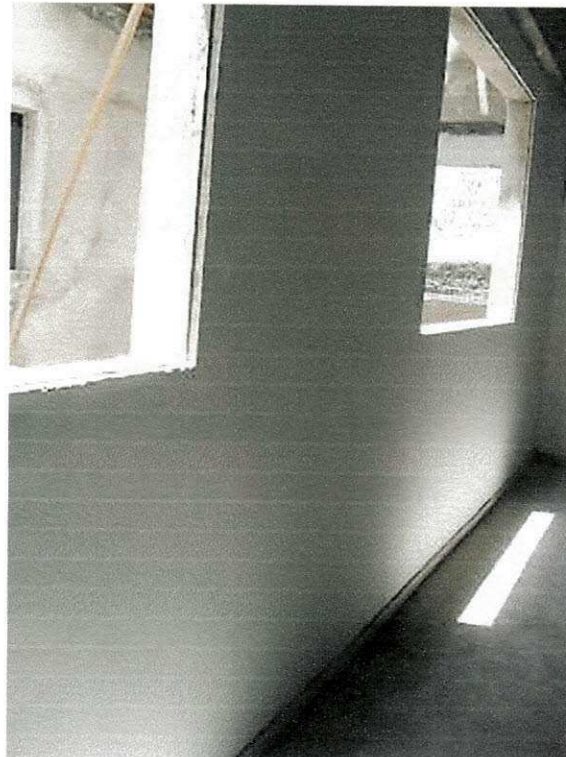
Figura 58 – Parede com uma demão de massa corrida
