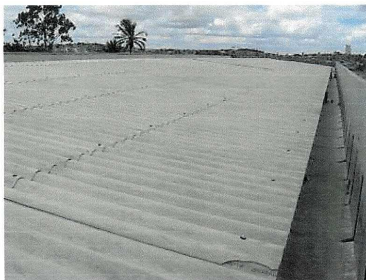
Figura 66 – Telhado e calha
