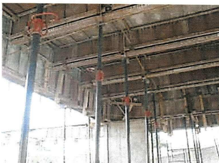
Figura 41 – Escoramento da laje
