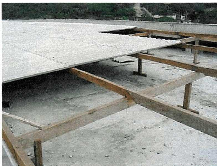
Figura 65 – Telhado da estrutura (telha de fibrocimento)
