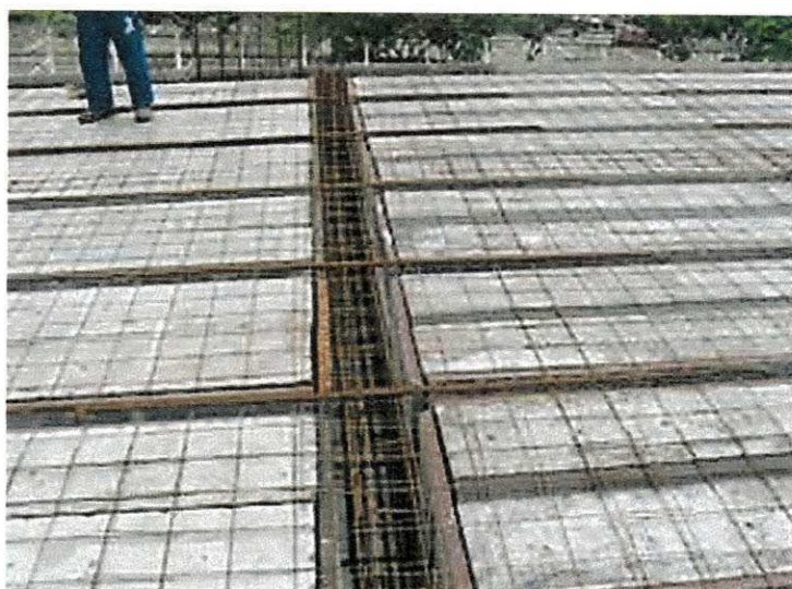
Figura 39 – Forma e armação das lajes
