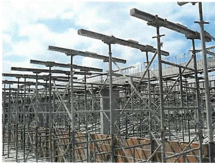
Figura 42 – Escoramento da viga
