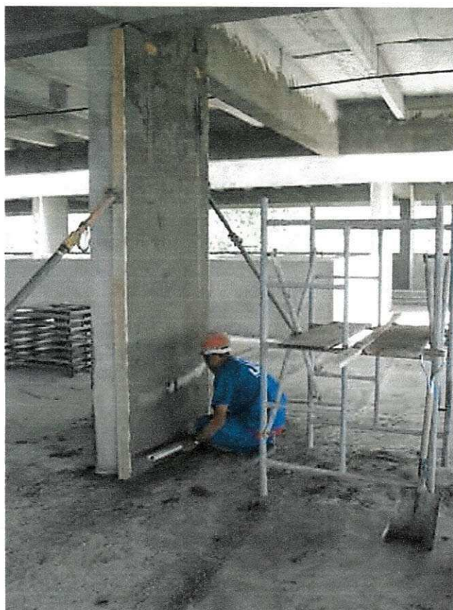
Figura 55 – Pedreiro rebocando pilar
