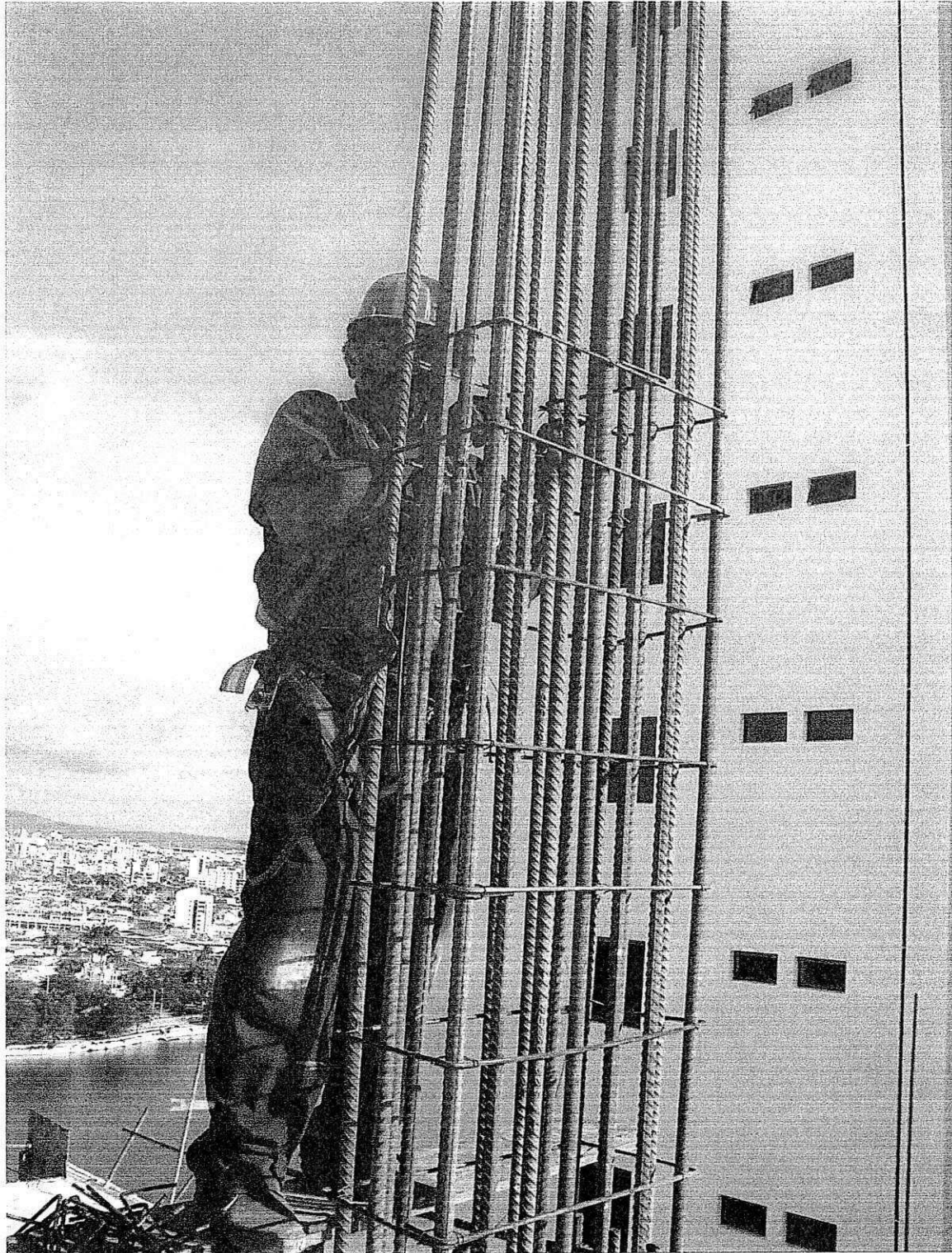
Figura 39 - Colocação dos estribos no pilar
