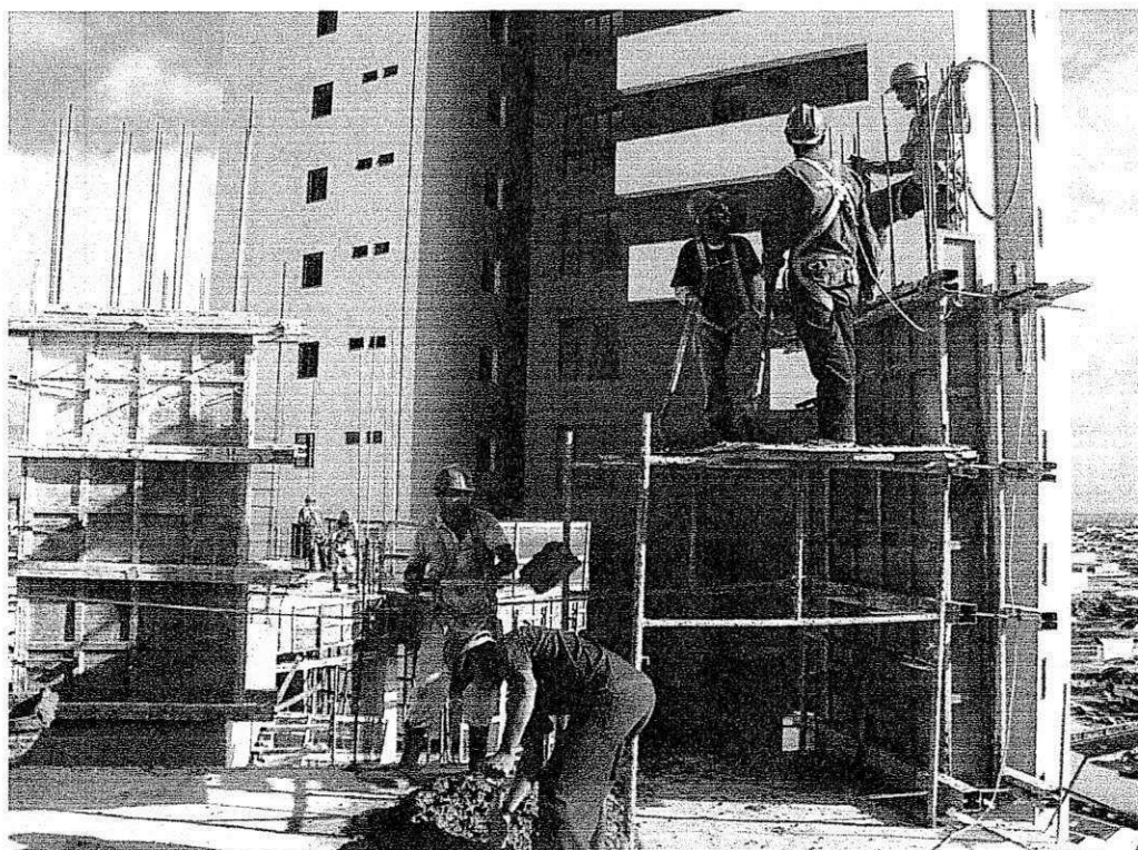
Figura 41 - Concretagem do pilar
