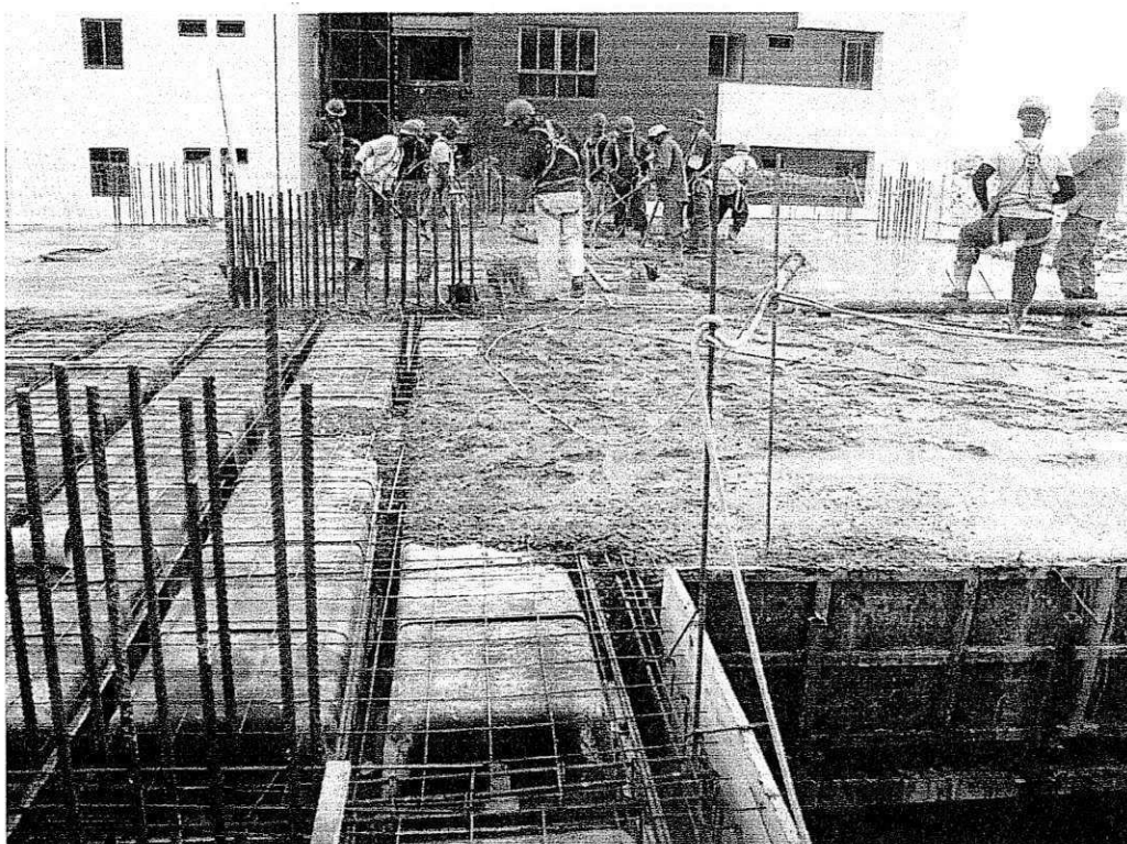
Figura 35 - Concretagem da laje
