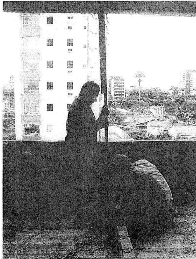
Figura 44 - Levantamento da alvenaria (com cantilhão)
