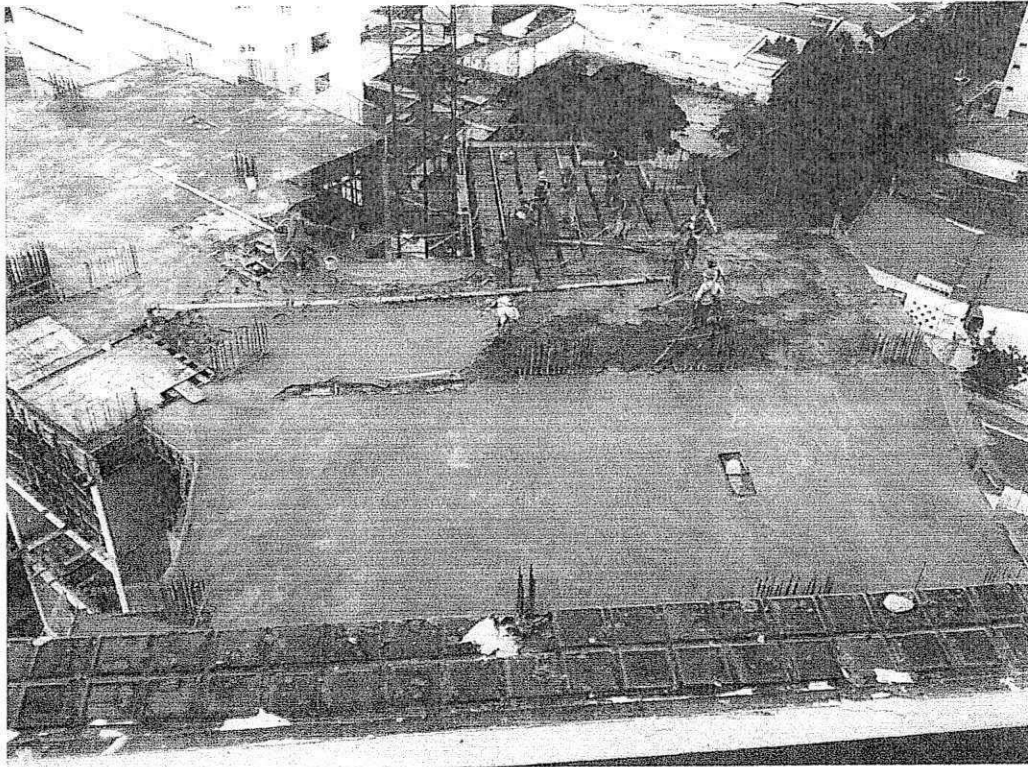
Figura 38 - Concretagem da laje
