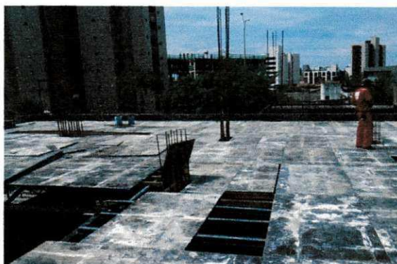
Figura 32 – Formas para laje
