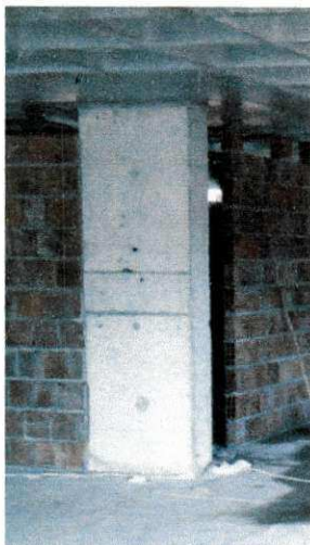
Figura 34 - Pilar depois da retirada da forma
