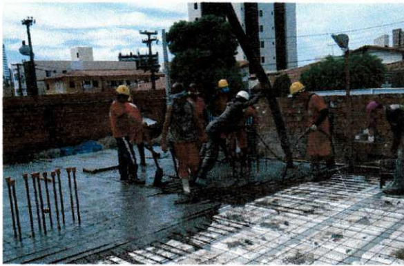
Figura 8 – Concretagem da laje
