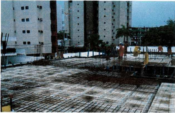
Figura 12 – Laje com ferragem pronta
