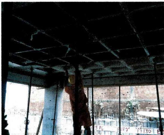
Figura 17 – Retirada das formas
