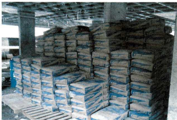
Figura 39 – Armazenamento do cimento
