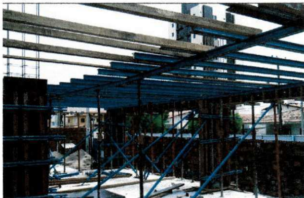
Figura 10– Vigas metálicas e escoras para laje
