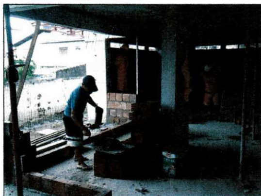
Figura 18 – Execução da alvenaria de vedação
