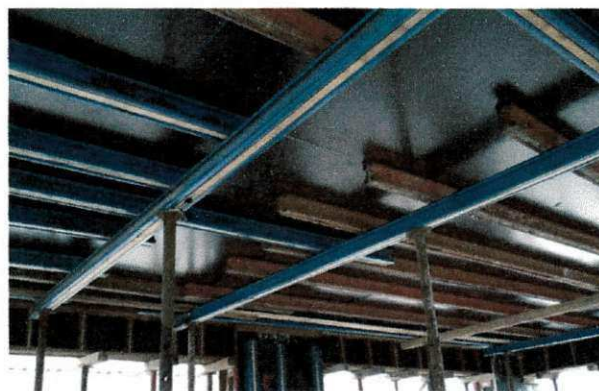
Figura 11 – Formas de madeira para laje
