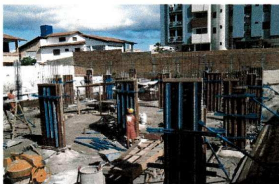
Figura 33 - Fôrmas e escoramentos para pilares
