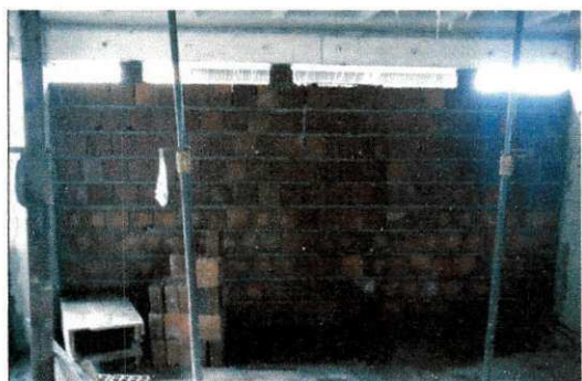
Figura 20 – Parede de tijolos cerâmicos
