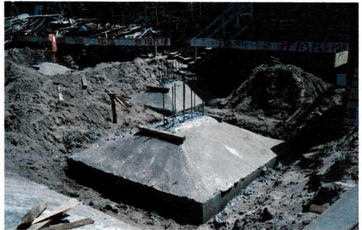
Figura 6 – Sapata pronta
