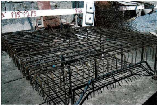
Figuras 41 – Armação da ferragem de uma sapata
