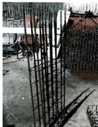
Figura 4 – Ferragem da sapata 2
