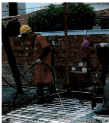
Figura 35 – Utilização do vibrador de imersão
