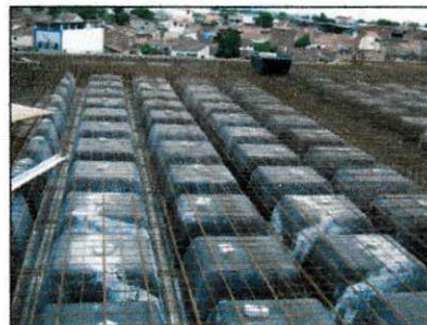
Figura 2 – Disposição das formas para laje nervurada.
