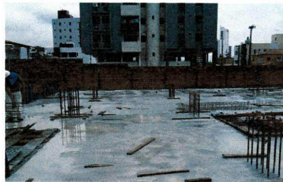
Figura 9 –Laje concretada
