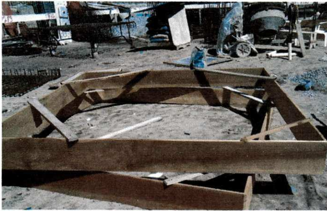
Figura 5 – Forma da sapata
