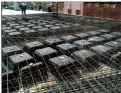
Figura 2 – Disposição das formas para laje nervurada.
