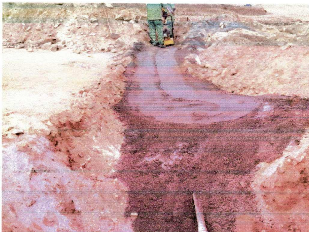
Figura 8 - Compactação mecânica do reaterro
