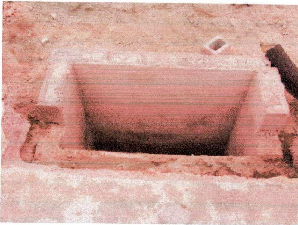
Figura 24 - Caixa de alvenaria para BL finalizada e rebocada
