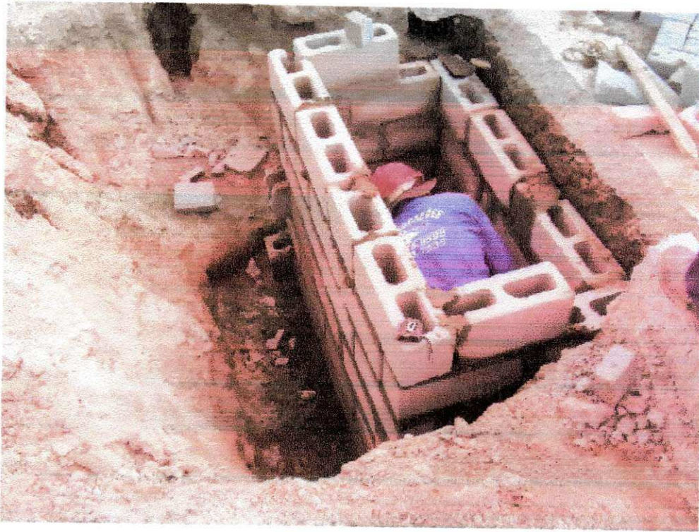
Figura 23 - BL em estágio avançado de construção
