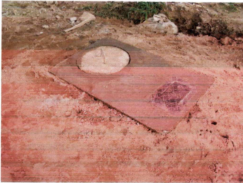
Figura 20 - Caixa de ligação concretada e acabada
