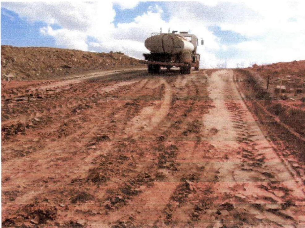
Figura 33 - Umidificação com caminhão pipa
