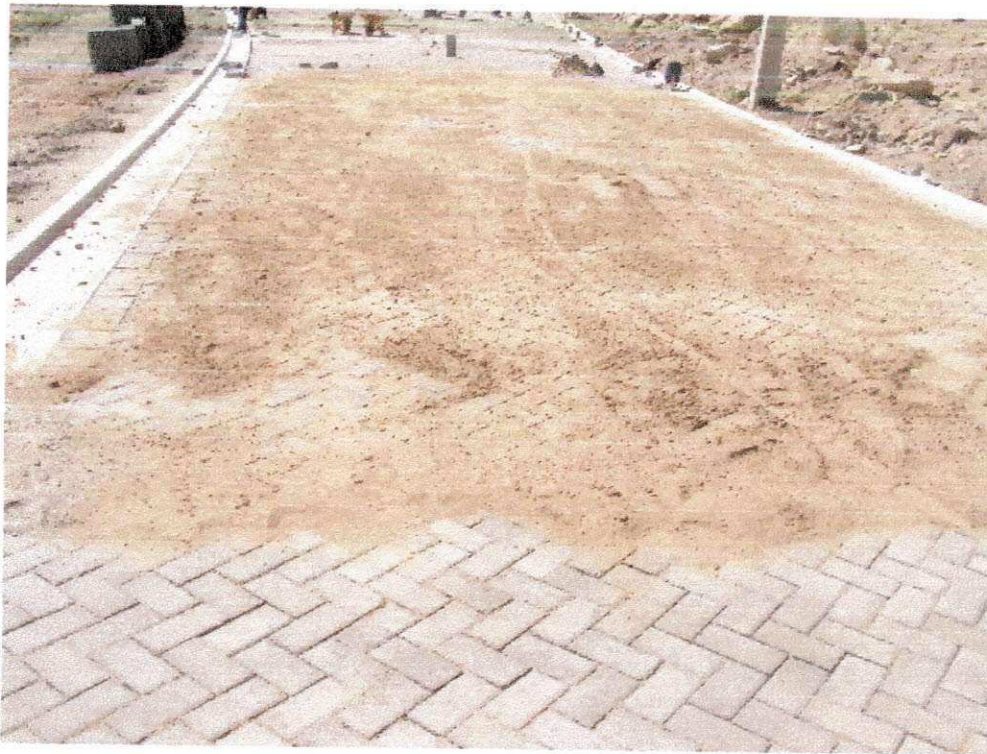
Figura 30 - Camada de areia para rejuntamento
