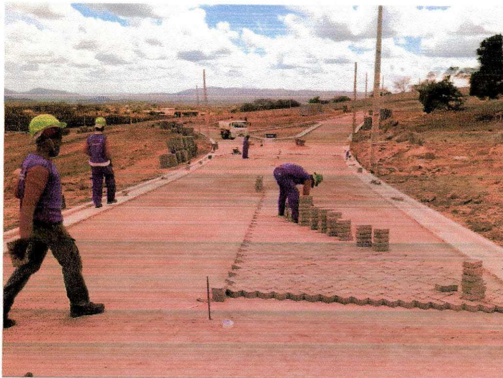
Figura 29 - Execução da pavimentação intertravada
