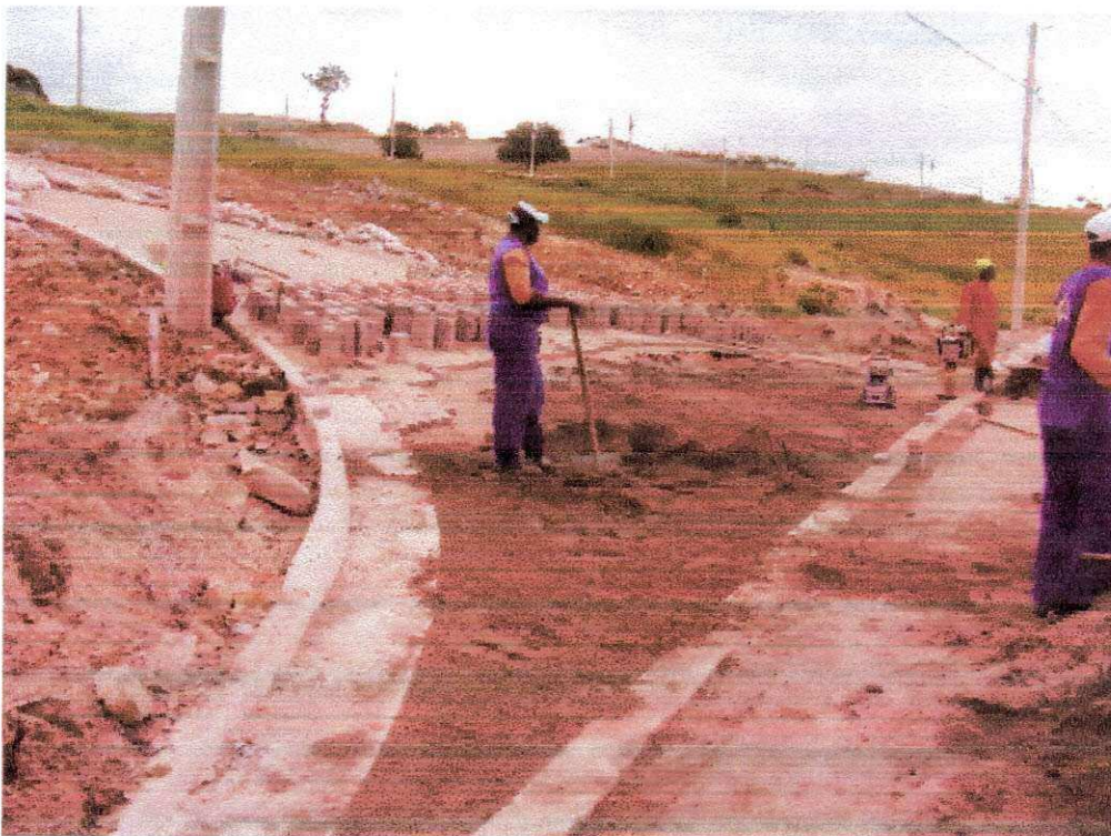
Figura 27 - Operários executando o colchão de Pó de Pedra
