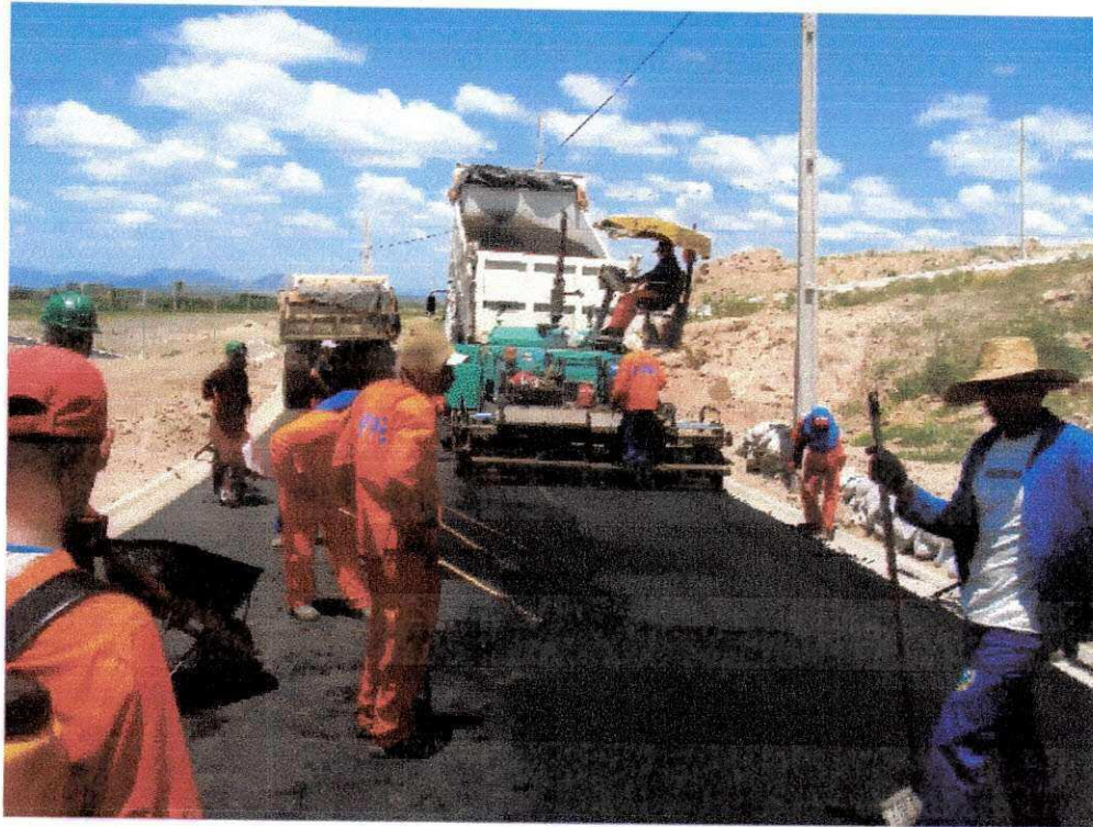
Figura 38 - Execução da camada de revestimento em CBUQ
