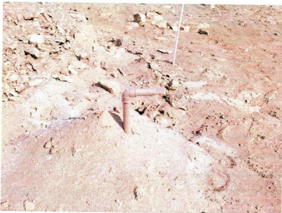
Figura 15 - Tubo de espera para água
