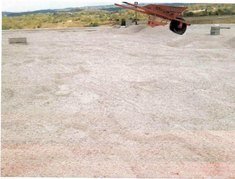
Figura 28 - Linha guia para execução da pavimentação
