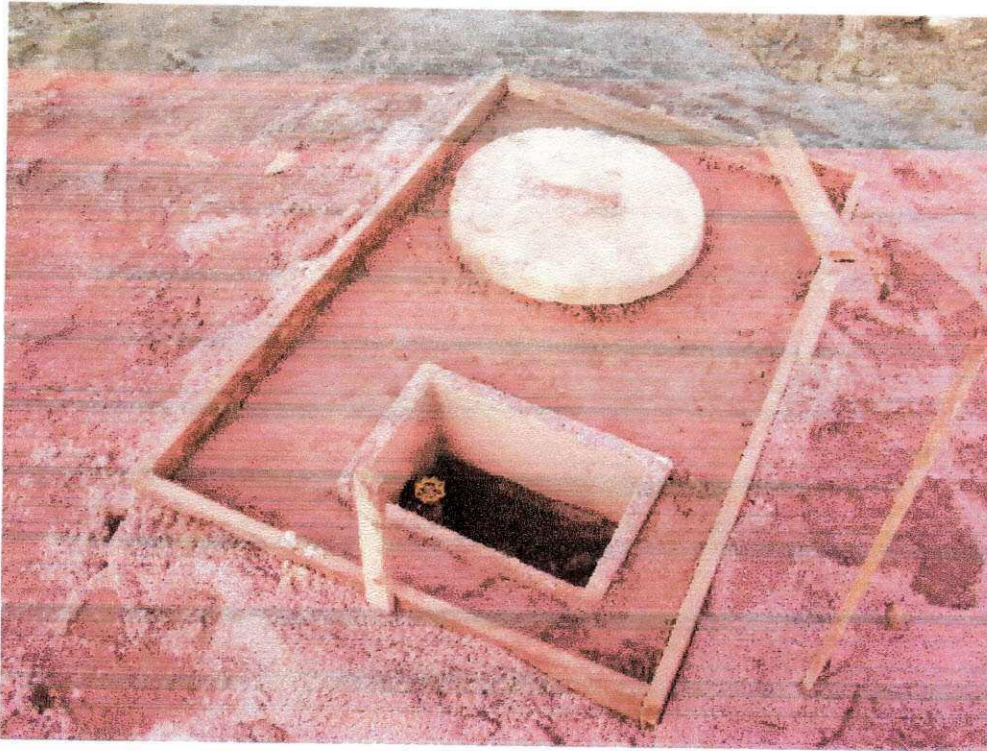
Figura 18 - Forma para concretagem das caixas de ligações domiciliares
