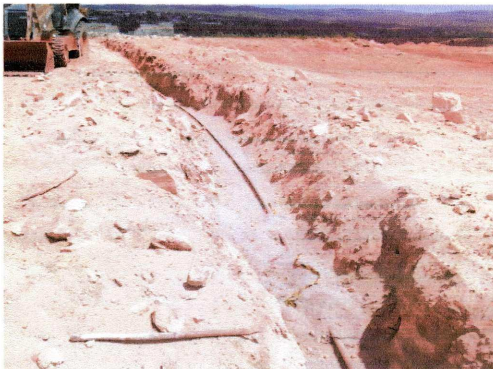
Figura 14 - Tubos assentados sobre colchão de Pó de Pedra
