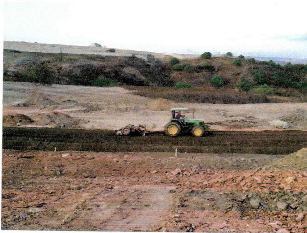
Figura 34 - Tratamento de camada com trator de hélice
