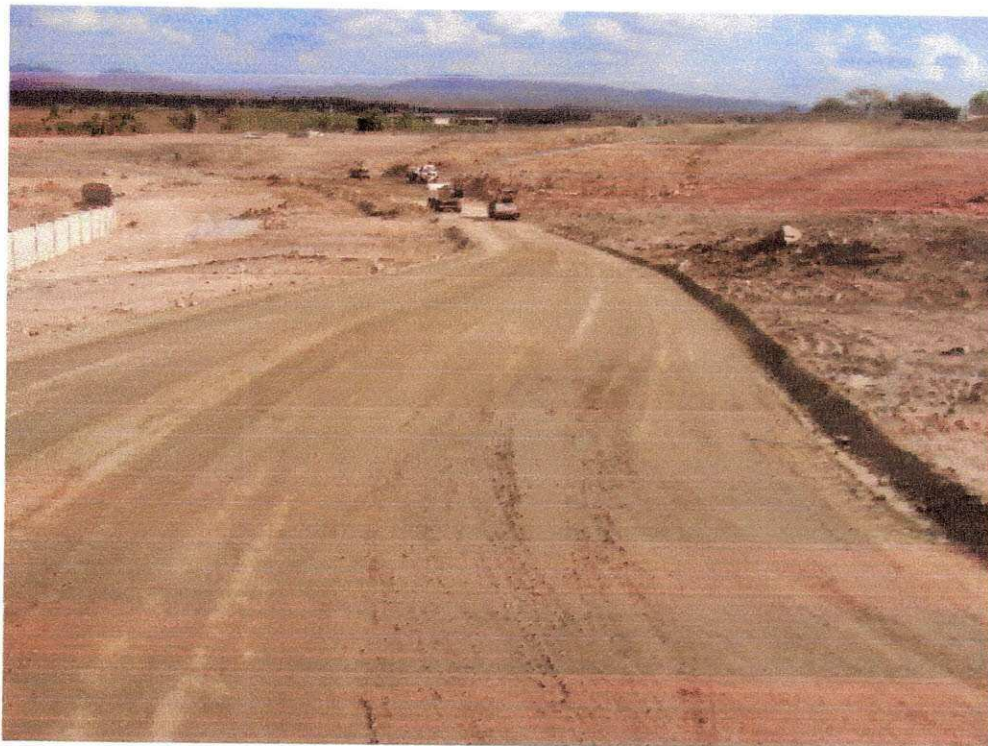
Figura 35 - Camada de subleito regularizada
