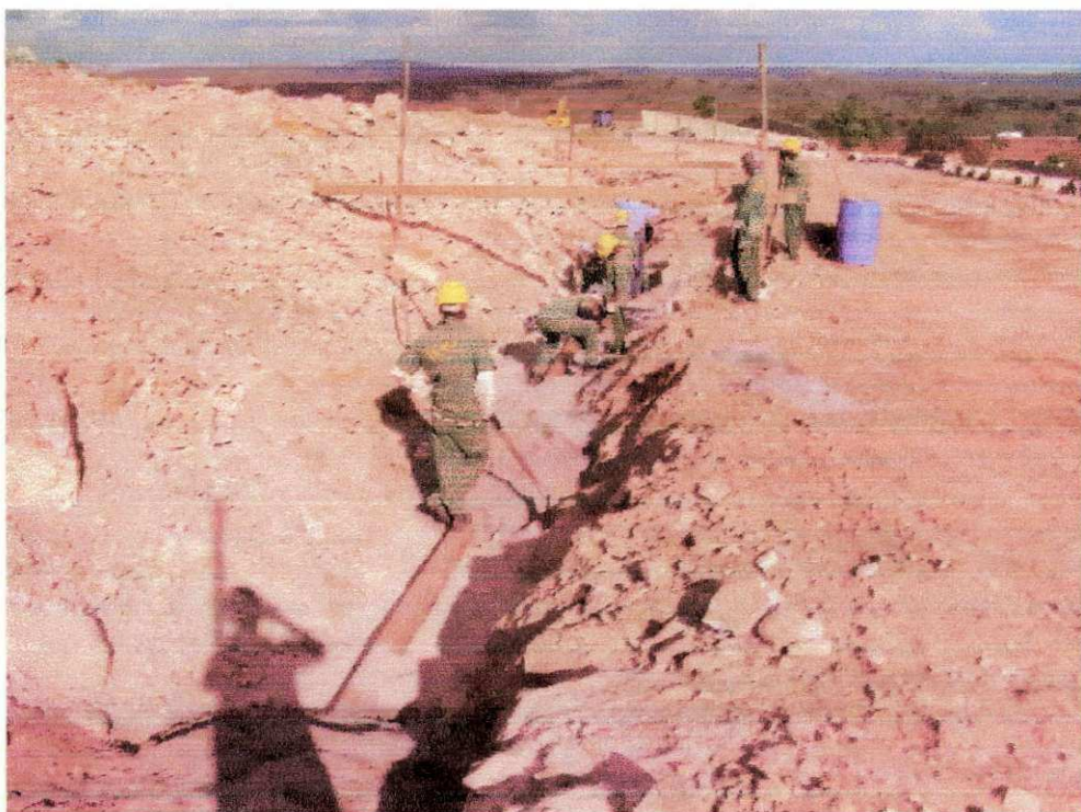
Figura 7 - Tubos de esgoto instalados e sendo reaterrados
