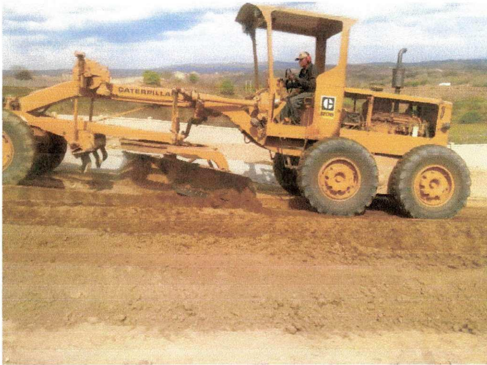
Figura 32 - Regularização do sub-leito com motoniveladora
