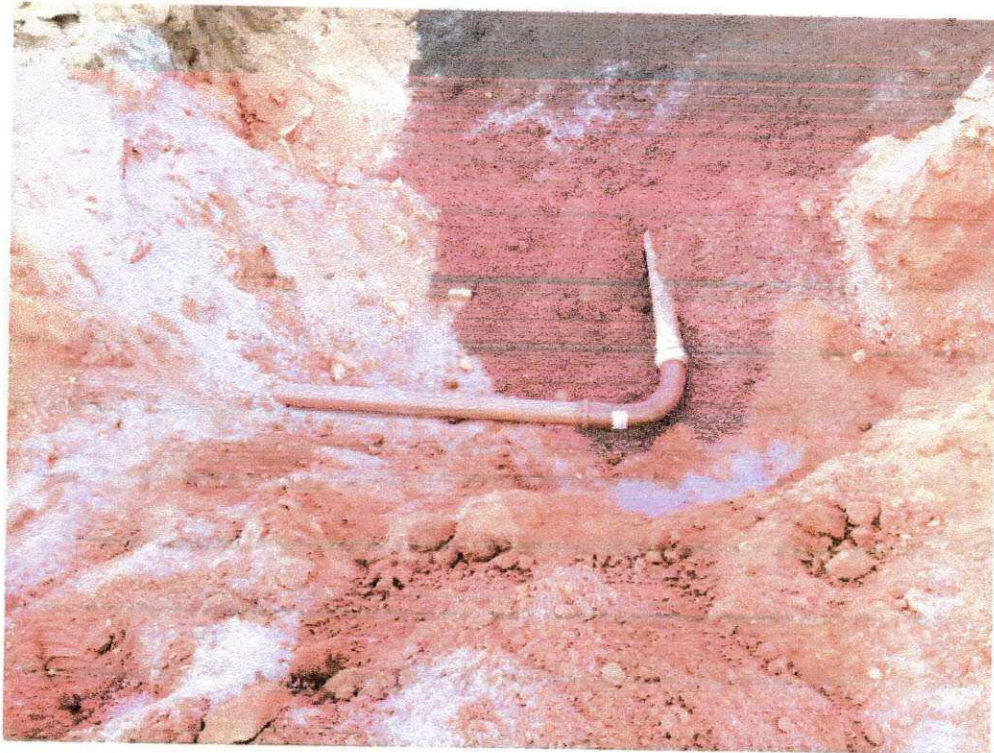
Figura 15 - Tubos reaterrados unidos por meio de Joelho de 90°
