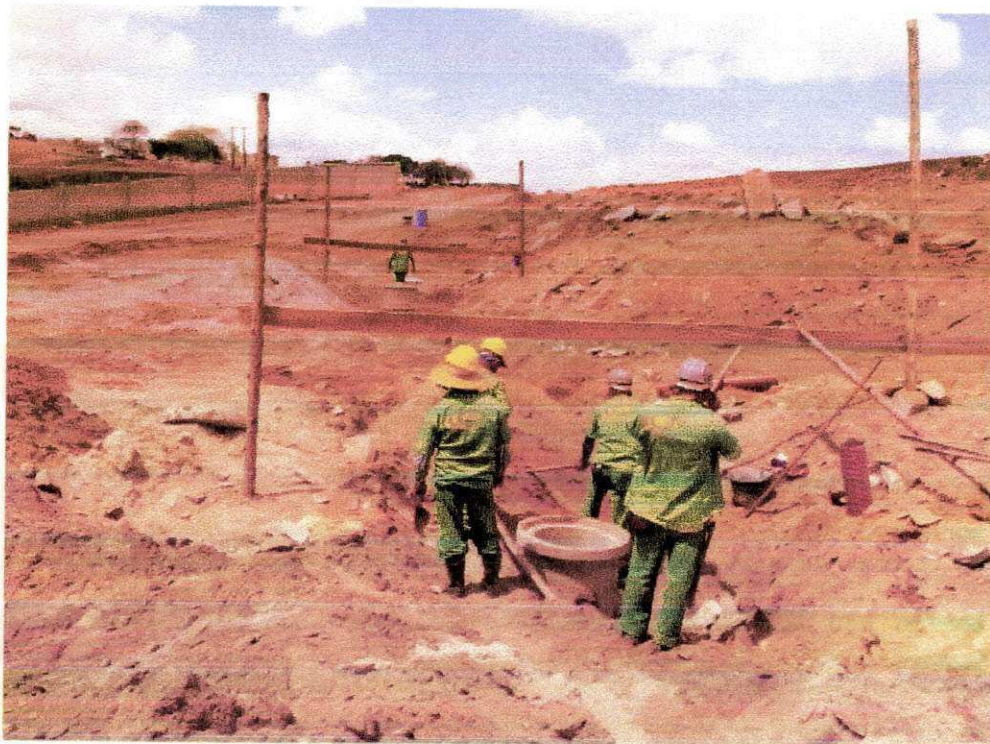
Figura 10 - Execução de PV
