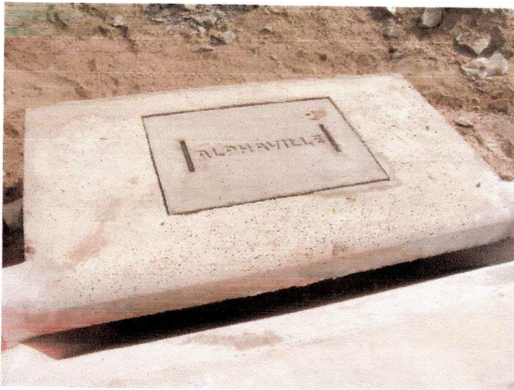
Figura 25 - BL já finalizada com a tampa
