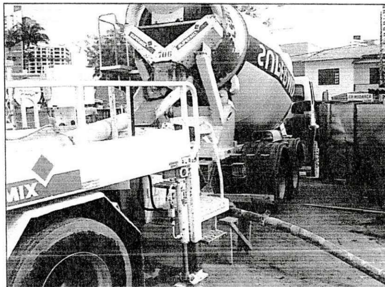
Figura 11 – Concreto usado em caminhão betoneira.
