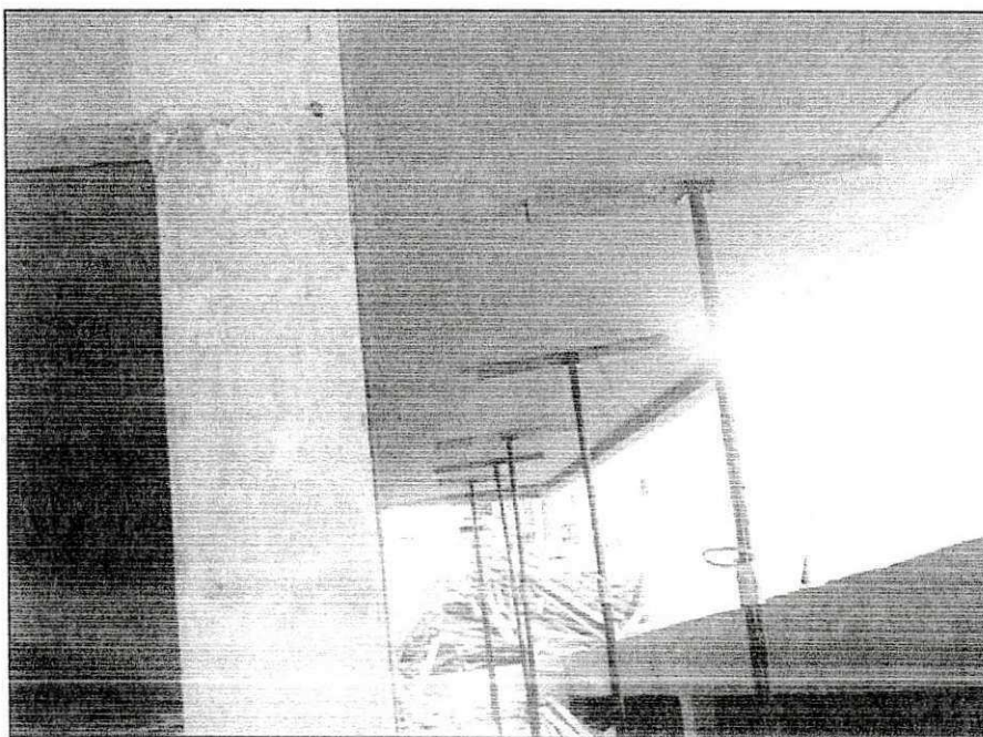
Figura 7 – Laje maciça do Anexo.
