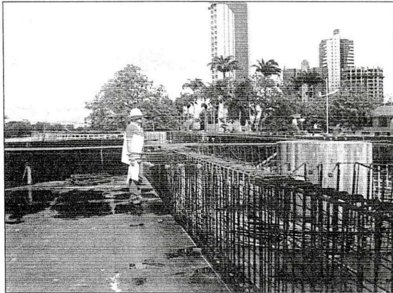
Figura 8 – Viga invertida do pavimento superior.
