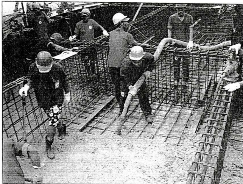
Figura 10 – Concretagem da laje inferior do pavimento superior.
