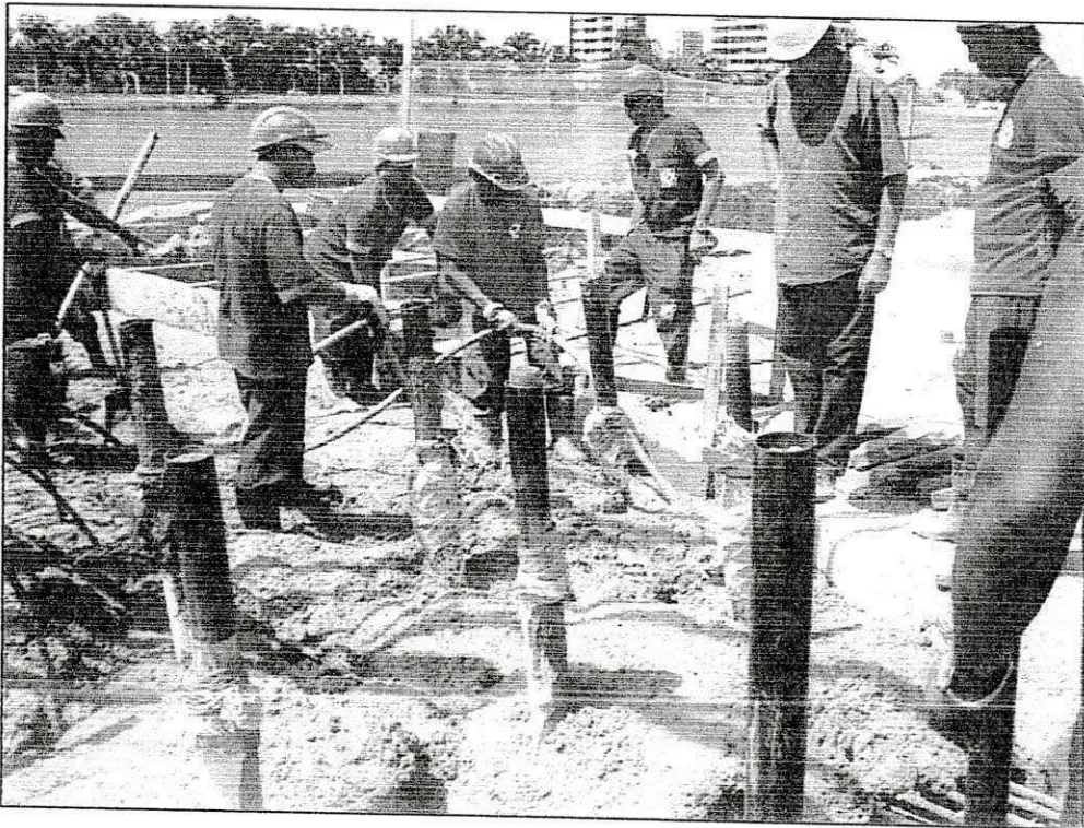
Figura 4 – Concretagem do bloco de fundação.
