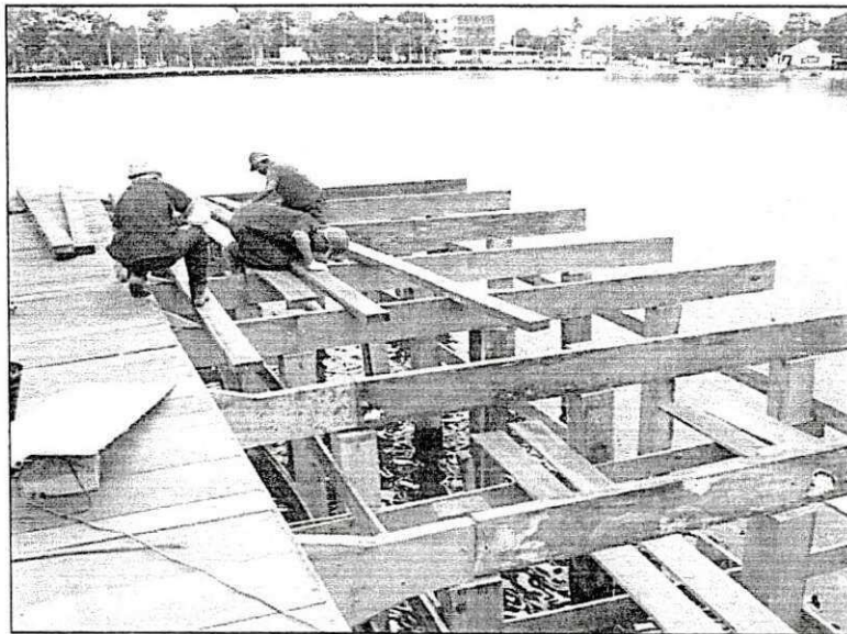
Figura 21 – Cravação das estacas para o assoalho.
