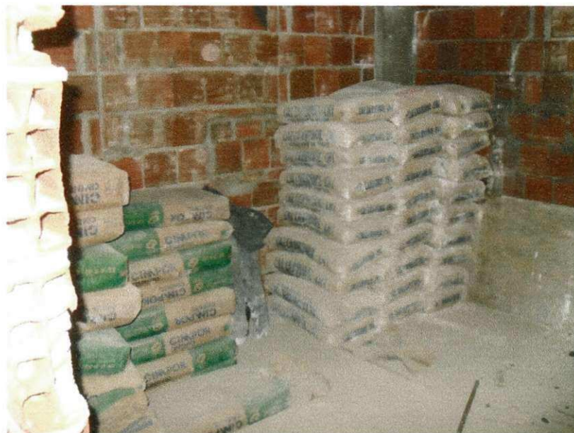
Foto 3 - Estocagem do cimento e cal
