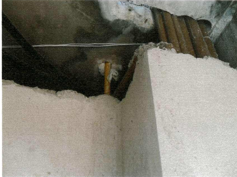
Foto 19 - Descida da tubulação de água fria
