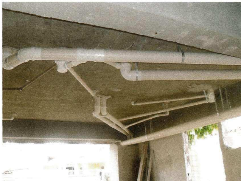
Foto 20 - Tubulação de esgoto
