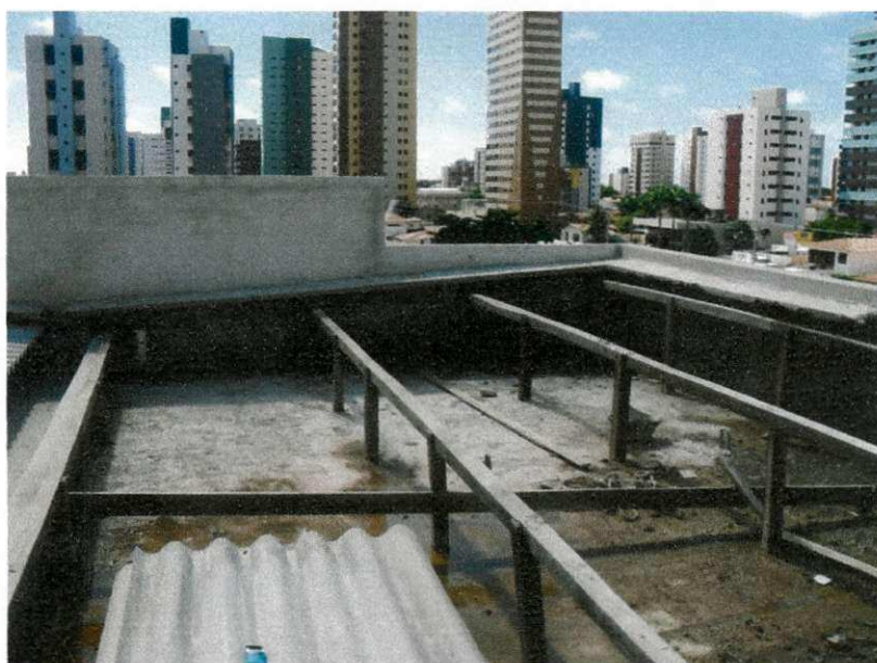
Foto 14 - Madeiramento para estrutura do telhado
