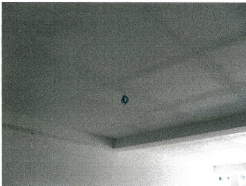
Foto 21 - Forro de gesso
