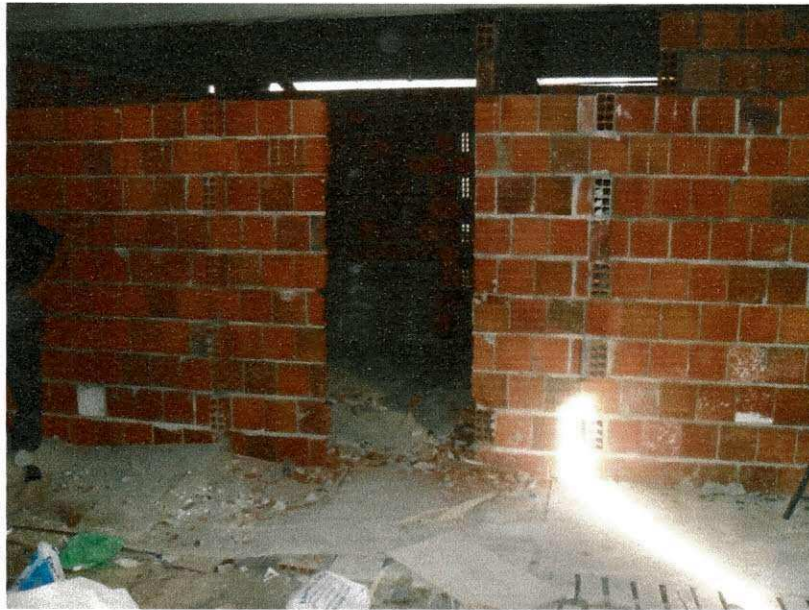
Foto 5 - Alvenaria de 1/2 vez
