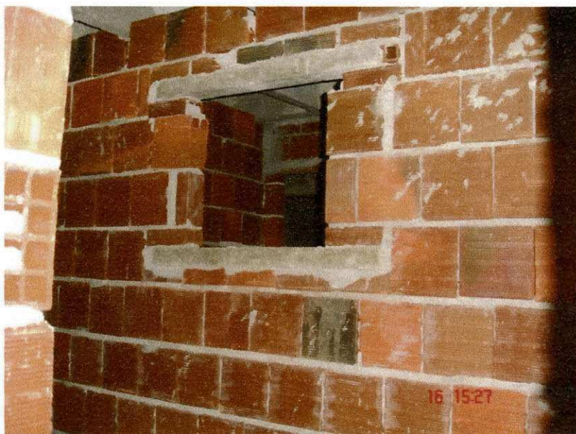
Foto 6 - Vergas e contra-vergas
