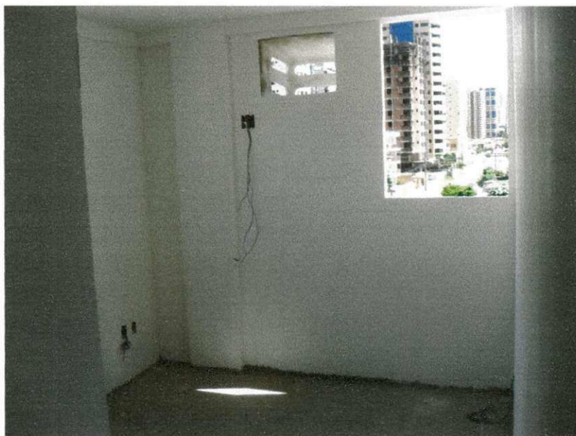
Foto 13 - Quarto com aplicação das duas camadas de massa corrida
