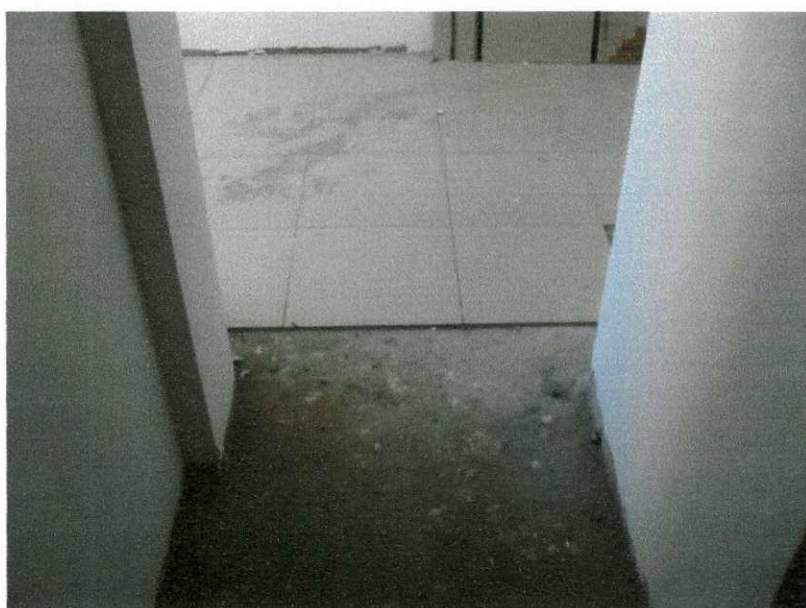
Foto 12 - Assentamento do porcelanato
