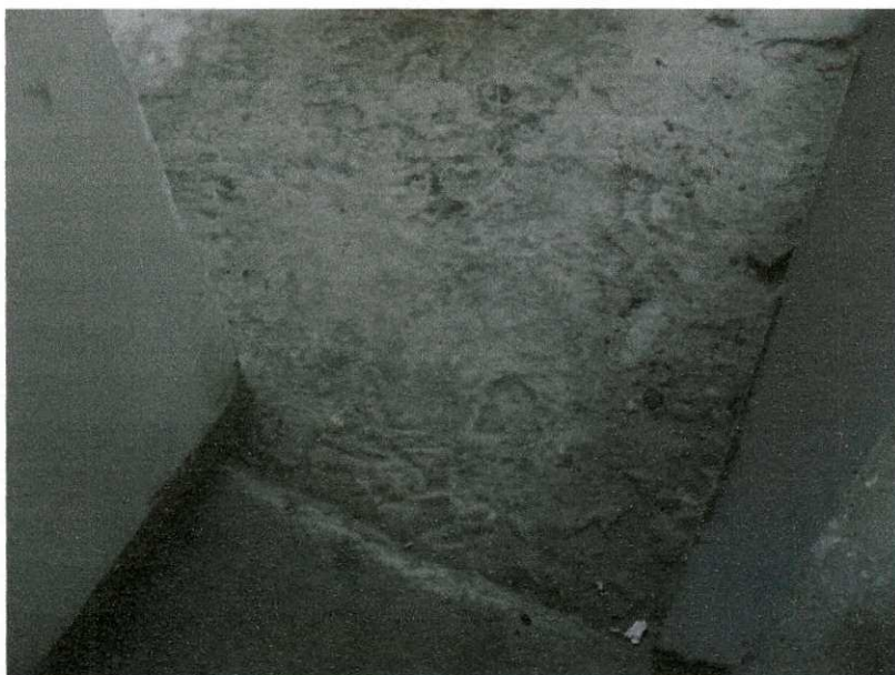
Foto 11 - Área de transição entre o contra-piso acabado e laje sem contra-piso
