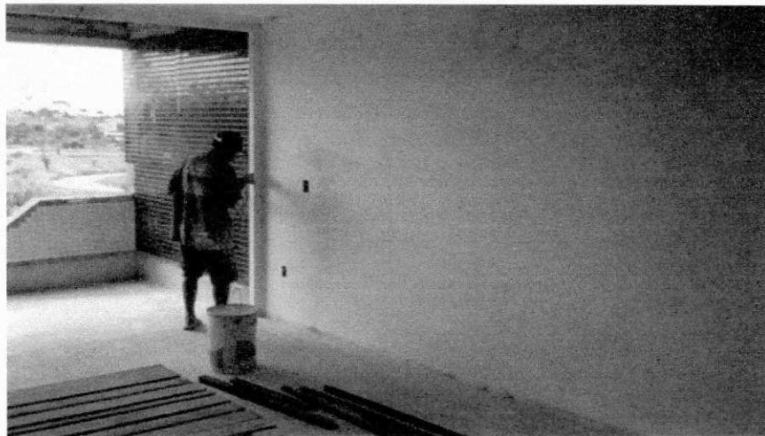
Foto do pintor passando a massa corrida colar em um Aptº 202. Autor da Foto: Leonardo Eudes
