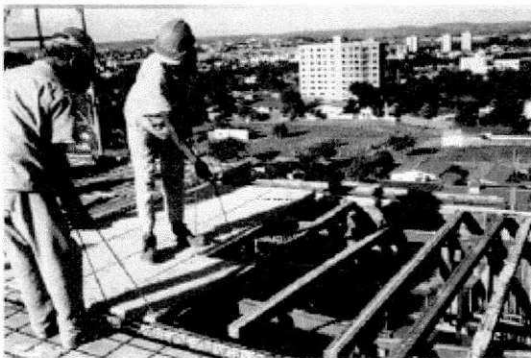
Fig 7.2.1.c Colocação dos elementos pré-moldados
