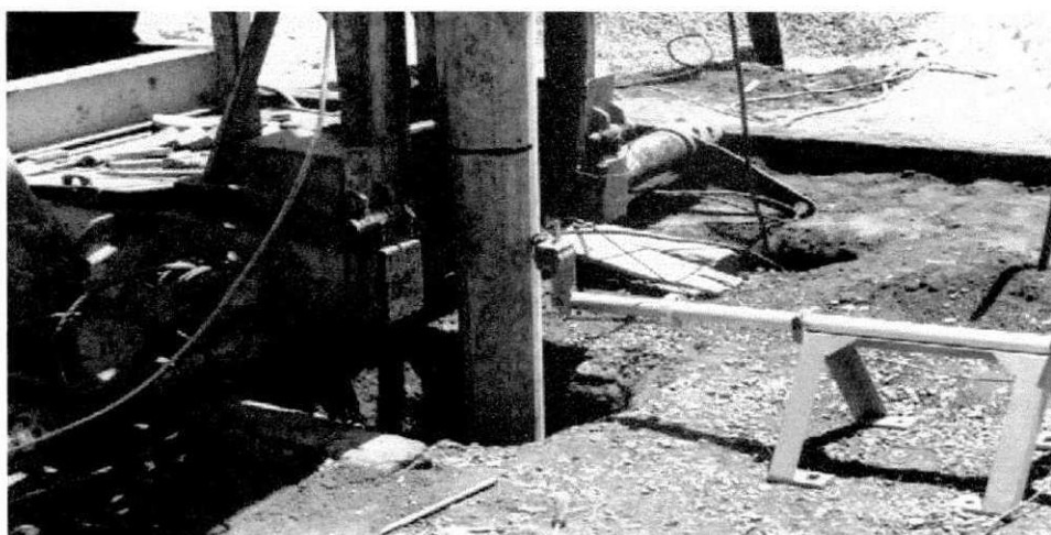
Cravação de estaca pré-moldada.
