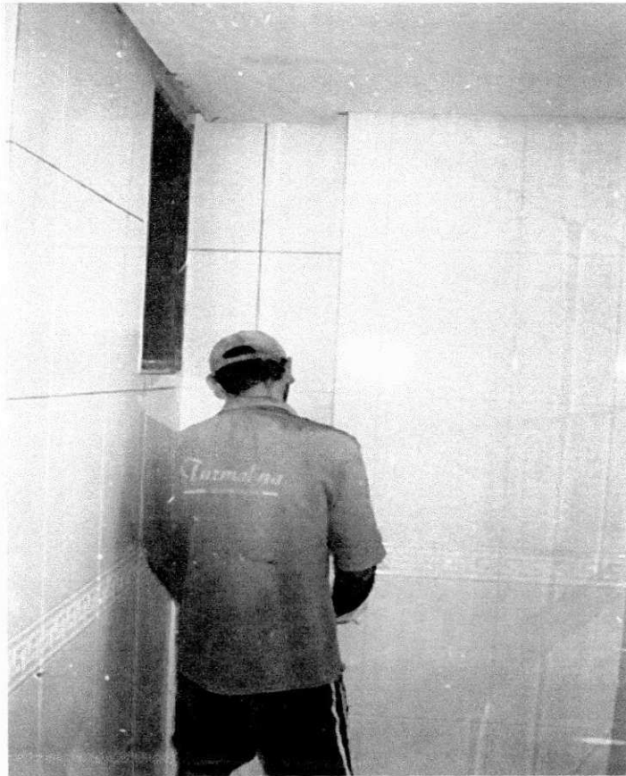
Foto 09: Aplicação do Revestimento Cerâmico Autor da Foto: Leonardo Eudes
