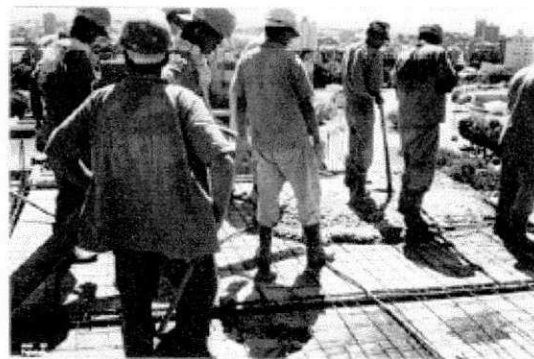
Fig 7.2.1.c Colocação dos elementos pré-moldados
