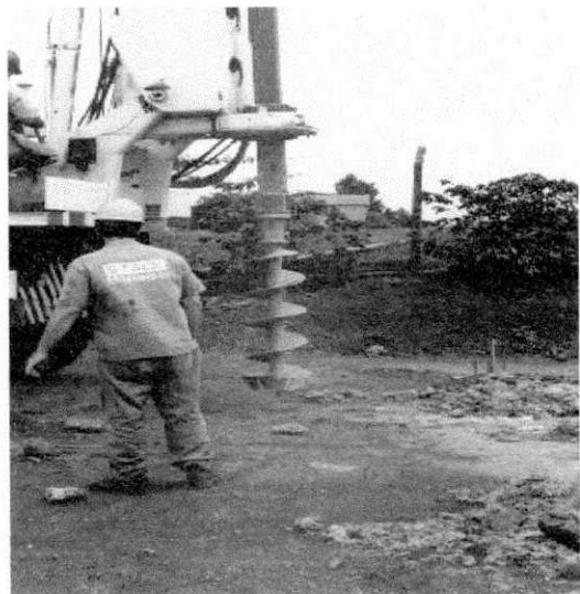
Detalhe do elemento de escavação.
