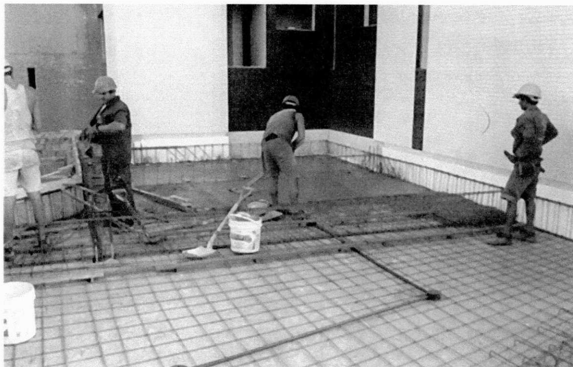
Foto 4: Concretagem da Laje do Deck Autor da Foto: Leonardo Eudes
