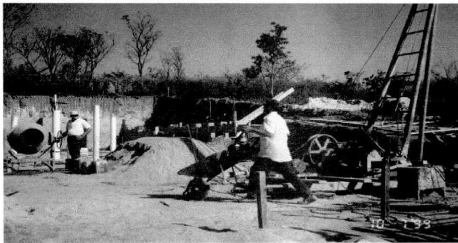
Execução de estaca Strauss.
