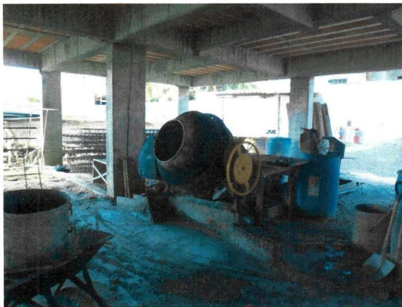
Figura 8 – Betoneira e local apropriado no canteiro, destinados ao preparo de concreto e argamassa.
