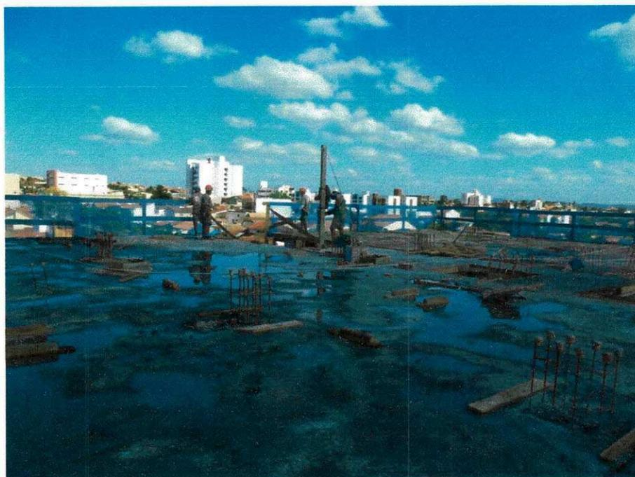
Figura 17 – Laje umedecida para auxiliar no processo de cura.
