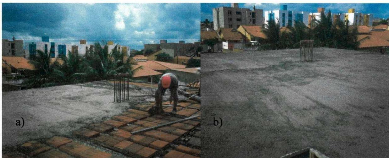
Figura 16 – a) Nivelamento da laje com régua; b) Laje concretada.
