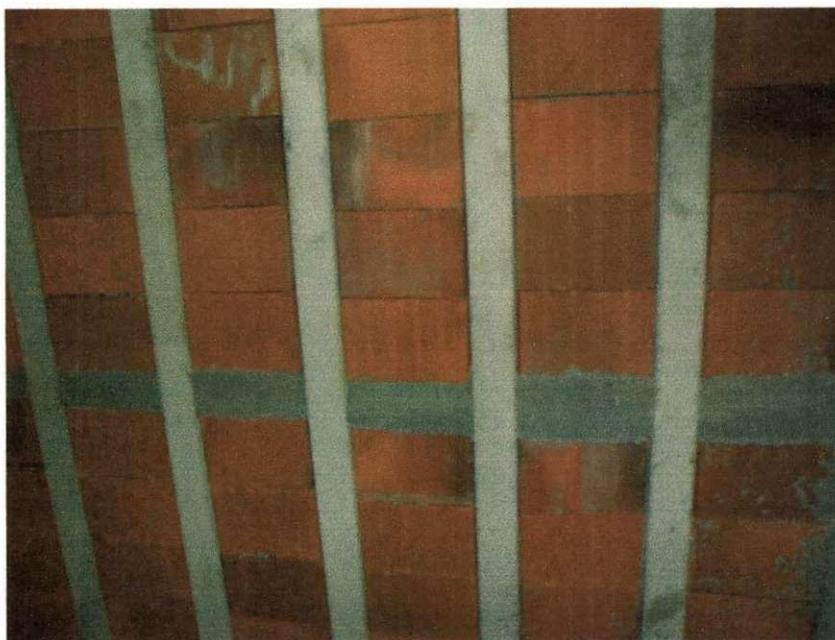
Figura 9 – Disposição da laje, em trilhos, blocos e viga-chata.
