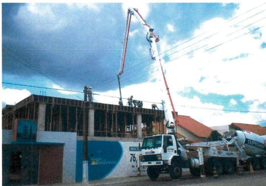
Figura 13 – Chegada do caminhão betoneira de concreto na obra.
