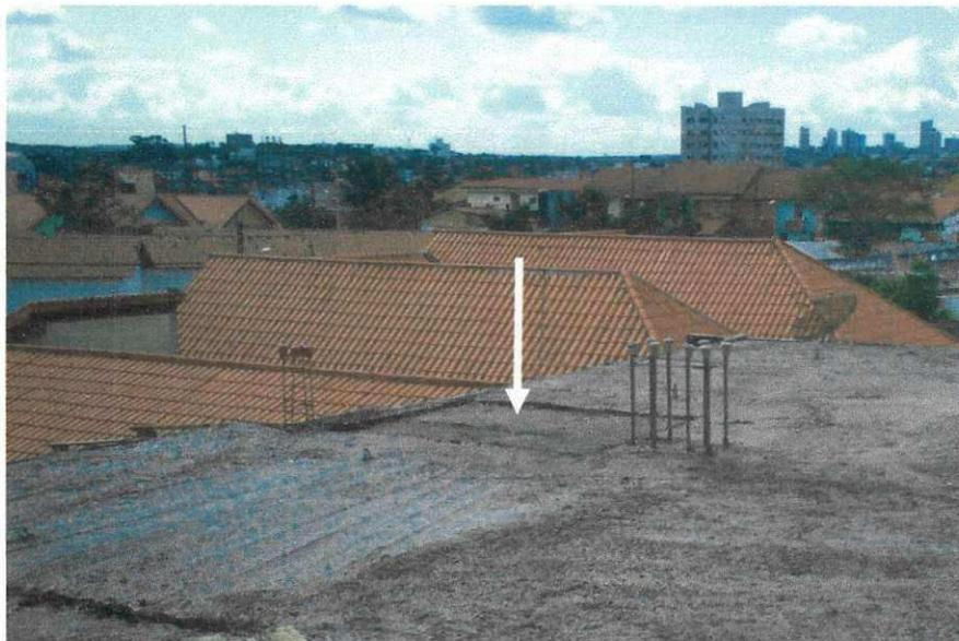
Figura 12 – Depressão no volume de concreto para áreas do banheiro.
