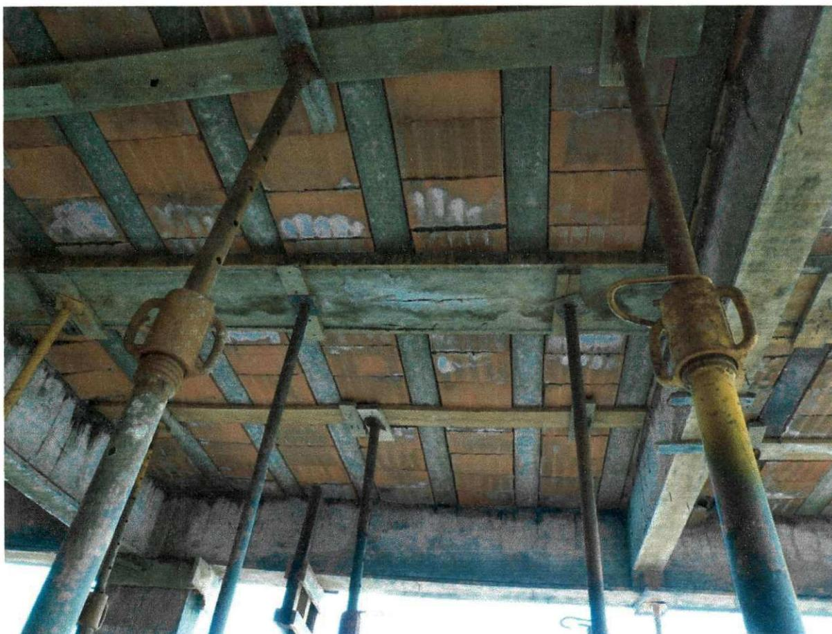
Figura 10 – Escoras metálicas para uso nas lajes.
