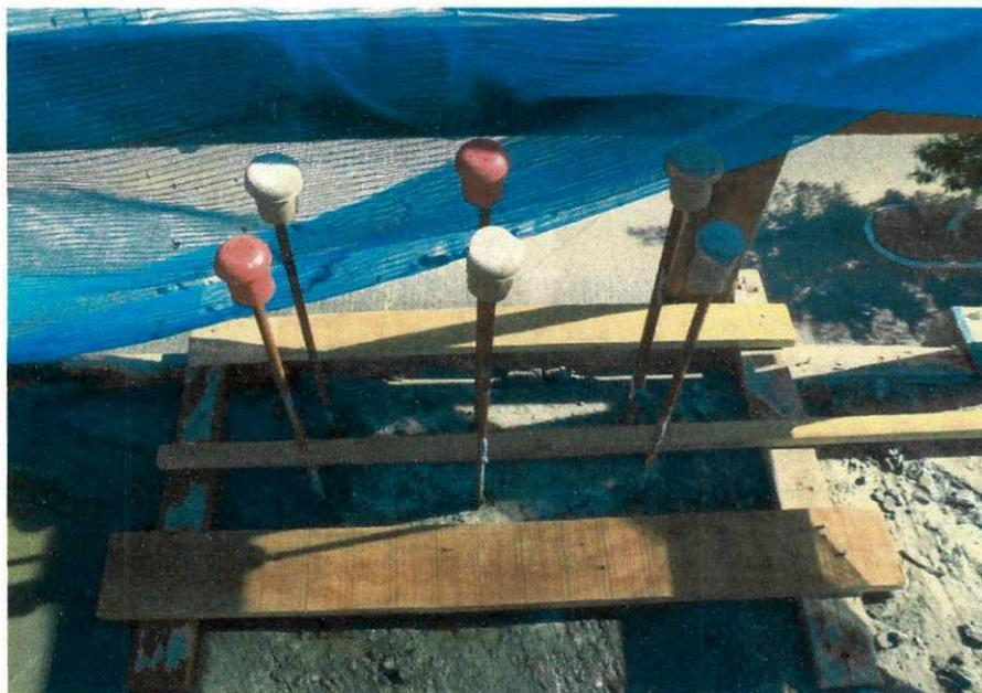
Figura 14 – Proteção das esperas de ferros e tela de proteção para a laje.
