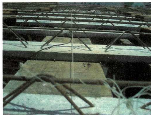
Figura 2.27 – Linha de náilon acima da laje
