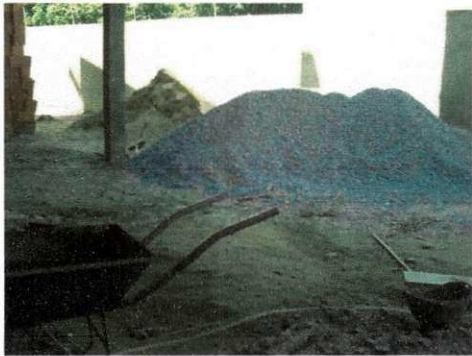
Figura 1.0 – Armazenamento de areia e brita
