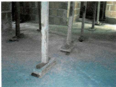
Figura 2.11 – Detalhe de cunhas sob pontaletes
