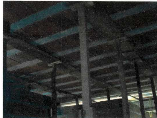
Figura 2.22 – Espaçamento das vigas chatas
