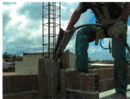
Figura 2.34 – Adensamento em pilar
