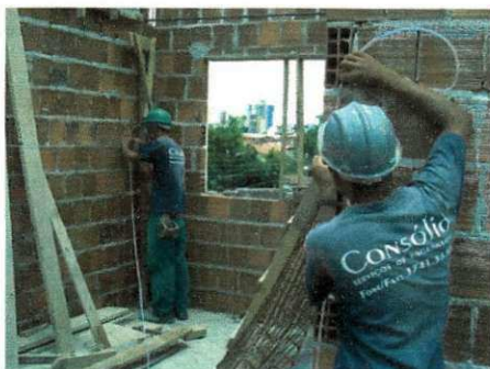
Figura 2.13 – Transferência de nível
