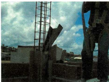
Figura. 2.30 –Funil para concretagem em pilar
