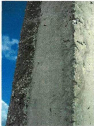
Fig. 3.13 – Pilar chapiscado
