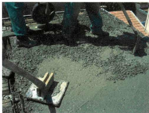
Fig. 2.39 – Nivelamento com “pé de pinto”
