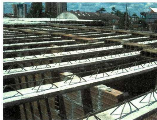
Figura 2.20 – Espaçamento das vigotas
