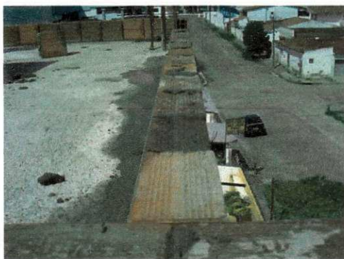
Fig. 3.4 – Marcação da fachada
