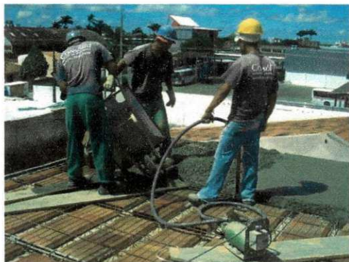
Fig. 2.38 – Lançamento do concreto
