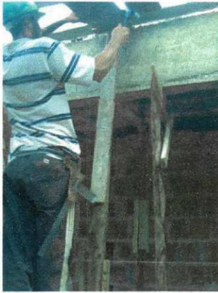
Figura 2.24 – Posicionamento da escora central
