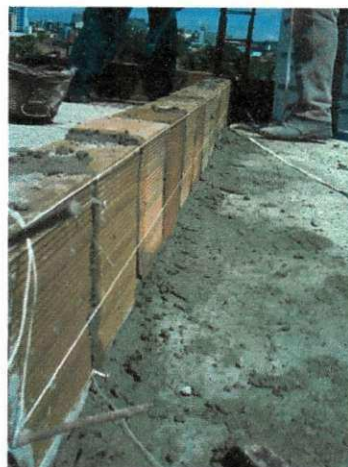
Fig. 3.7 – Fiada completamente assentada
