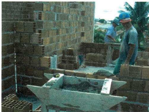
Fig. 3.9 – Levantamento da alvenaria
