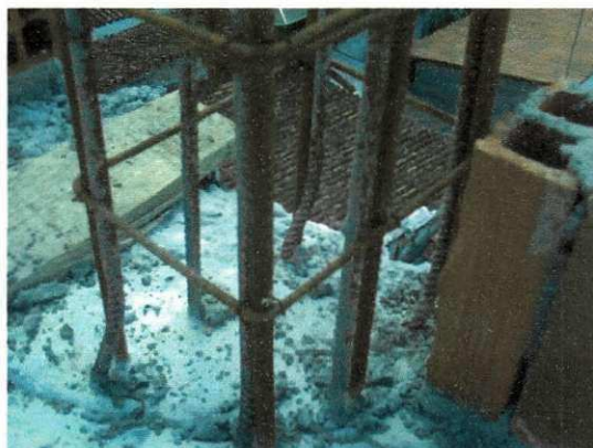
Figura 2.35 – Arranques usados como referência
