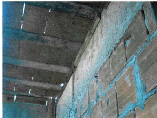
Figura 2.23 – Fechamento de fendas na laje
