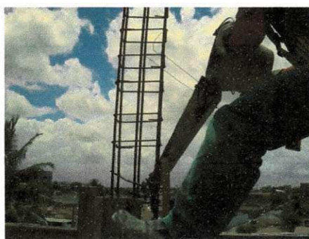
Figura 2.31 – Lançamento do concreto em pilar
