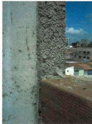
Fig. 3.14 – Fixação do tijolo
