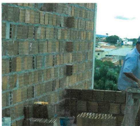
Fig. 3.11 – Detalhe: Tijolos salientes
