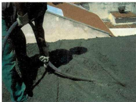
Fig. 2.33 – Adensamento em laje
