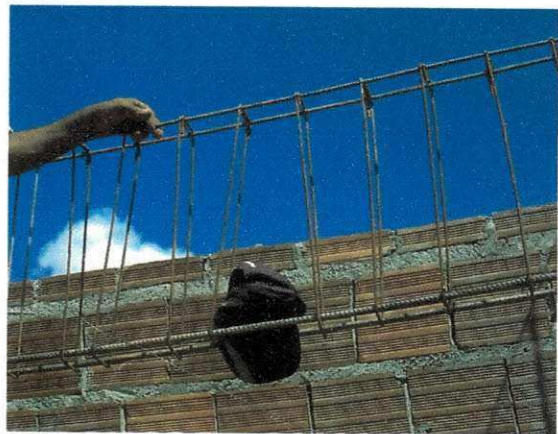
Figura 2.5 – Montagem da armadura da viga
