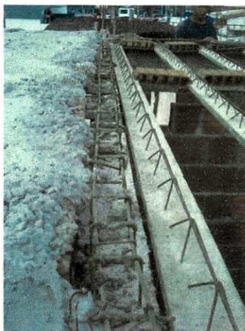
Figura 2.19 – Colocação das vigotas
