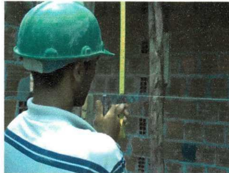
Figura 2.25 – Aferição do nivelamento
