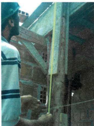
Fig. 2.26 – Contra-flecha em pontalete extremo
