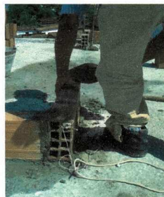
Fig. 3.5 – Assentamento dos blocos
