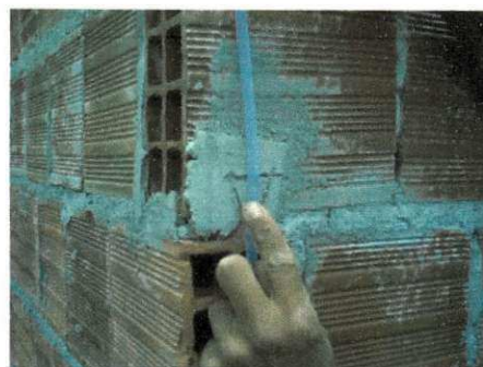
Figura 2.14 – Nível materializado
