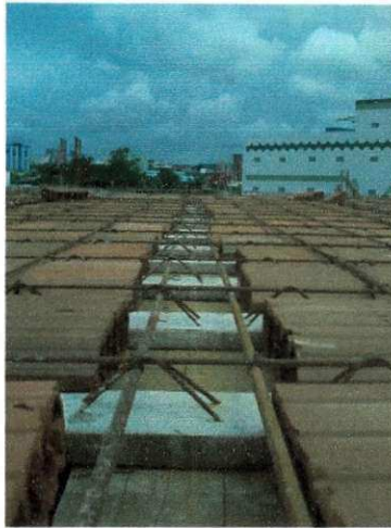
Figura 2.21 – Retirada de blocos para viga chata
