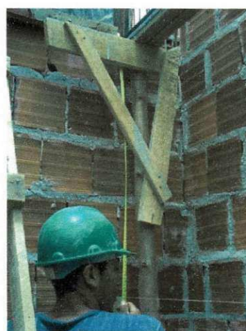
Figura 2.16 – Nivelamento da viga
