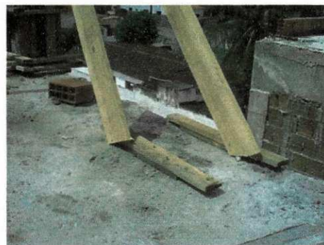
Figura 2.8 – Detalhe do apoio das escoras
