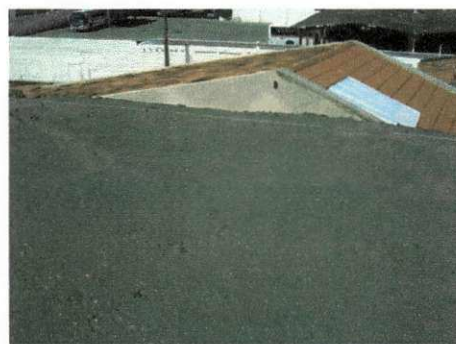
Figura 2.37 – Linha definindo nível da laje
