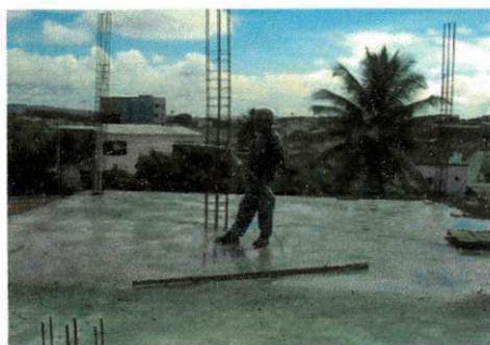
Fig. 2.40 – Cura do concreto
