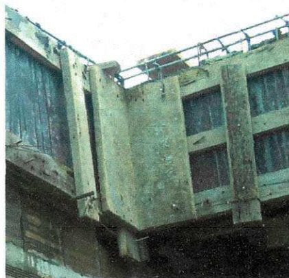
Figura 2.10 – União entre fôrmas
