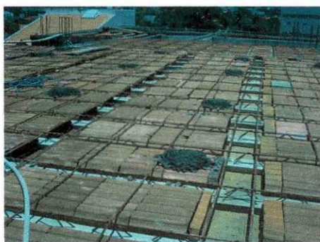
Fig. 2.36 – Mestras para concretagem
