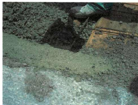
Figura 2.29 – Argamassa na junta da laje
