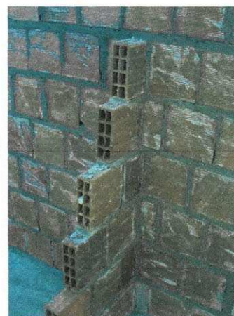
Fig. 3.12 – Amarração entre paredes
