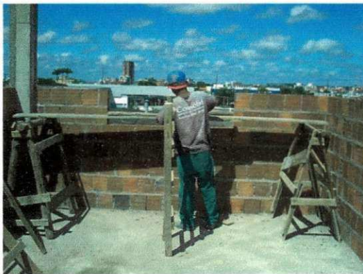
Fig. 3.15 – Detalhe: vão de janela deixado em aberto
