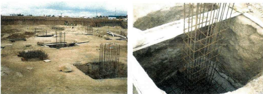
Figura 7 e Figura 8 – Disposição e detalhamento dos pilares.
