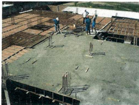
Figura 15 – Concretagem de laje.
