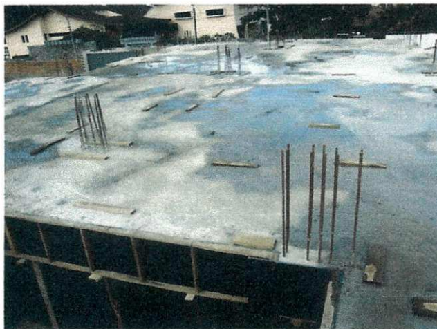
Figura 16, Figura 17 e Figura 18 – Laje concretada.
