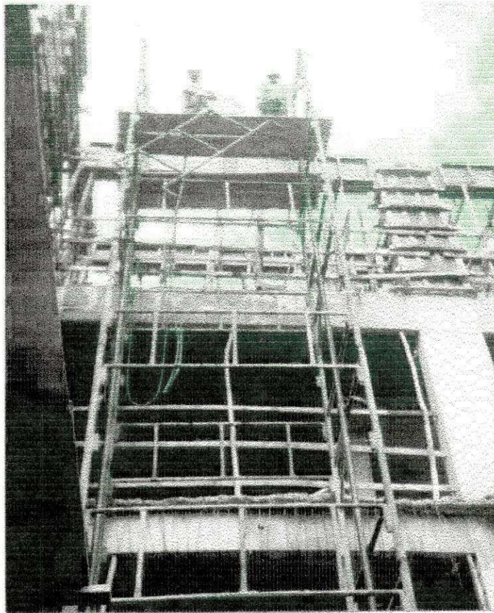
Fig. 12 – Torre para o elevador.
