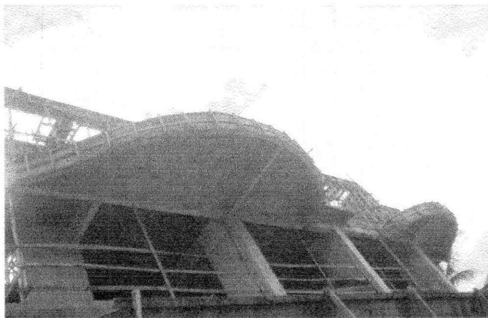
Fig. 06 – Varandas do pavimento tipo.
