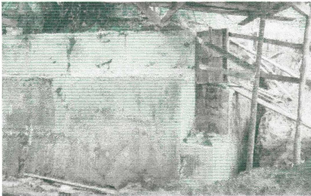
Fig. 09 – Muro de arrimo.
