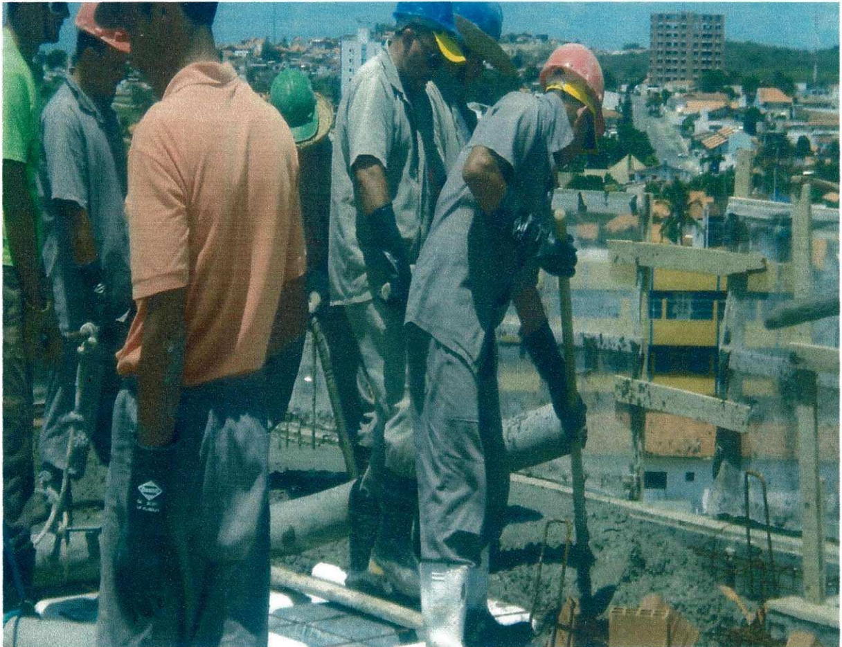
Figura 01 - Concretagem da Laje
