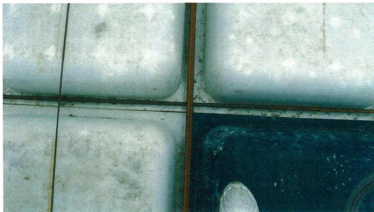
Figura 08 – Detahe Ferragem da Laje
