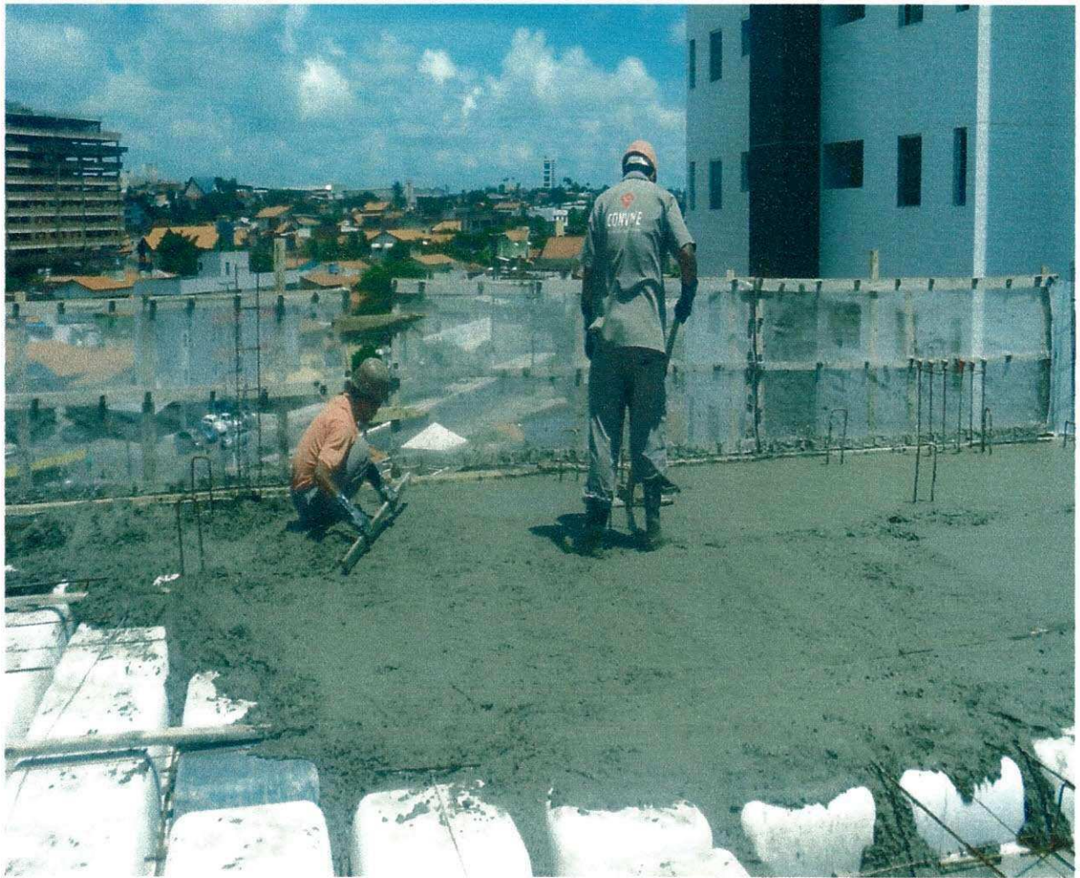
Figura 03 - Concretagem
