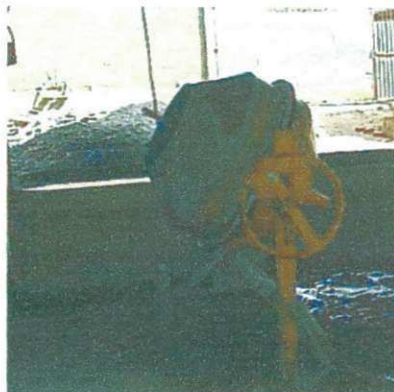
Figura 42. Processo de fabricação do concreto “in locu”
