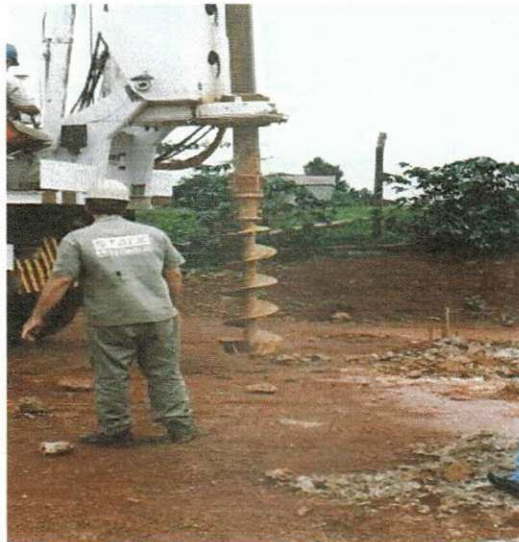
Detalhe do elemento de escavação.
