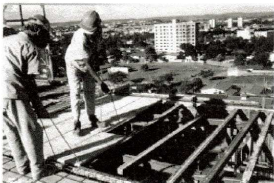
Fig 7.2.1.c Colocação dos elementos pré-moldados
