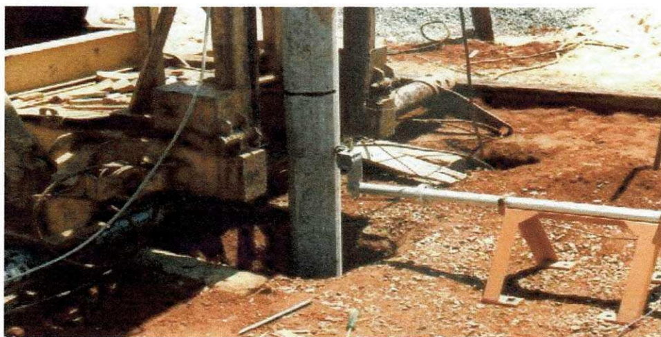
Cravação de estaca pré-moldada.
