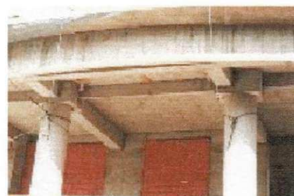
Figura 7.2.1.b Laje maciça e blocos de transição
