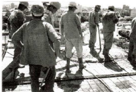
Fig. 7.2.1.d Lançamento do concreto
