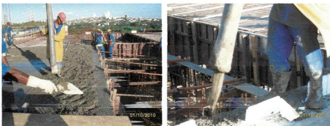
Figura 30: Execução de concreto dosado em central
