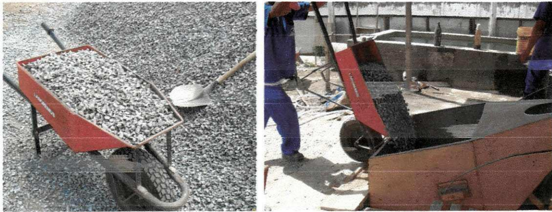
Figura 26: Dosagem de agregado graúdo
