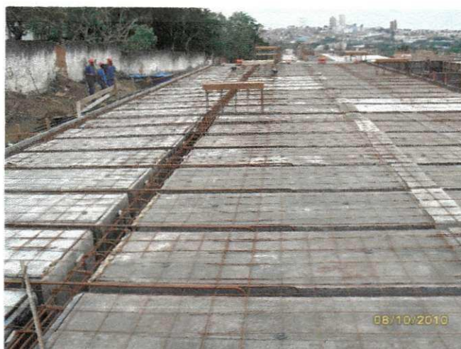
Figura 34: Laje pronta para concretagem
