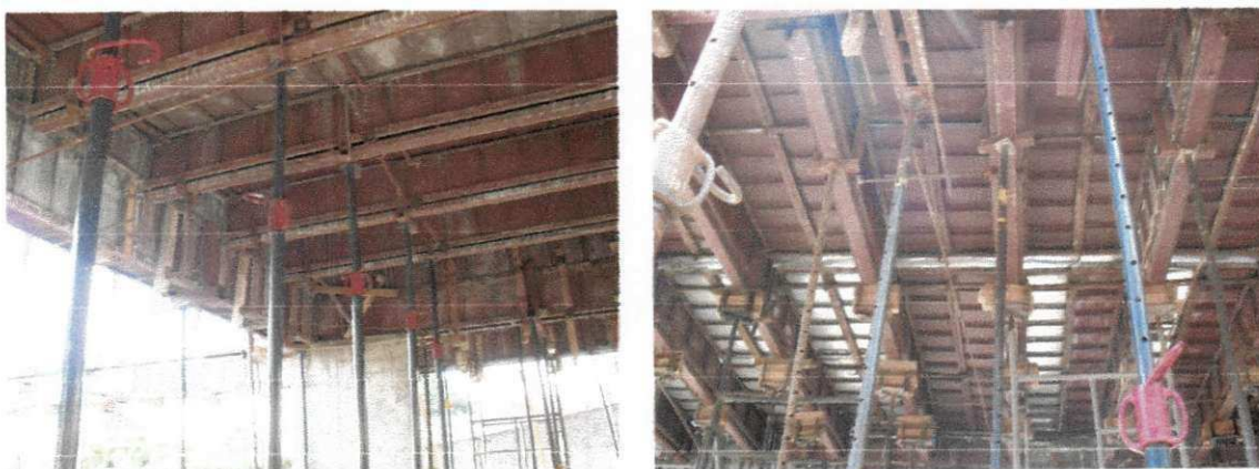
Figura 12: Fôrma de laje pavimento tipo da obra (vista inferior)
