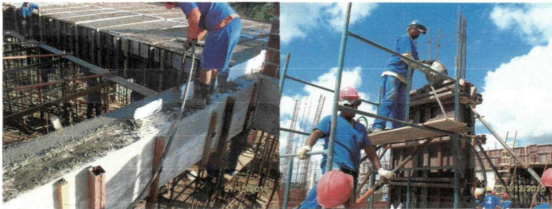
Figura 31: Concretagem de viga e pilar
