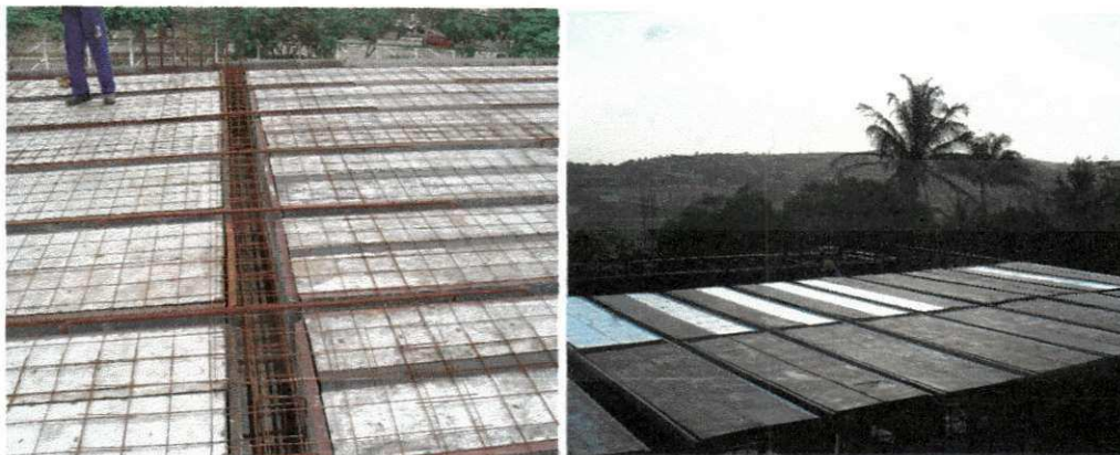
Figura 11: Fôrma de laje pavimento tipo da obra (vista superior)
