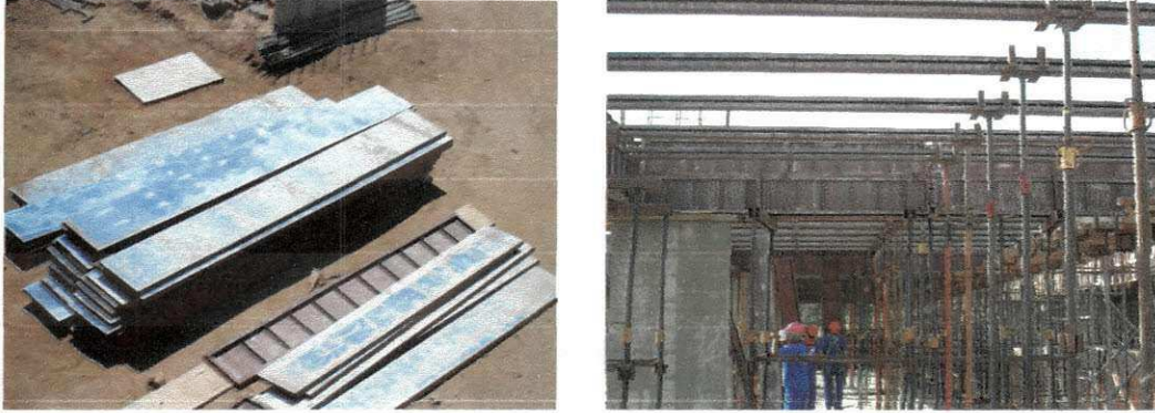
Figura 18: Detalhe de painéis e fundo de vigotas
