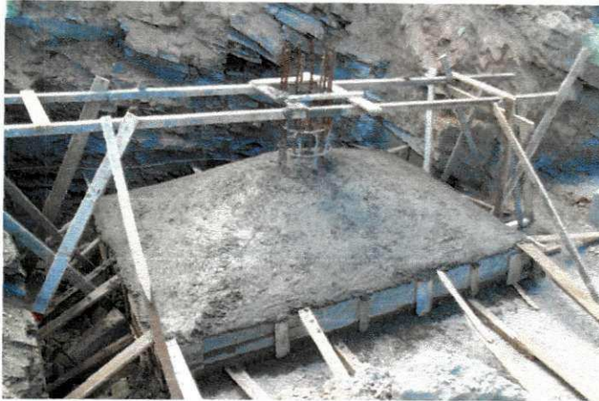
Figura 9: Sapata de fundação da obra
