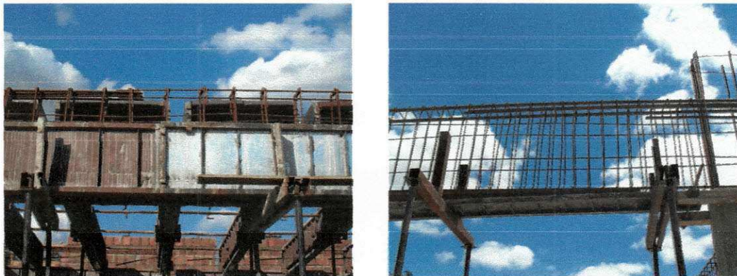
Figura 13: Fôrma de viga e detalhe das ferragens de viga
