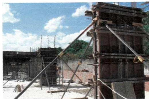
Figura 16: Montagem das fôrmas de pilar e a mesma pronta para concretagem
