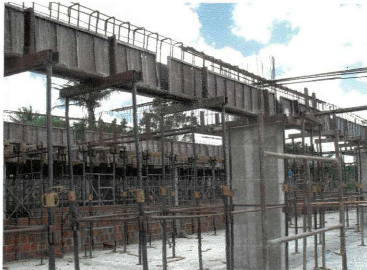
Figura 14: Fôrma de viga e escoramento
