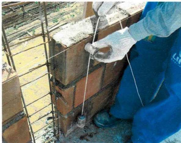
Figura 47: Verificação de prumo da alvenaria
