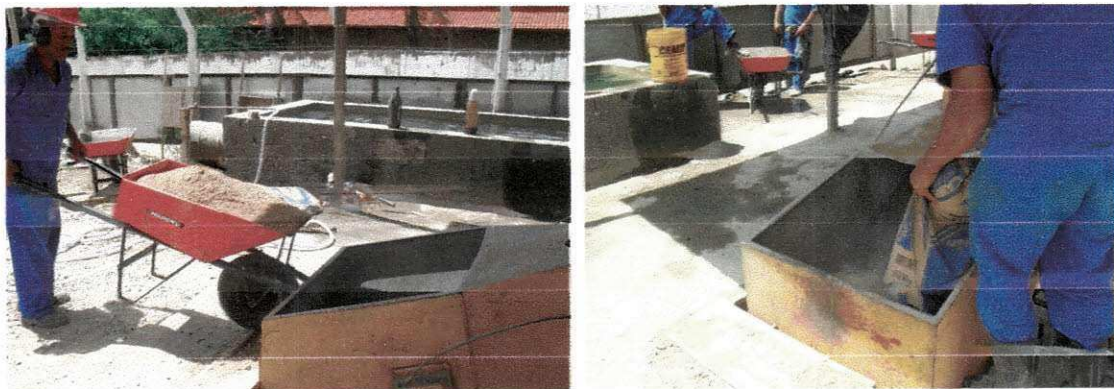
Figura 27: Dosagem de agregado miúdo
