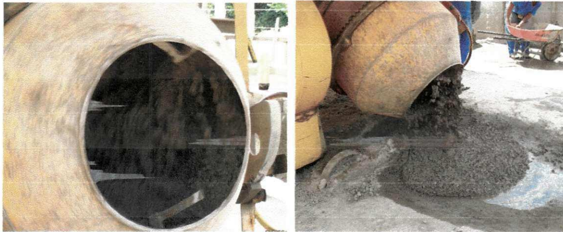
Figura 28: Mistura dos matérias componentes do concreto em betoneira e o mesmo pronto
