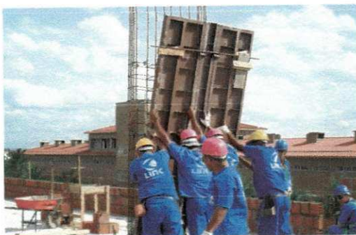
Figura 16: Montagem das fôrmas de pilar e a mesma pronta para concretagem
