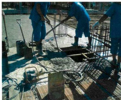
Figura 46. Uso do vibrador
