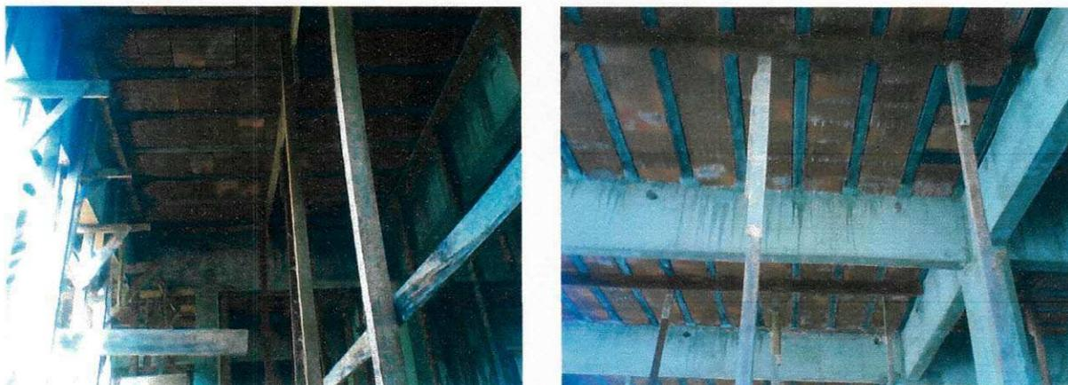
**Figura 44. Escoramento para lajes e vigas**
