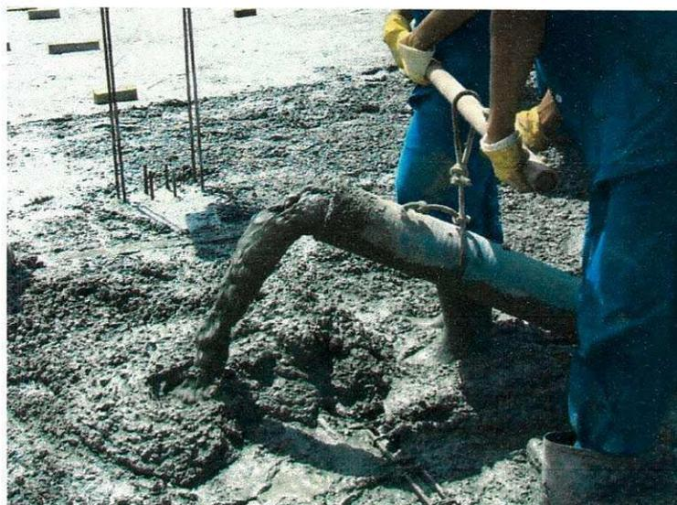
**Figura 17. Lançamento do concreto usinado**
