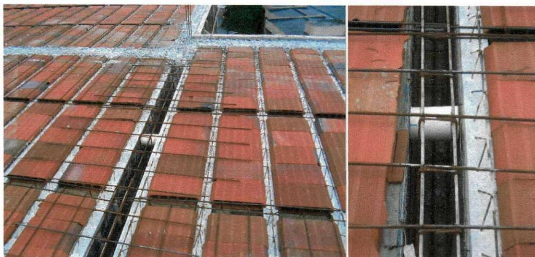
**Figura 1. Distribuição do aço no encontro de duas lajes**
