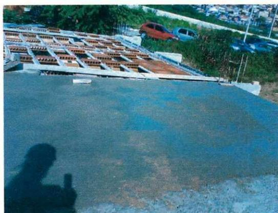
**Figura 43. Concretagem laje treliçada**
