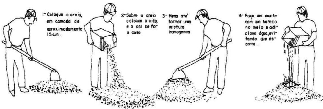
Figura 22. Preparação de argamassa manualmente
