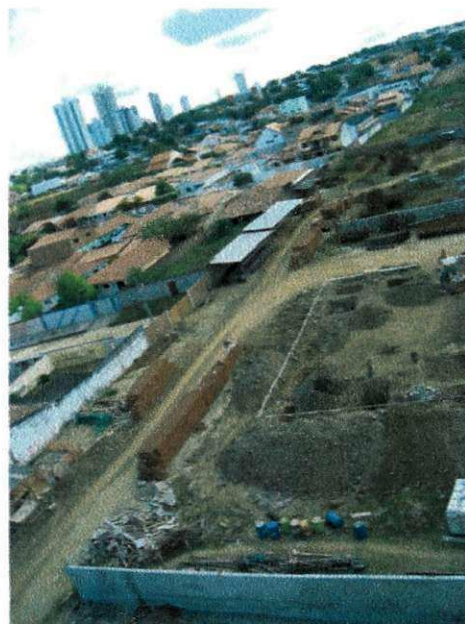
Figura 10- Canteiro de obra
