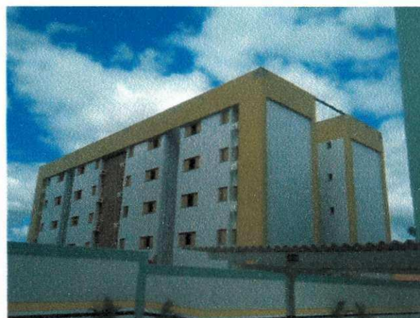
Figura 17- Augusto dos Anjos-Bloco A revestido
