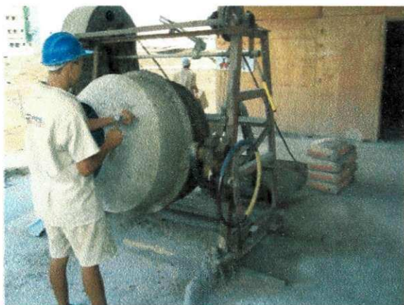
Figura 12- Betoneira próxima ao depósito de cimento
