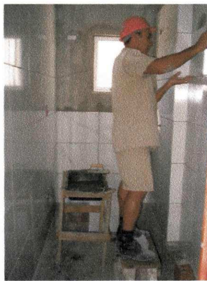
Figura 6- Assentamento interno em cerâmica
