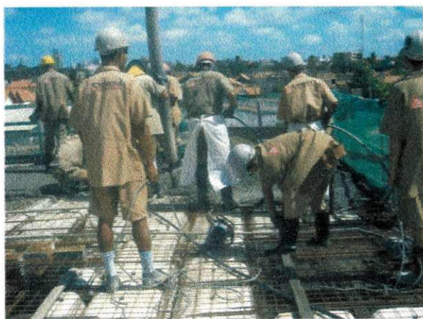
Figura 5- Concretagem em peça estrutural
