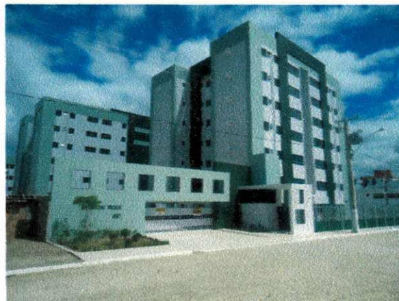
Figura 15- Newton Rique concluído
