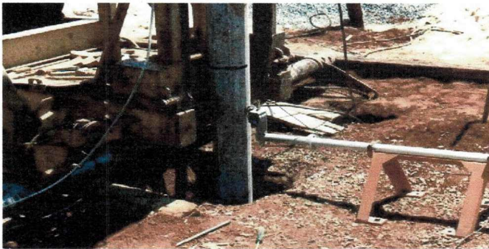
Cravação de estaca pré-moldada.
