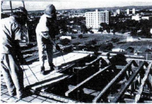
Fig 7.2.1.c Colocação dos elementos pré-moldados
