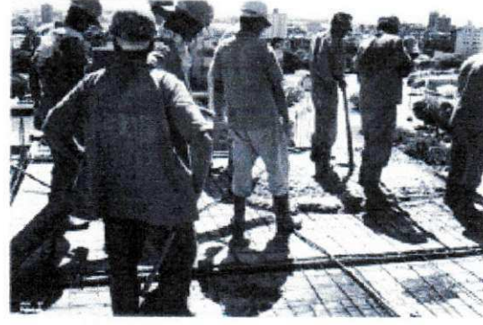
Fig. 7.2.1.d Lançamento do concreto
