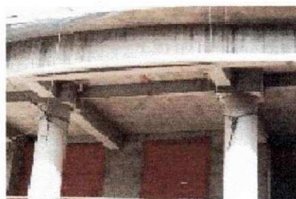
Figura 7.2.1.b Laje maciça e blocos de transição
