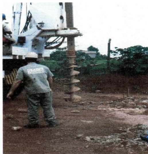
Detalhe do elemento de escavação.
