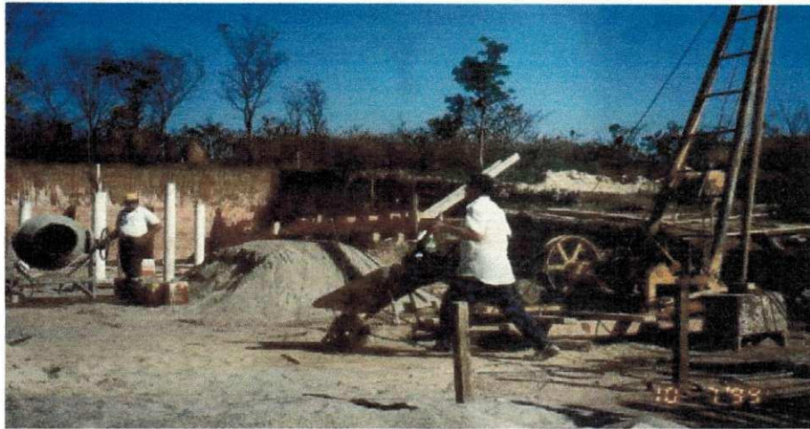
Execução de estaca Strauss.
