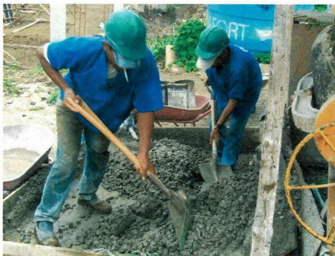
Figura 3. Preparação do concreto na betoneira
