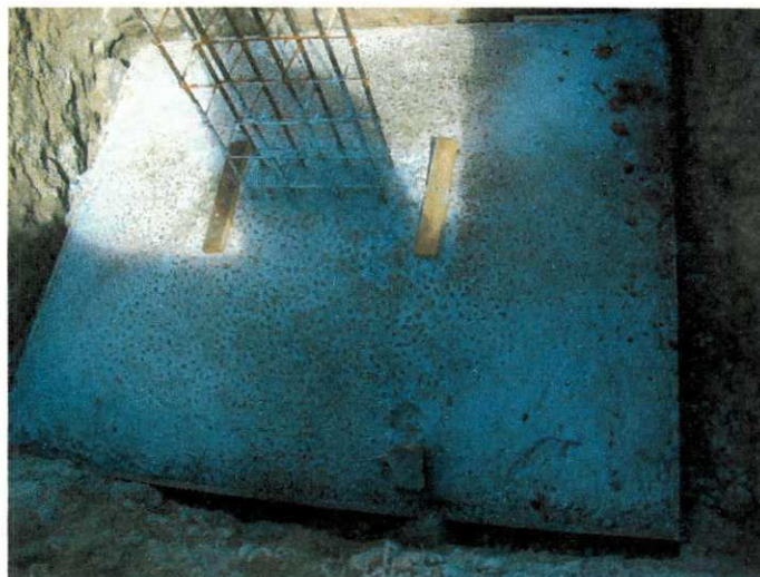
Figura 11. Sapata isolada com armadura de espera para moldagem do pilar
