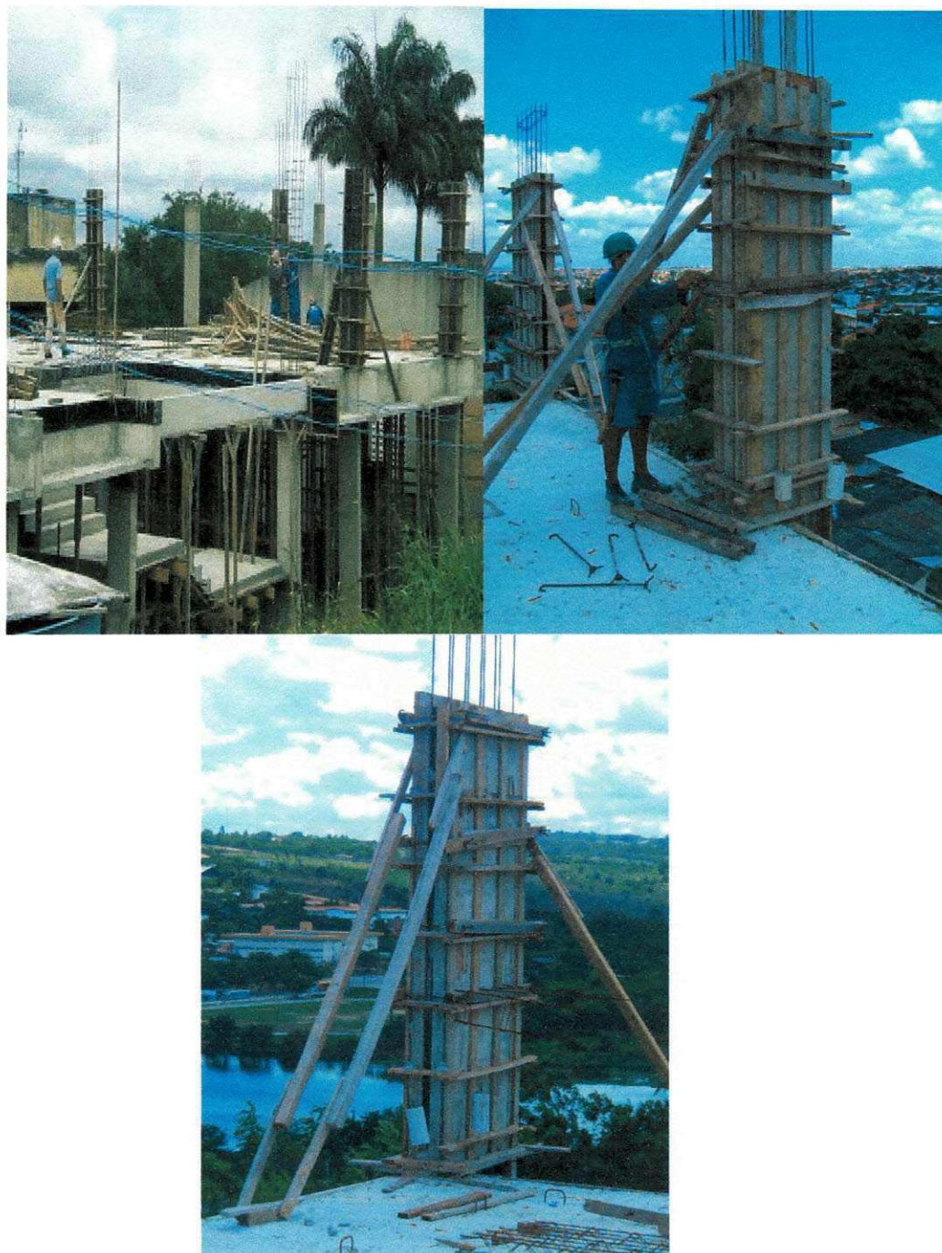
Figura 1. Fôrma de madeira para pilar
