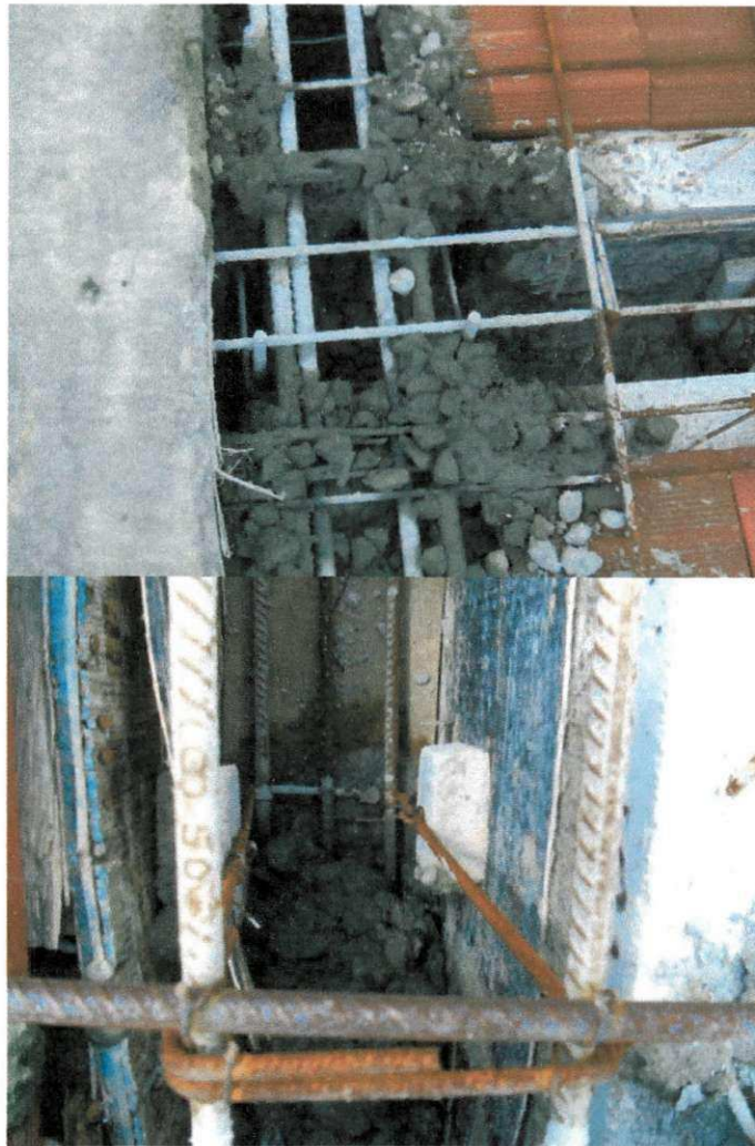
Figura 9. Concretagem de lajes e vigas
