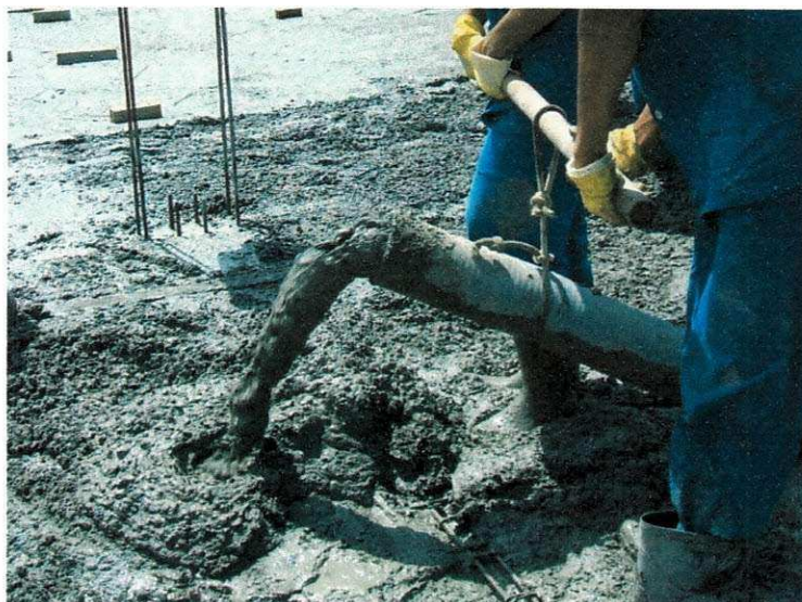
Figura 4. Lançamento do concreto usinado (Fernandes, 2007)
