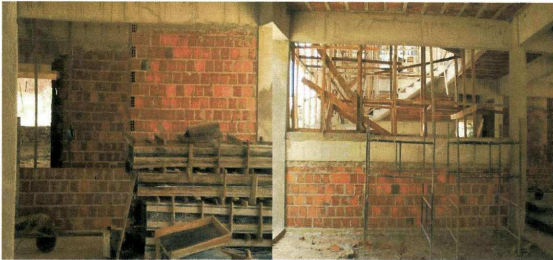
Figura 12. Detalhes dos processos de marcação (A) e levantamento de alvenaria (B).
