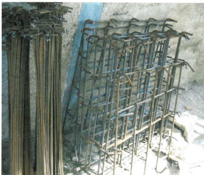
Figura 10. Lançamento do concreto magro (A) e grelhas para colocação sob sapatas (B).
