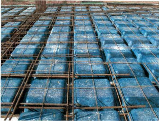
Figura 17 – Detalhamento das ferragens
