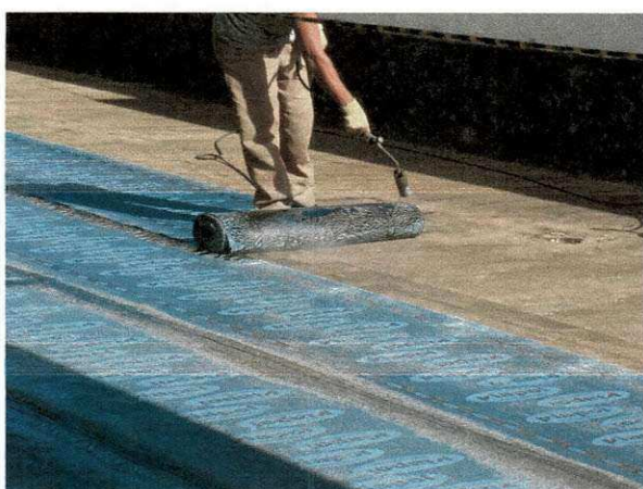
Figura 30 – Aplicação da manta asfáltica
