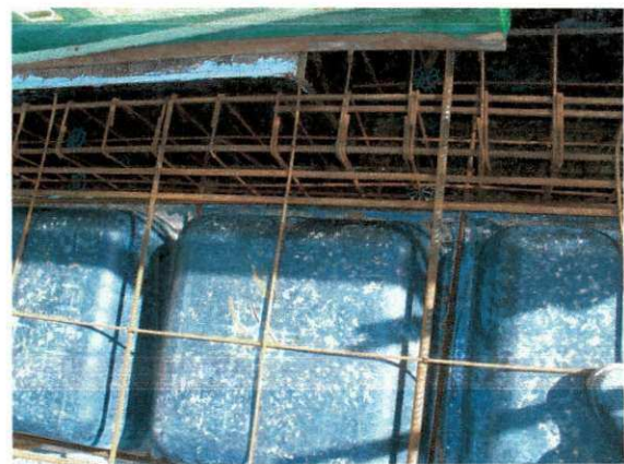
Figura 23 – Ancoragens da laje 2 ✓
