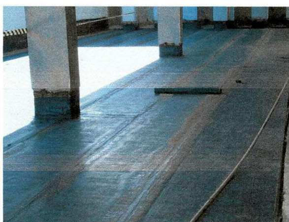
Figura 31 – A manta asfáltica aplicada
