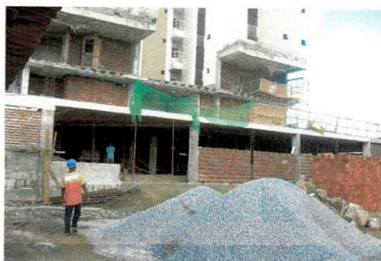
Figura 11 – Canteiro de obras 1
