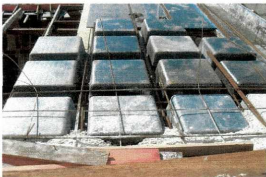
Figura 15 – Montagem da laje nervurada
