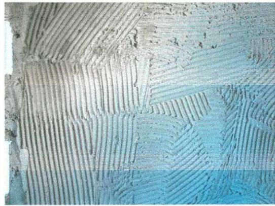
Figura 25 – Alvenaria com argamassa CP-2
