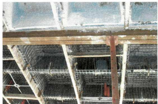
Figura 16 – Desforma da cubetas
