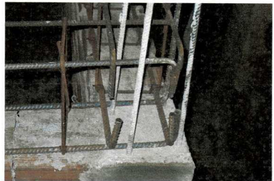
Figura 21 – Ancoragens das vigas ✓
