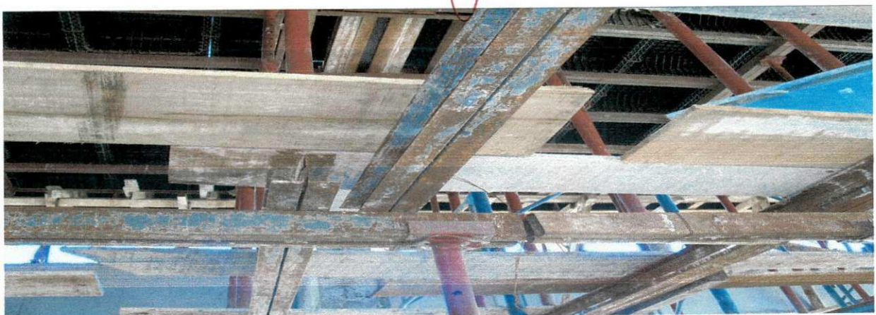
Figura 29 – Fôrmas para estruturas 2
