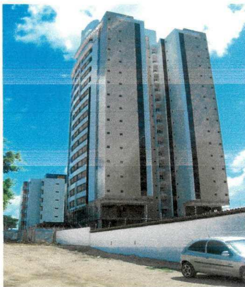
Figura 1 – Fachada e muro externo
