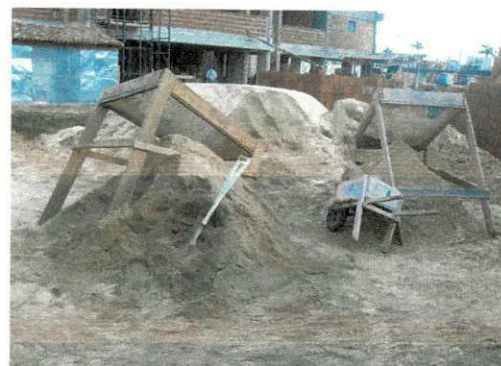
Figura 12 – Canteiro de obras 2
