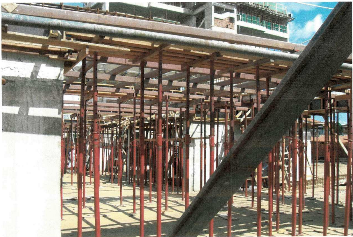
Figura 35 – Escoras metálicas
