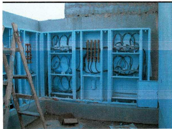
Figura 5 – Casa de força
