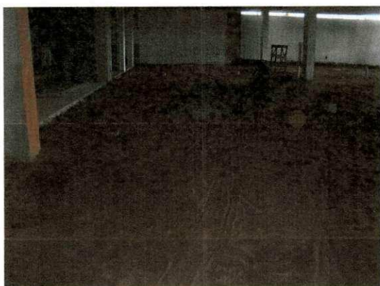
Figura 8 – Piso do subsolo/estacionamento
