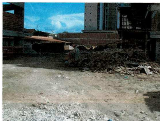
Figura 14 – Canteiro de obras 4
