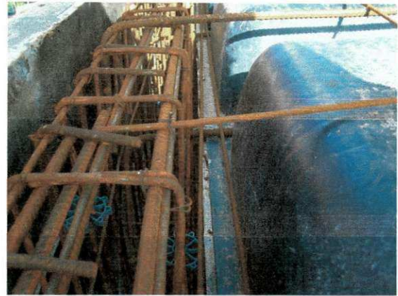
Figura 18 – Ancoragem das ferragens
