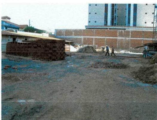
Figura 13 – Canteiro de obras 3
