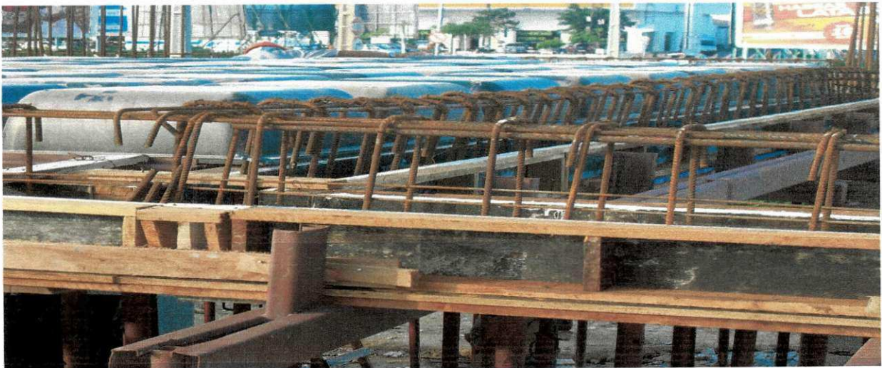
Figura 28 – Fôrma para as estruturas 1
