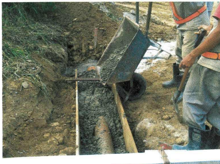
Assentamento de tubo.
