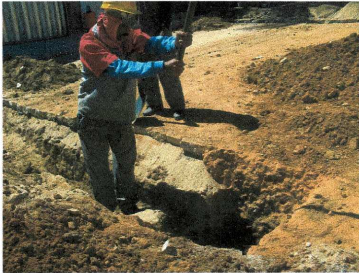
Escavação em terra, ligações externas.
