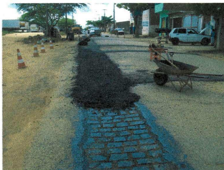
Recapeamento de ruas cortadas pela rede coletora
