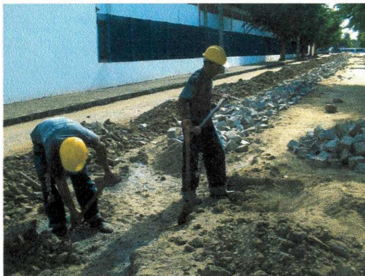
Retirada de paralelepípedo para execução das ligações.
