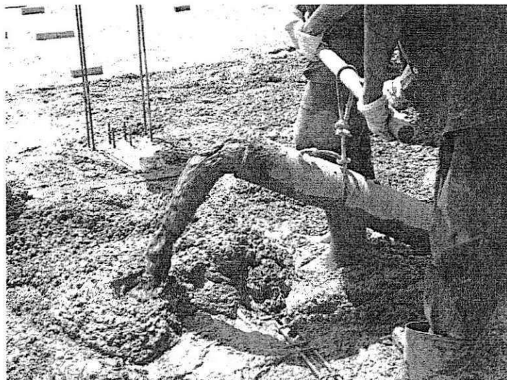
Figura 4. Lançamento do concreto usinado (Fernandes, 2007)
