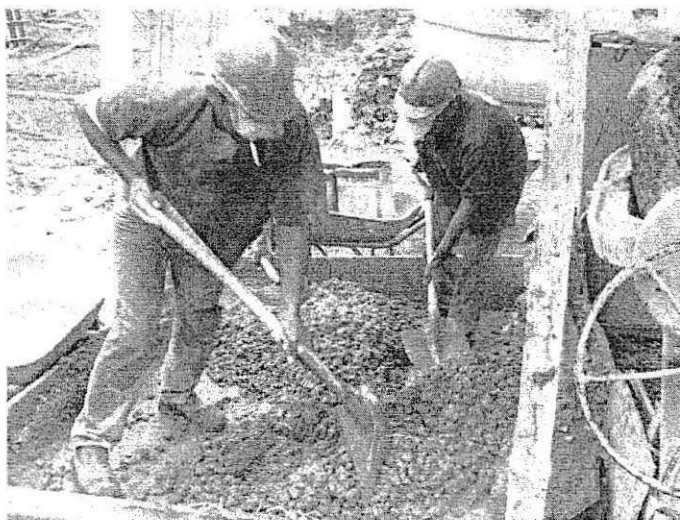
Figura 3. Preparação do concreto na betoneira
