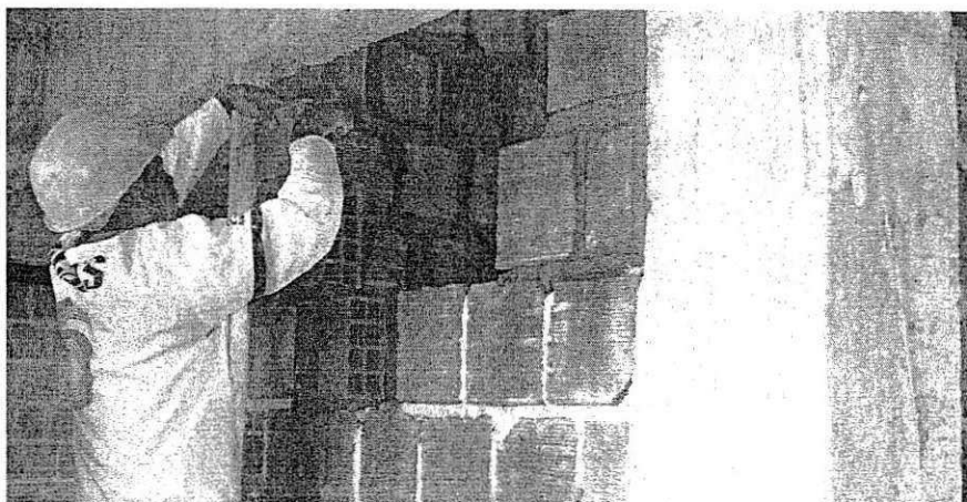
Figura 12. Detalhes dos processos de marcação (A) e levantamento de alvenaria (B).
