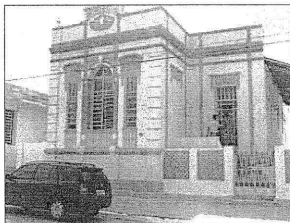
Figura 08: Vista da Residência da Comarca de São João do Cariri
