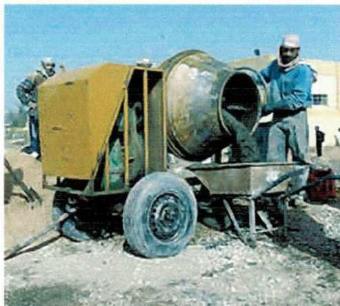
Figura 12: Concreto virado betoneira
