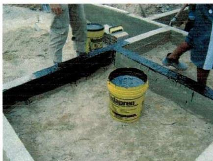
Figura 18 : Impermeabilização do alicerce com vedapren
