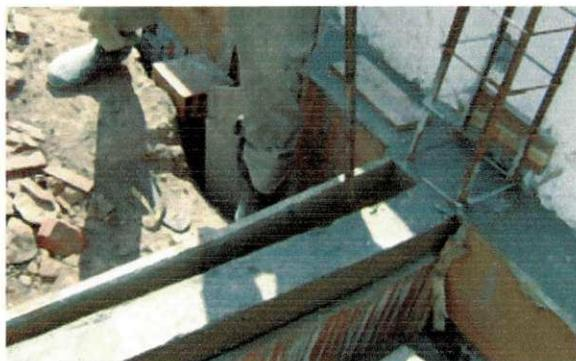
Figura 17 : Retirada das fôrmas das cintas
