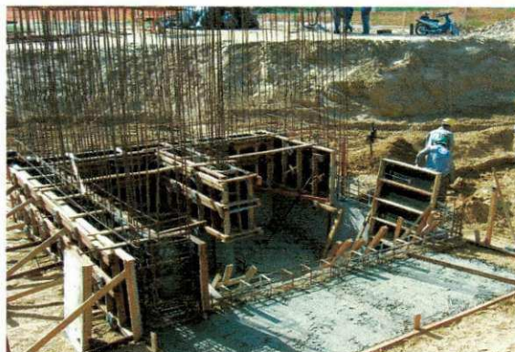
Figura 9.4- Fôrmas de madeira
