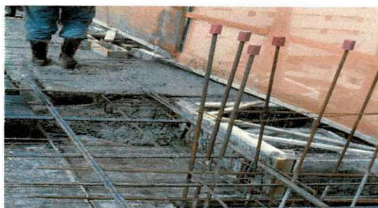
Figura 9.10- Concretagem de vigas
