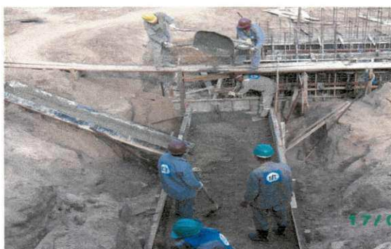
Figura 9.11- Transporte de concreto
