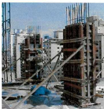
Figura 9.6 – Contraventamento em pilares
