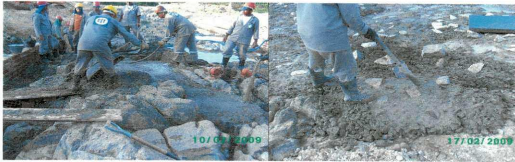
Figura 9.8- Adensamento do concreto
