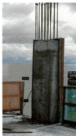
Figura 9.9 – Remoção da fôrma do pilar
