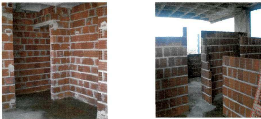
Figura 9.12 – Alvenaria de vedação
