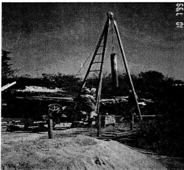
Execução de estaca apiloada.
