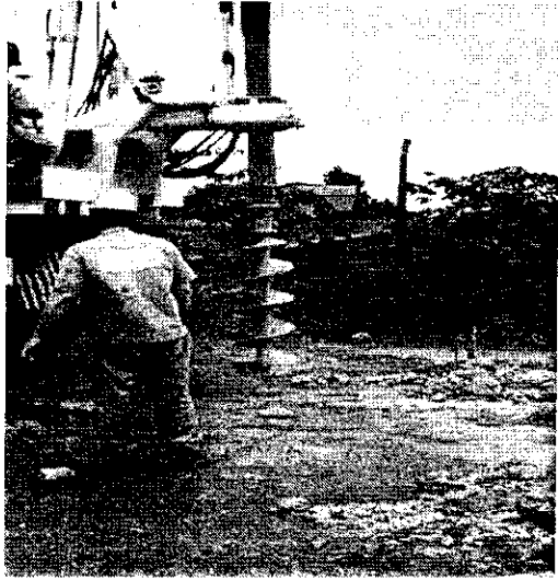
Caminhão com perfuratriz.
