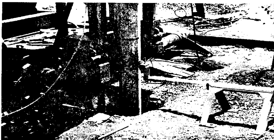
Cravação de estaca pré-moldada.
