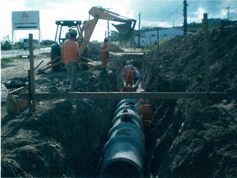
Foto 5: Assentamento de manilhas de 800 mm de drenagem com o auxílio da retro-escavadeira.
