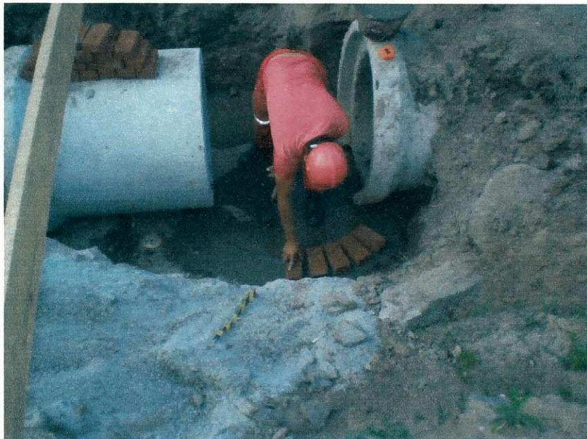
Foto 6: Execução de poço de visita com tijolo maciço assentado em 2X.
