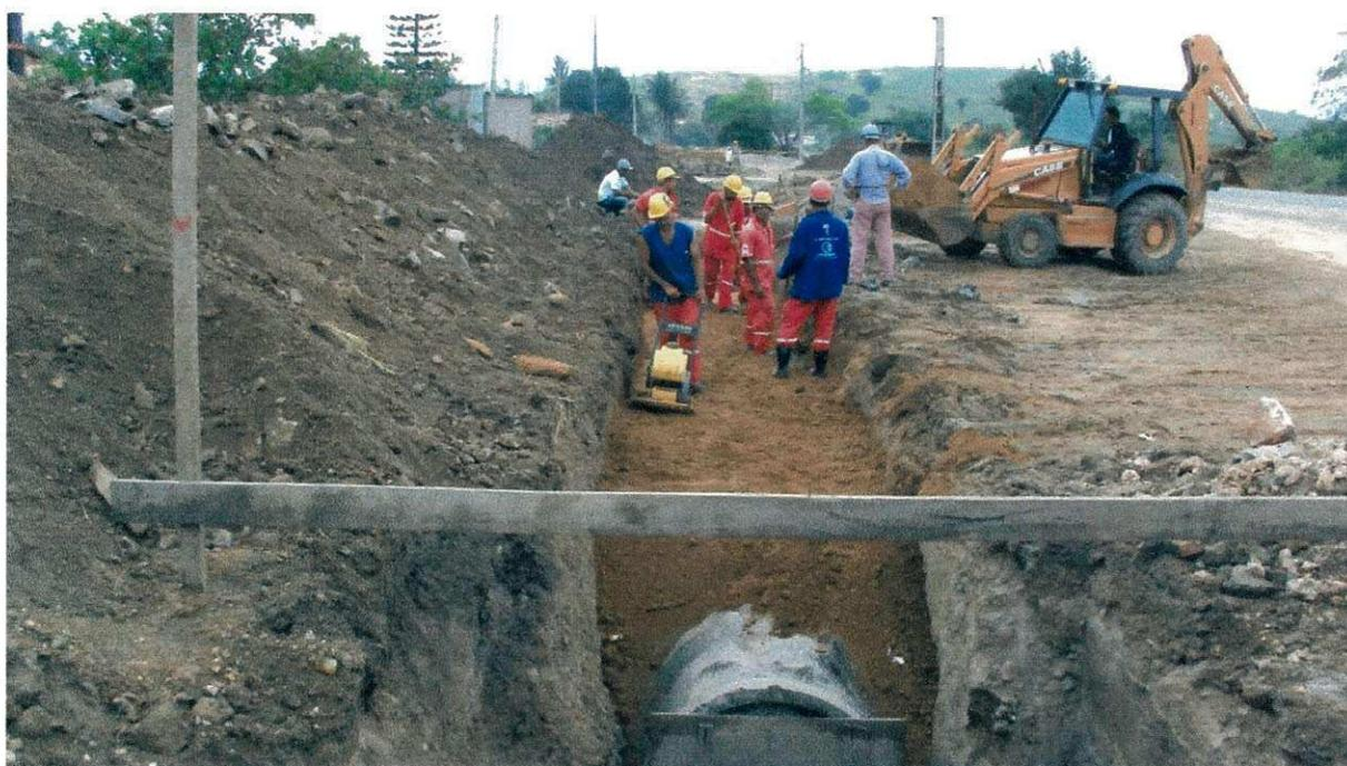
Foto 10: Apiloamento do material de aterro colocado logo após a camada de pó-de-pedra que envolve a manilha de drenagem.
