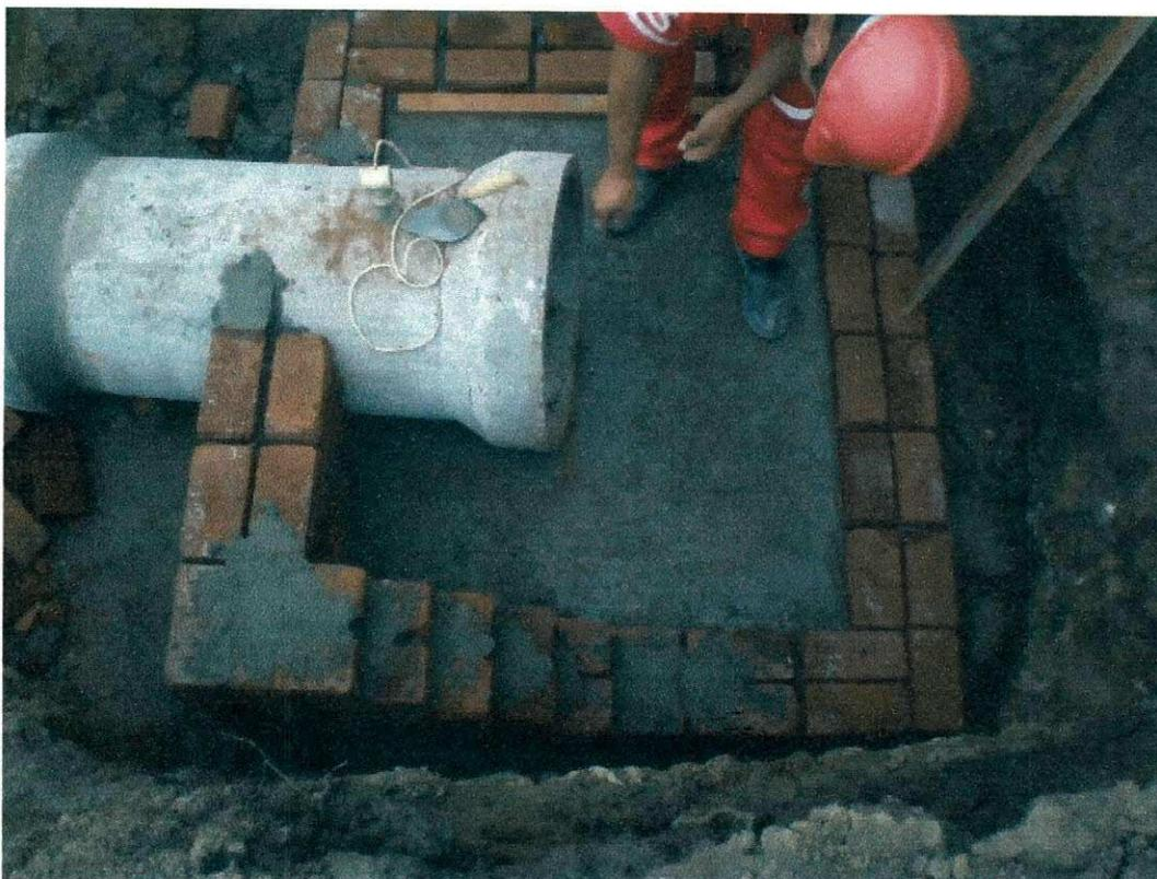
Foto 9: Construção de boca de lobo com tijolo maciço.
