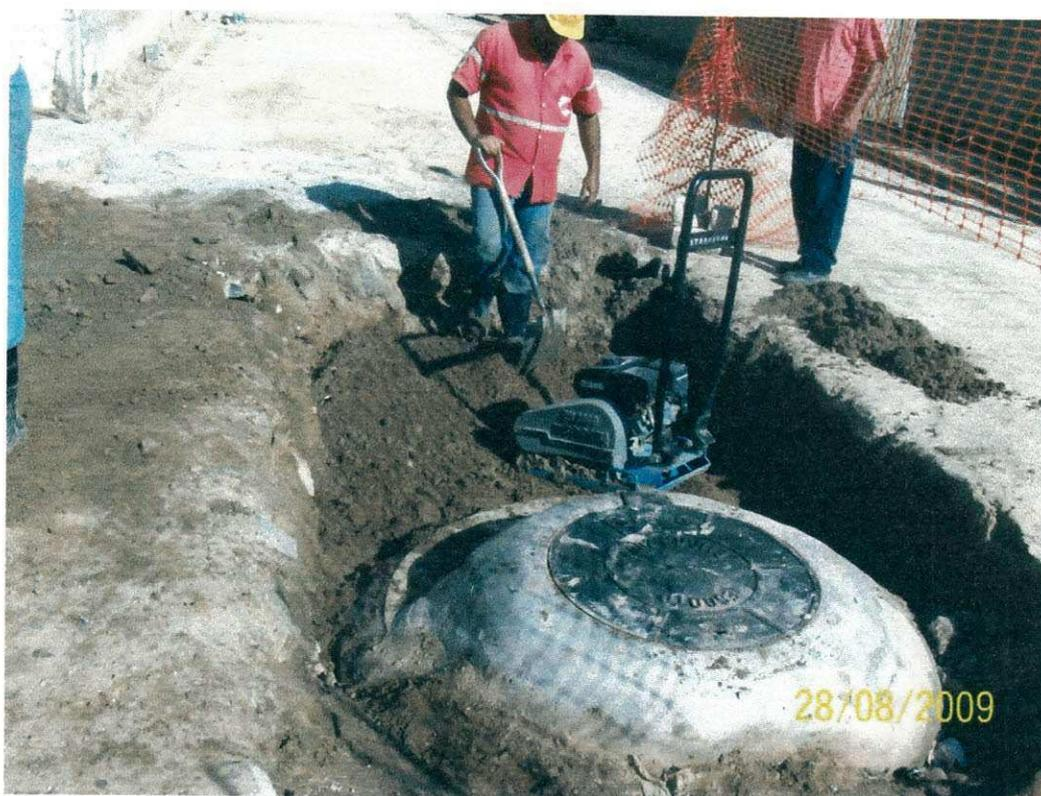
Foto 11: Apiloamento do material de aterro ao lado do poço de visita.
