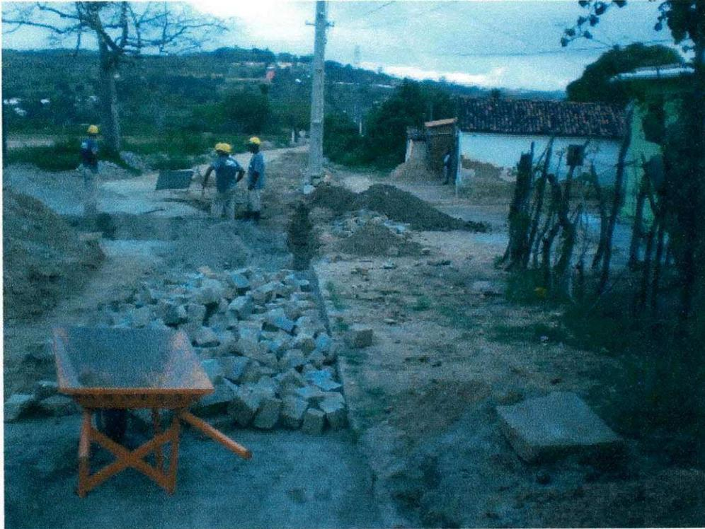
Foto 14: Recomposição do pavimento após execução da rede de esgoto.
