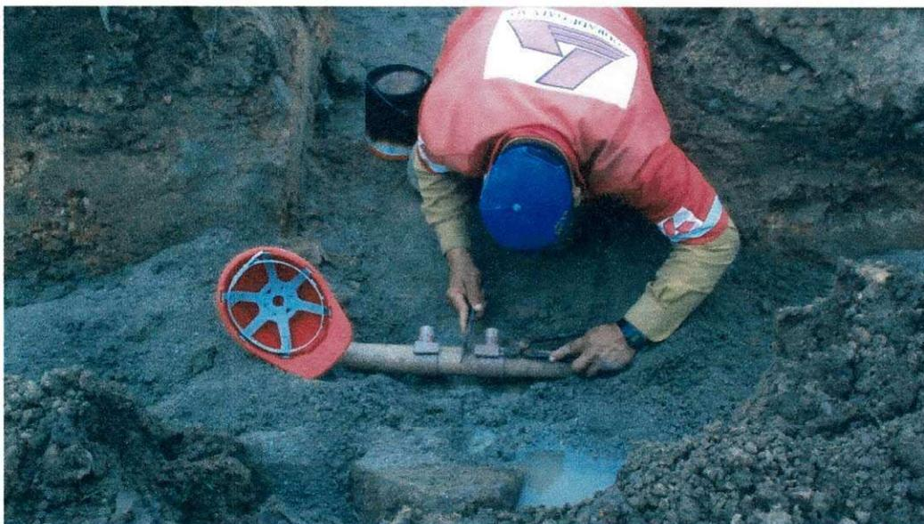
Foto 2: Encaixe do selin para ligação de água.
