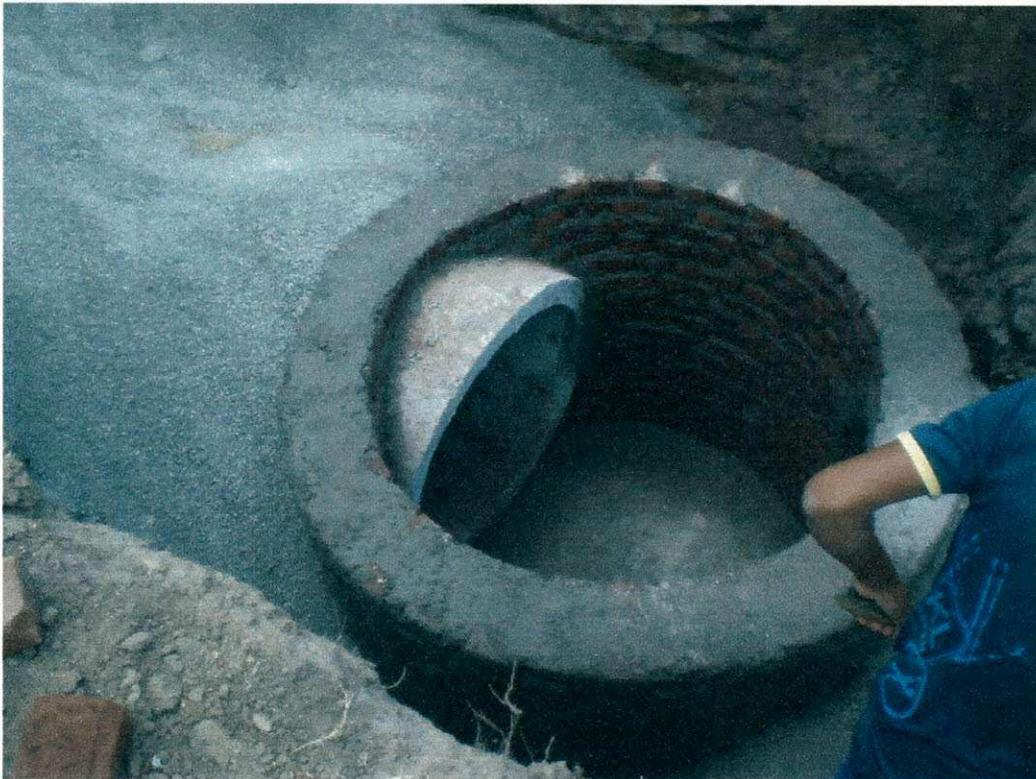
Foto 8: Poço de visita seguido de uma manilha de Drenagem revestido com uma camada de 10 à 15 cm de pó-de-pedra.
