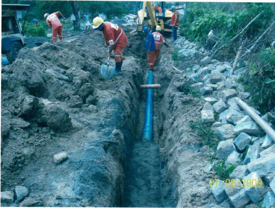
Foto 3: Assentamento de tubo De F°F° na rede de abastecimento de água. Notar que a ligação de esgoto residencial está passando por cima da rede de água.
