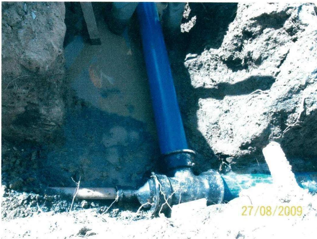
Foto 4: Tê de redução 100x50mm de ferro fundido.
