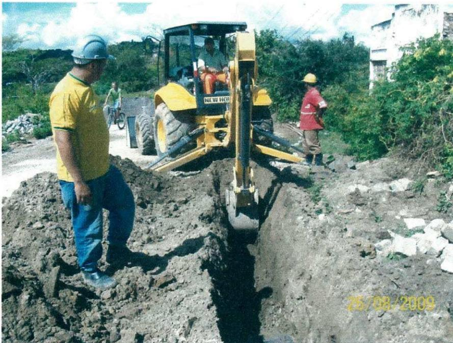
Foto 1: Escavação de vala para assentamento de tubo de abastecimento d'água.
