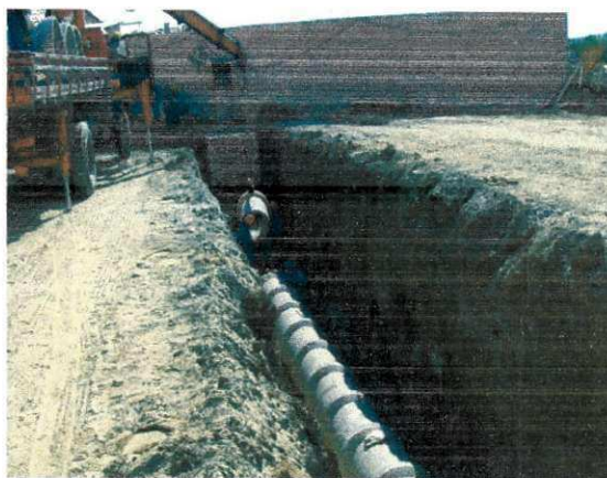
Figura 17 – Assentamento de manilhas para drenagem pluvial (Fonte: Arquivo pessoal)
