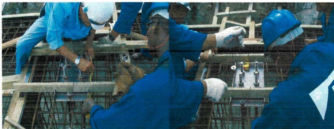
Figura 11 – Alinhamento dos chumbadores que recebem os pilares metálicos (Fonte: Arquivo pessoal)
