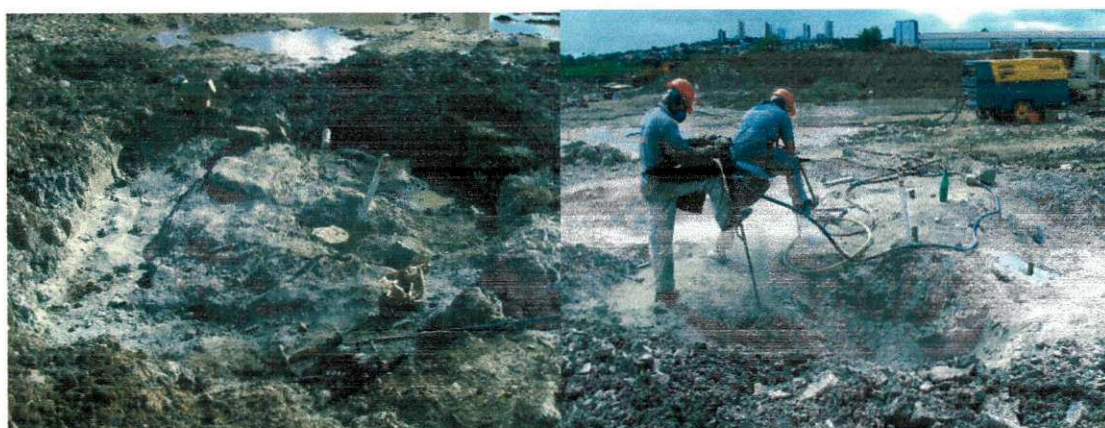
Figura 4 – Preparação para demolição de rochas (Fonte: Arquivo pessoal)
