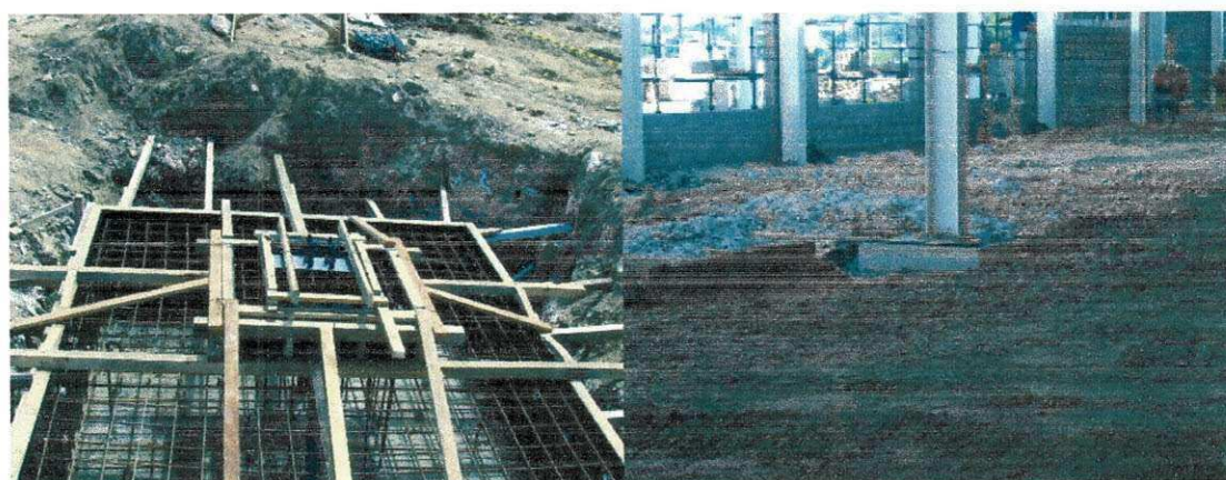
Figura 12 – Bloco pronto pra ser concretado; bloco pronto, com pilar metálico (Fonte: Arquivo pessoal)
