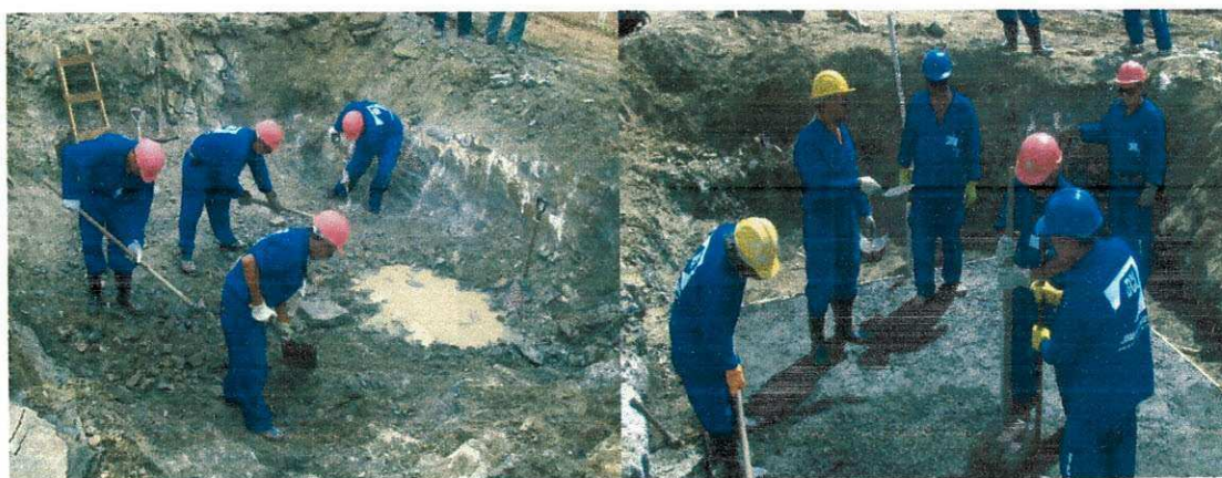
Figura 9 – Preparação das bases das fundações; nivelamento feito com concreto magro (Fonte: Arquivo pessoal)
