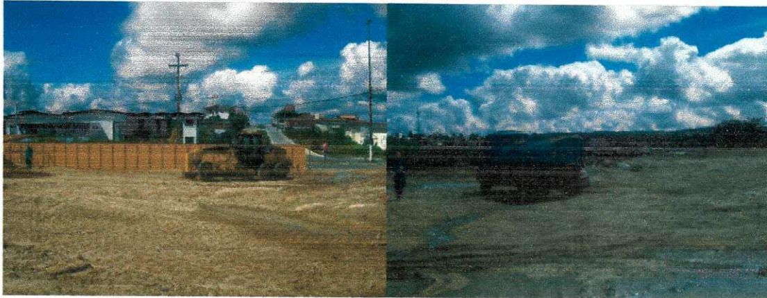
Figura 7 – Serviços de terraplanagem. (Fonte: Arquivo pessoal)
