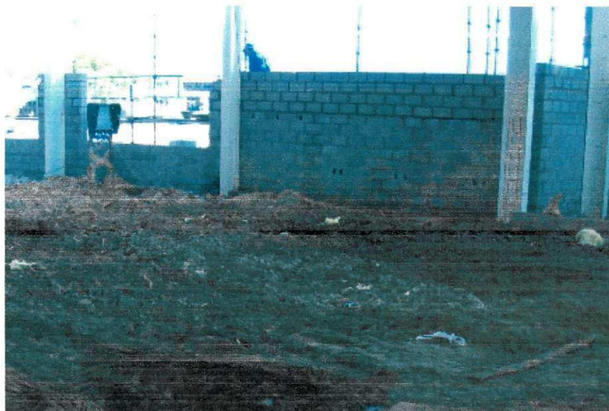
Figura 15 – Alvenaria em blocos de concreto (Fonte: Arquivo pessoal)
