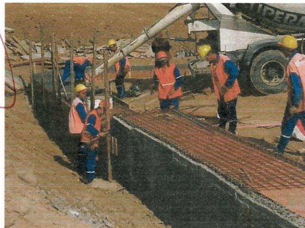
FIGURA 16: Concretagem da laje superior do canal.
