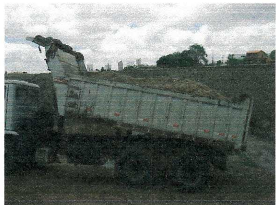
FIGURA 11: Transporte de material para aterro.
