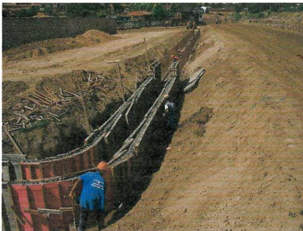
FIGURA 15: Construção do canal.
