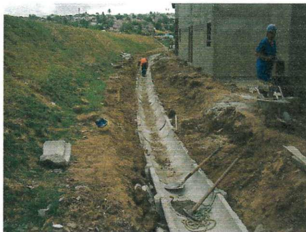
FIGURA 09: Assentamento de calhas para micro-drenagem.
