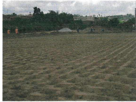
FIGURA 13: Solo após a compactação com o rolo pé-de-carneiro.
