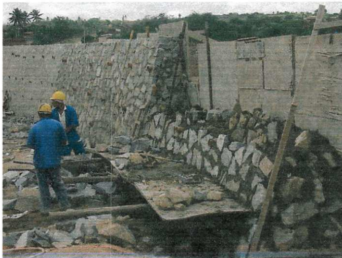
FIGURA 14: Construção de um muro de arrimo.
