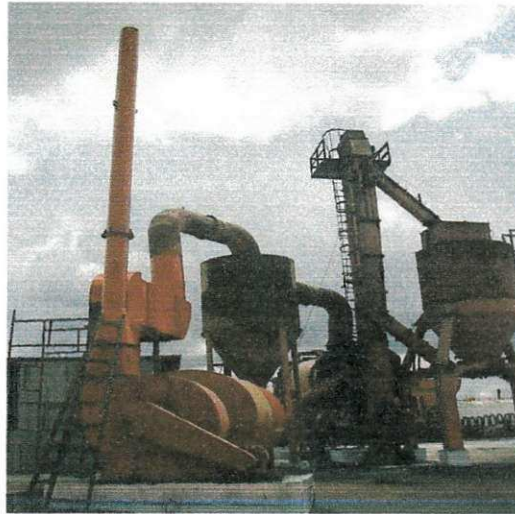
FIGURA 08: Usina de CBUQ.
