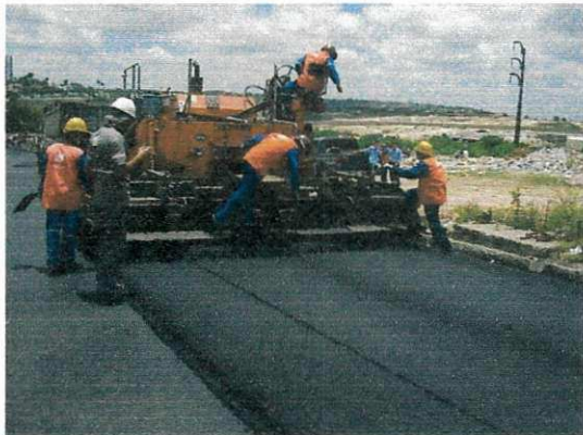
FIGURA 06: Lançamento do CBUQ.
