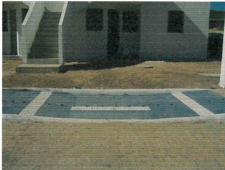
FIGURA 01: Rampa de acessibilidade para portadores de necessidade especiais.
