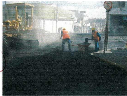
FIGURA 05: Camada de regularização.
