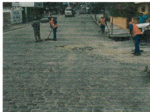
FIGURA 03: Limpeza da base.
