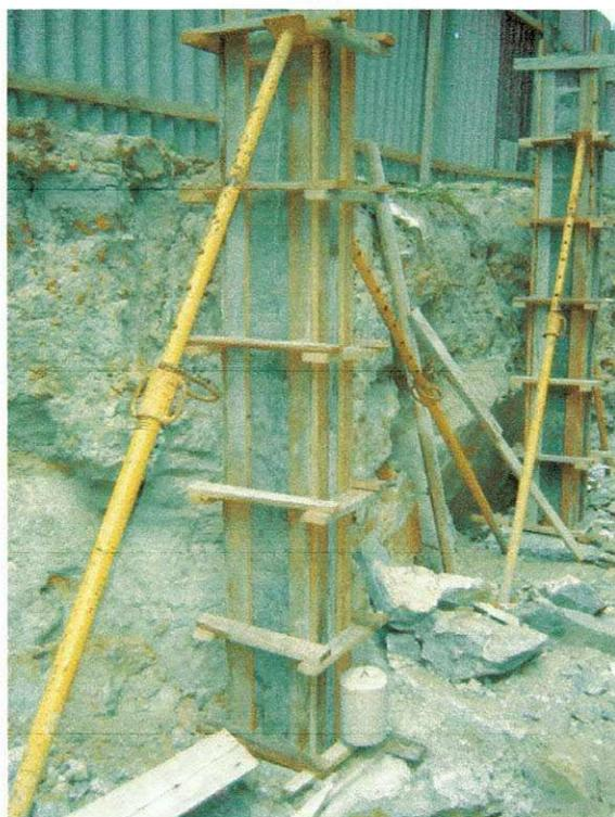
**Figura 1.** Fôrma de madeira para pilar
