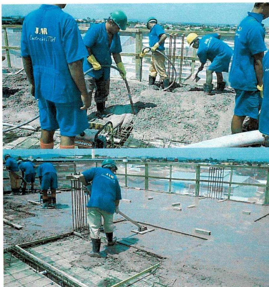
**Figura 6.** Concretagem de lajes e vigas (Pinheiro, 2006).
