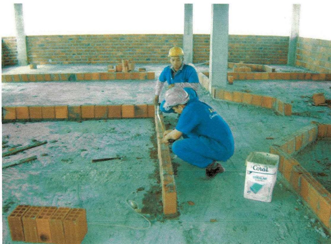
**Figura 9.** Detalhes dos processos de marcação e levantamento de alvenaria.
