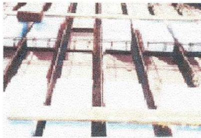
Figura 7.1.3.c e 7.1.3.d Laje nervurada formada por lajes pré-fabricadas com incorporação de blocos de isopor (cortesia lajes Anhanguera) e estrutura de cimbramento de alumínio
