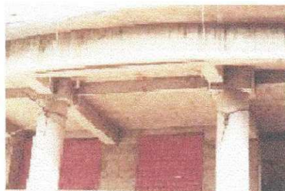
Figura 7.1.1.a Laje maciça Figura 7.1.1.b Laje maciça e blocos de transição
