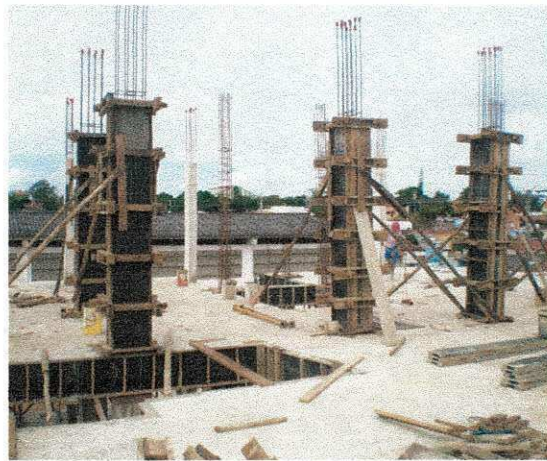
Armadura à espera do concreto
