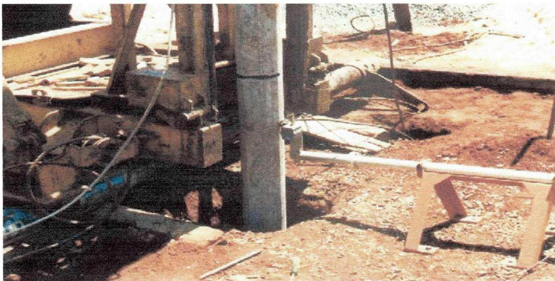
Cravação de estaca pré-moldada.
