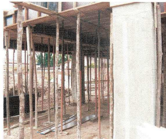
Pilar depois de retirada da fôrma
