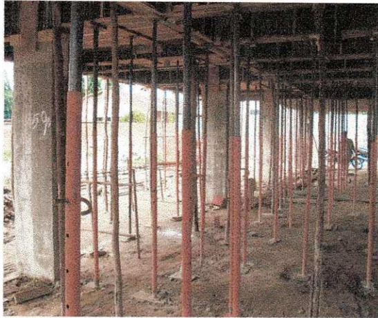
Fôrmas e escoramentos para lajes e vigas
