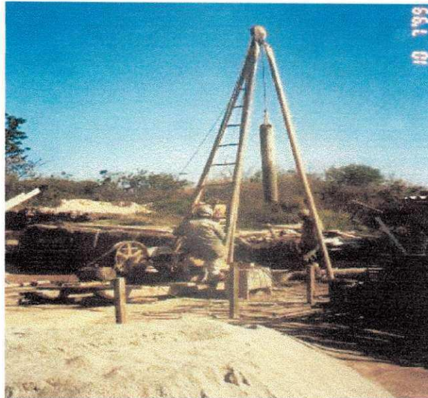
Execução de estaca apiloada.
