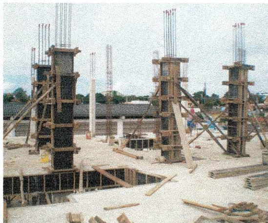
Fôrmas e escoramentos para pilares
