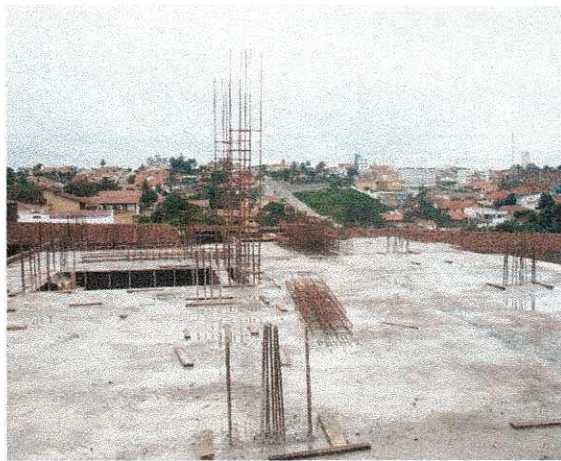
Laje pré-fabricada concretadas.
