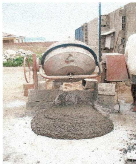
Concreto fabricado "in loco"
