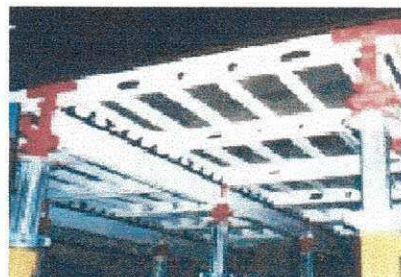
Figura 7.1.3.c e 7.1.3.d Laje nervurada formada por lajes pré-fabricadas com incorporação de blocos de isopor (cortesia lajes Anhanguera) e estrutura de cimbramento de alumínio
