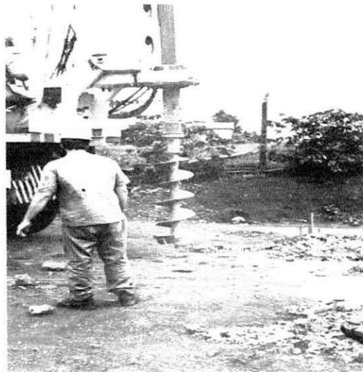
Detalhe do elemento de escavação.
