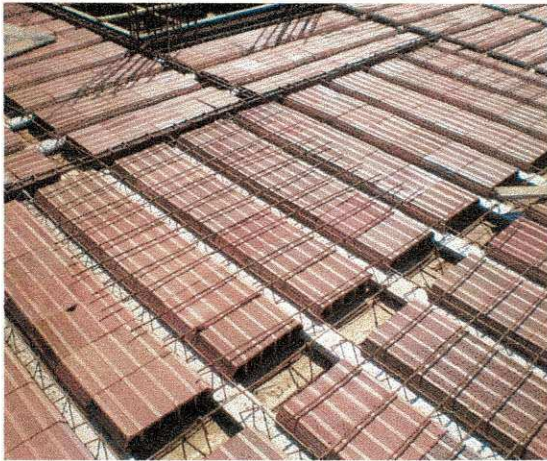
Laje pré-fabricada antes da concretagem
