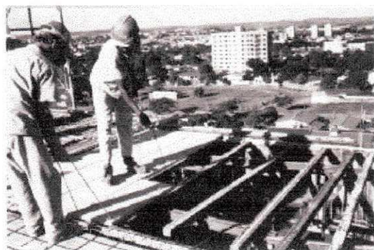
Fig 7.1.1.c Colocação dos elementos Fig. 7.1.1.d Lançamento do concreto pré-moldados
