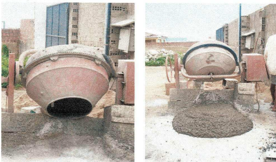
Processo de fabricação do concreto "in locu"
