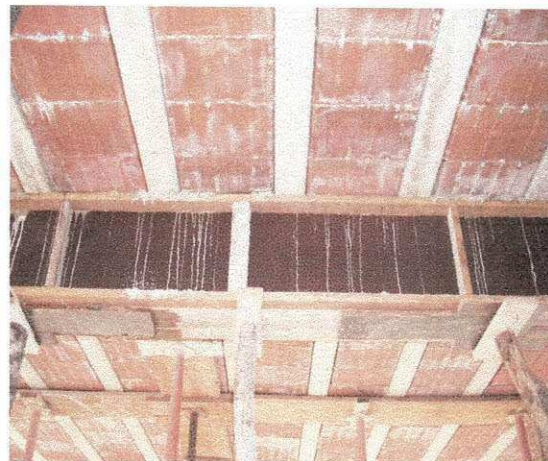
Fôrmas e escoramentos para lajes e vigas
