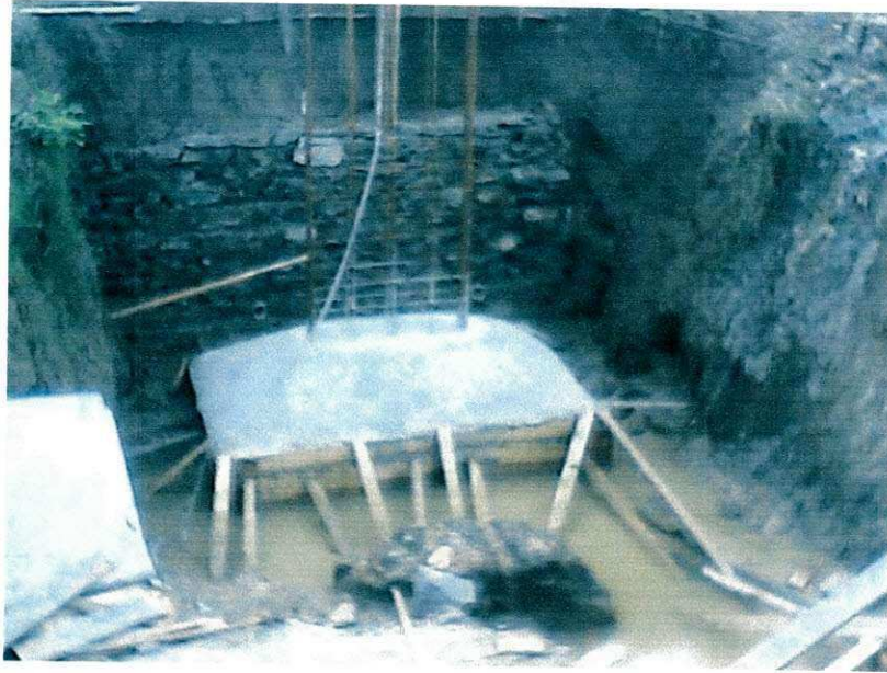
FOTO 4:SAPATA CONCRETADA
