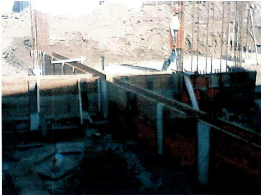
FOTO 7: FÔRMAS DAS VIGAS BALDRAME
