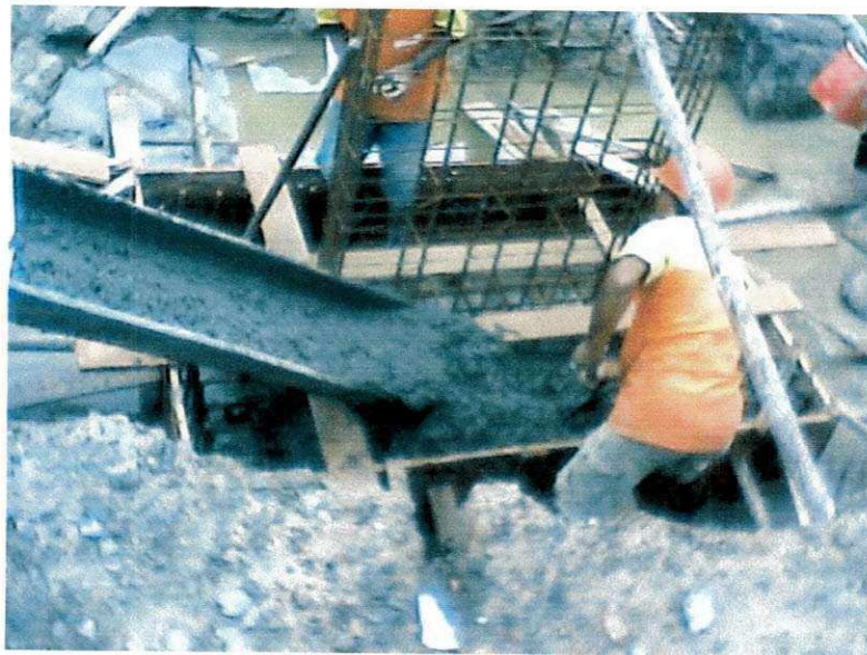
FOTO 3: CONCRETAGEM DA SAPATA
