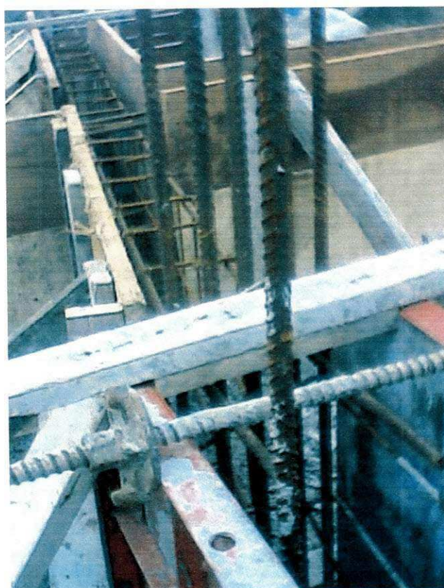
FOTO 8: ENCONTRO DA ARMADURA DAS CINTAS COM A DO PILAR
