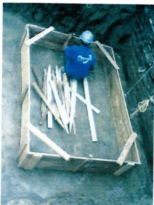
FOTO 1: COLOCAÇÃO DA FÔRMA DE MADEIRA DA SAPATA.
