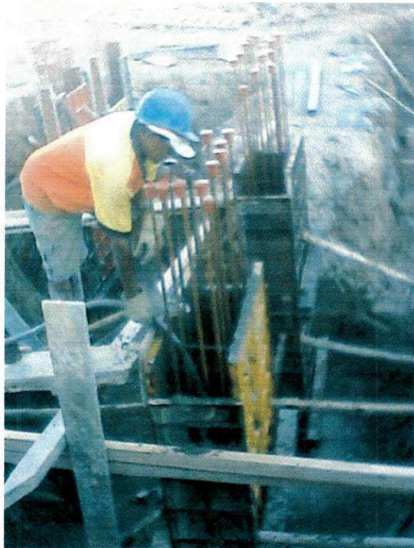
FOTO 5: CONCRETAGEM E VIBRAÇÃO DOS PILARES
