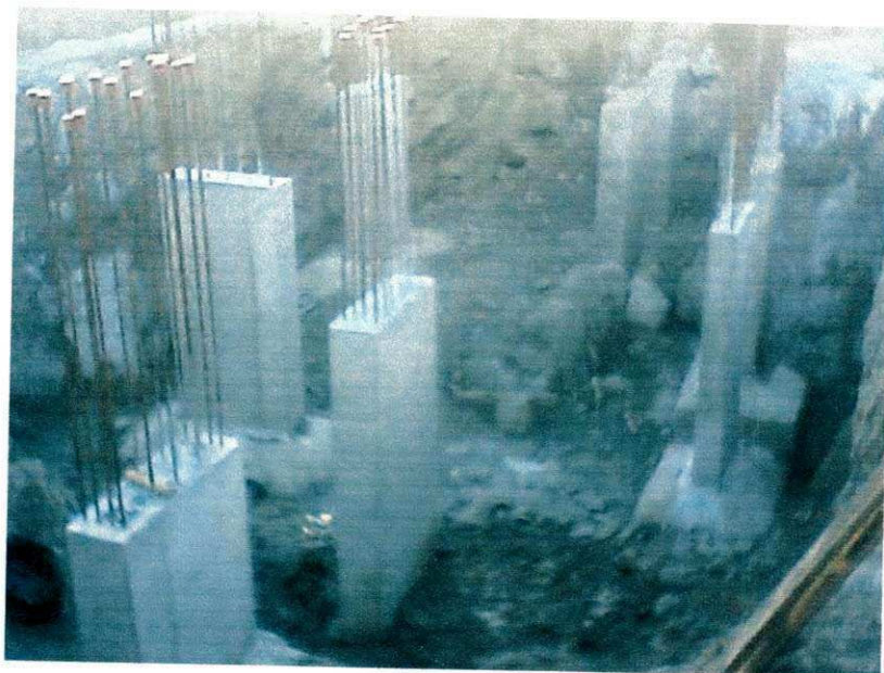
FOTO 6: PILARES E SAPATAS CONCRETADOS E DESFORMADOS
