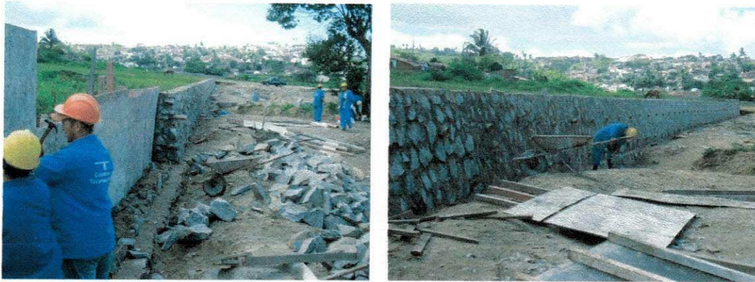
Foto 5 e 6 – Fonte Direta: Muros de Arrimo
