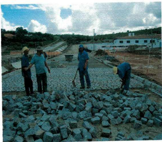
Execução de Pavimento em Paralelepípedos
