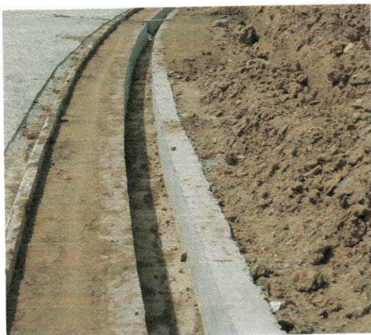
Execução de Canaletas e Tampas
