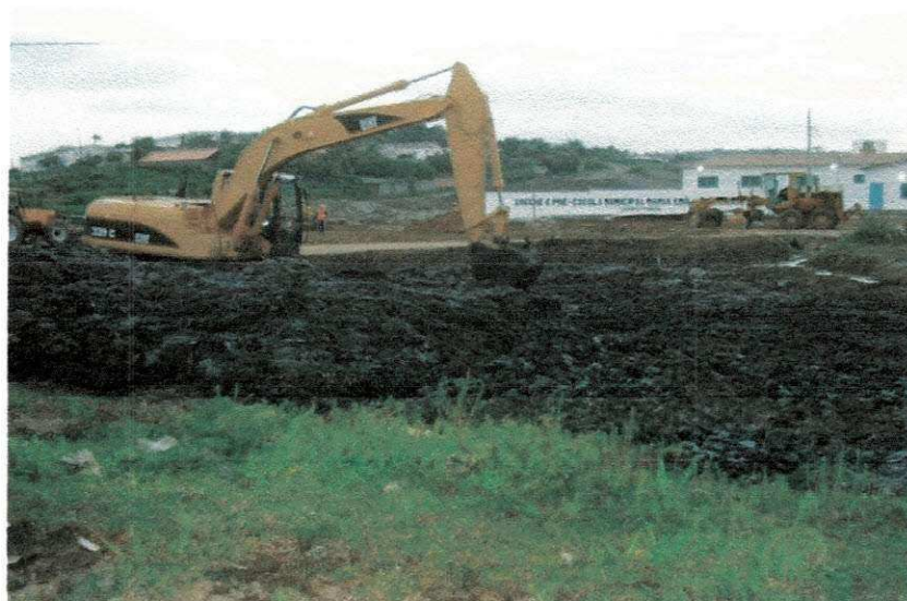
Foto 1 – Fonte Direta: Movimento de terra
