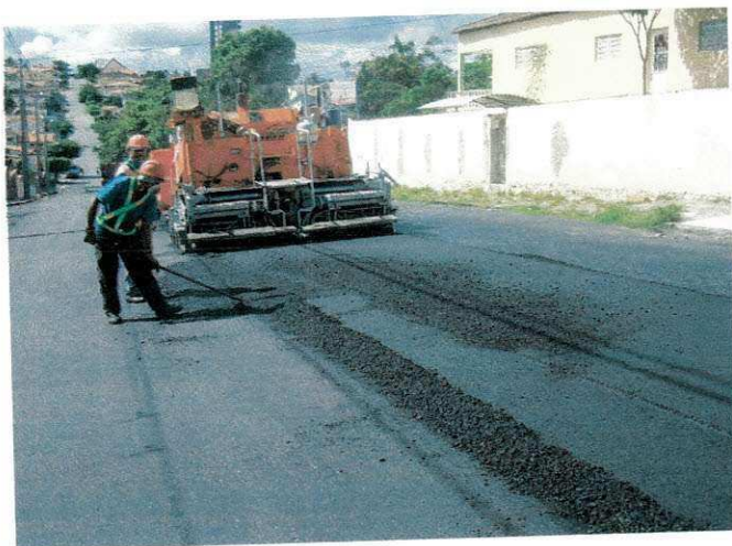
Caapeamento e Recapeamento Asfáltico
