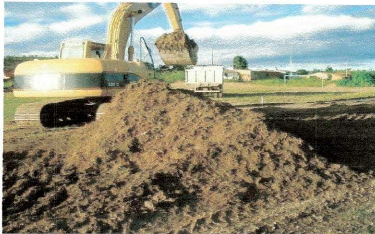
Foto 2 – Fonte Direta: Movimento de terra (bota-fora).
