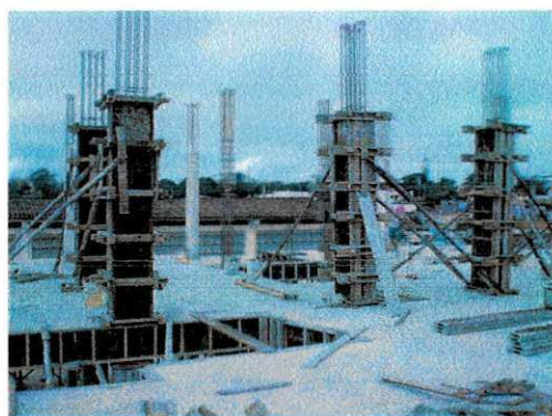
Figura 7 - Armadura à espera do concreto
