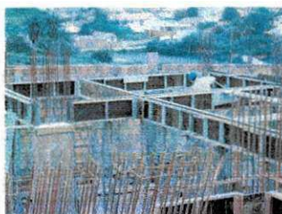
Figura 2 - Operação de montagem de painéis pré-fabricados
