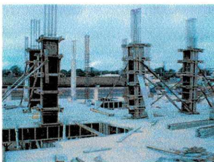
Figura 14 - Fôrmas e escoramentos para pilares
