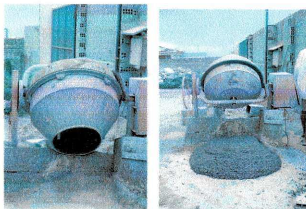
Figura 3 - Processo de fabricação do concreto in locu
