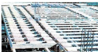
Figura 1 - Operação de alinhamento das vigotas e painéis treliçados
