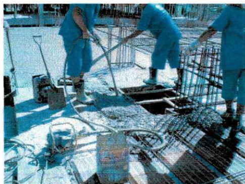
Figura 16 - Vibrador de imersão
