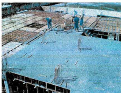
Figura 20 – Operários concretando laje
