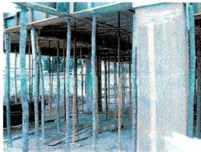
Figura 15 - Pilar depois de retirada a fôrma
