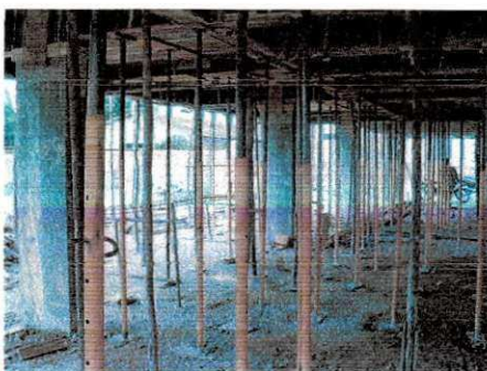
Figura 13 - Fôrmas e escoramentos para lajes e vigas
