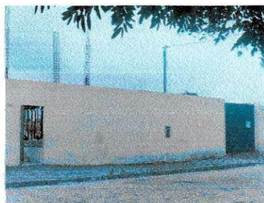
Figura 10 – Portões de acesso à obra
