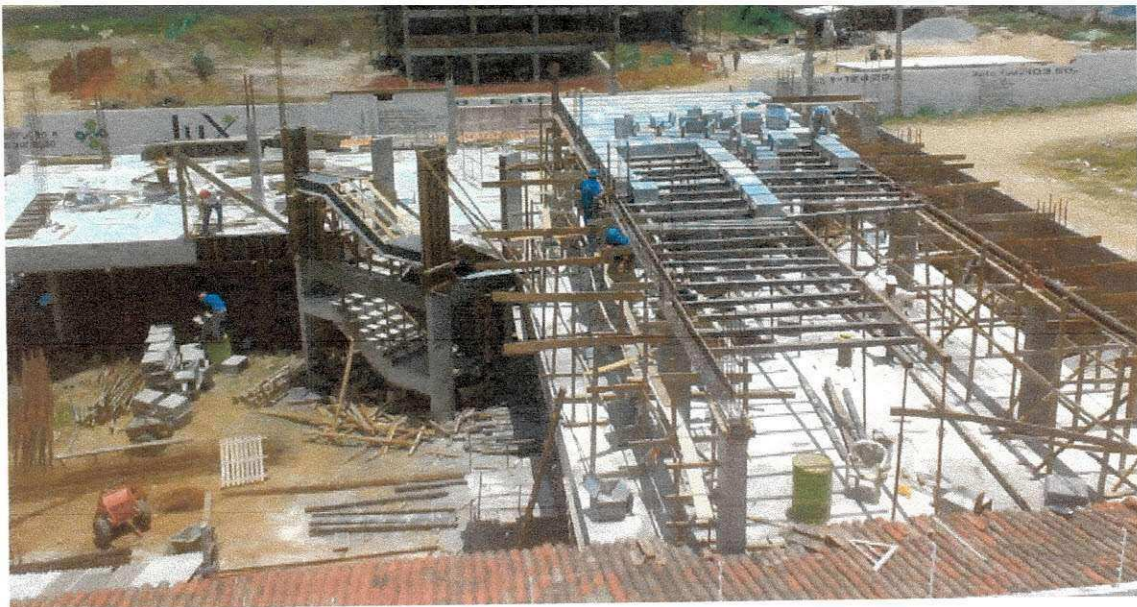
Figura 17 – montagem estrutura segunda laje
