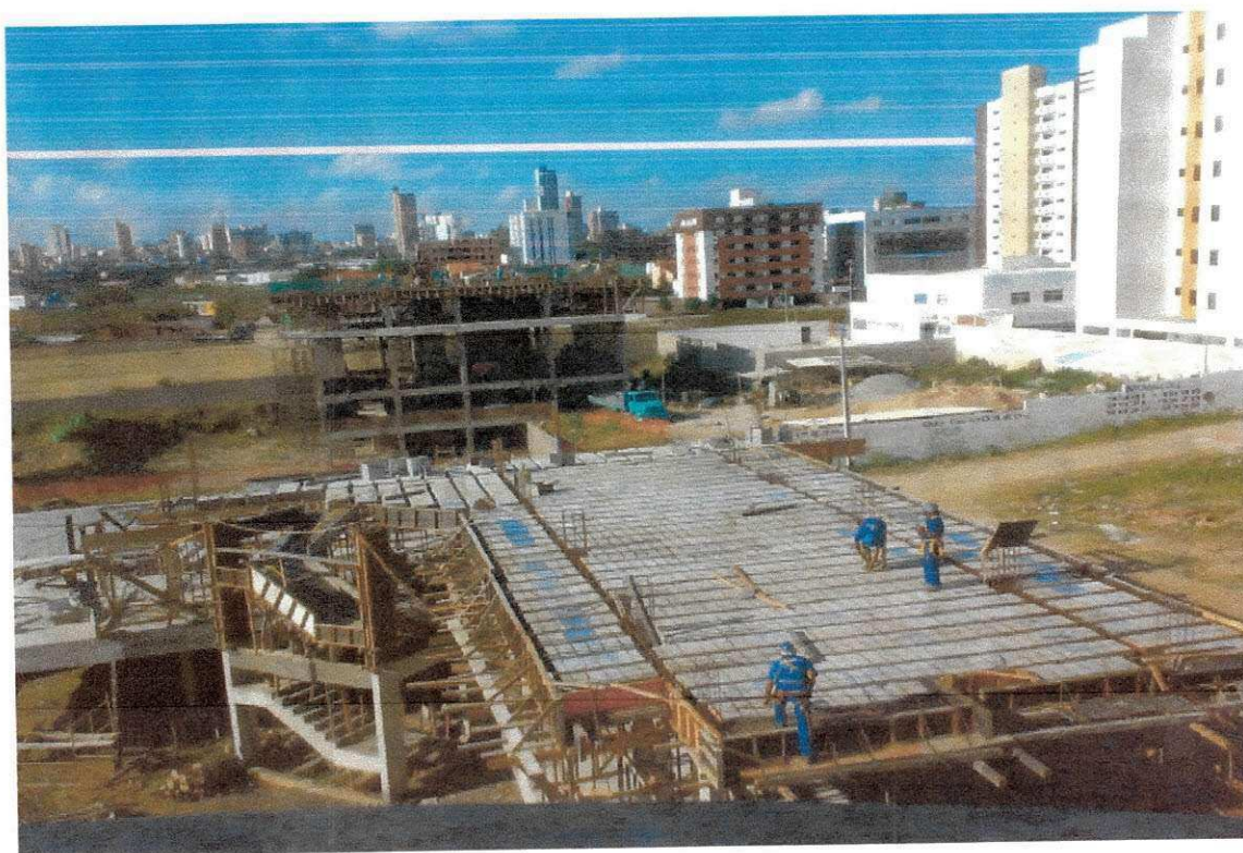
Figura 18 – montagem estrutura segunda laje
