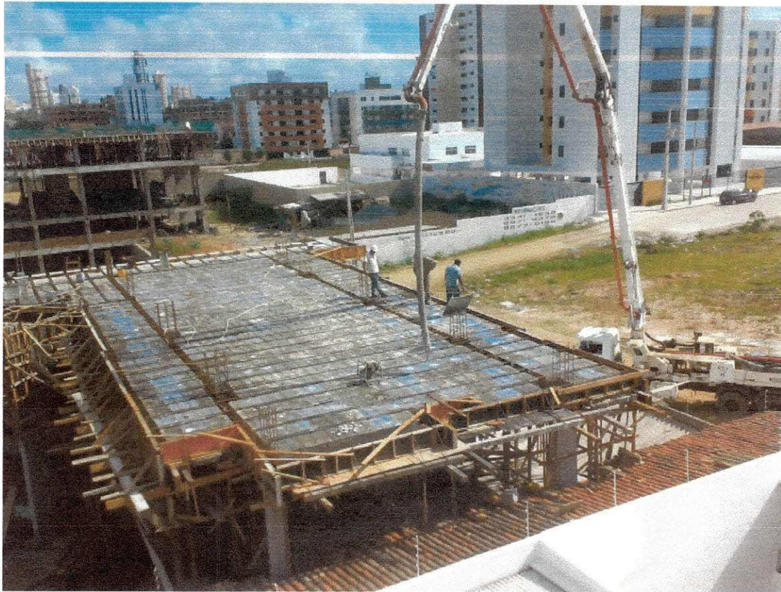
Figura 19 – concretagem segunda laje
