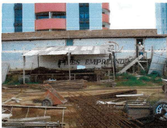
Figura 12 – Armazenamento de materiais
