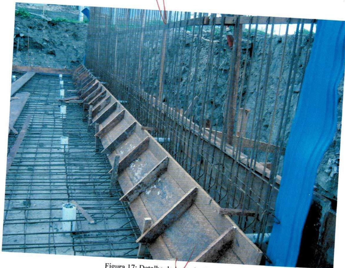
Figura 17: Detalhe da junta de dilatação
