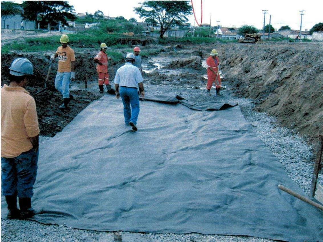
Figura 13: Alinhamento da manta geotêxtil
