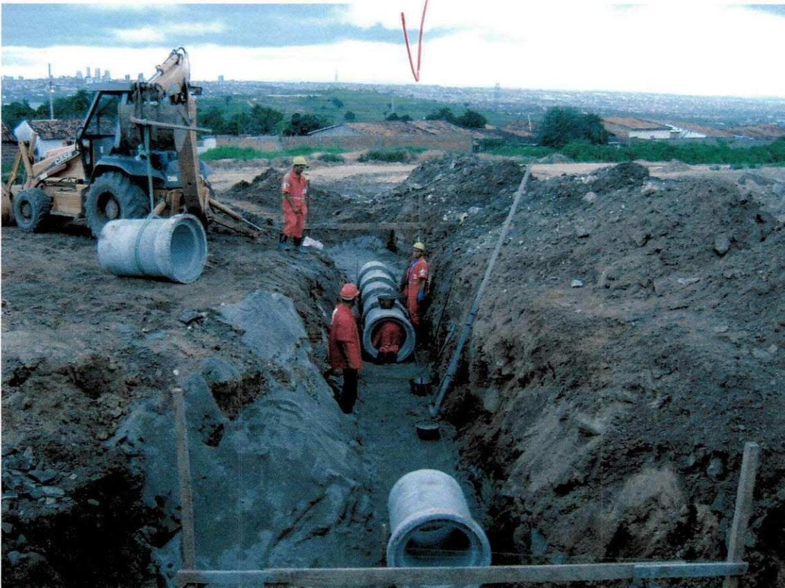
Figura 02: Assentamento de tubos de concreto de drenagem
