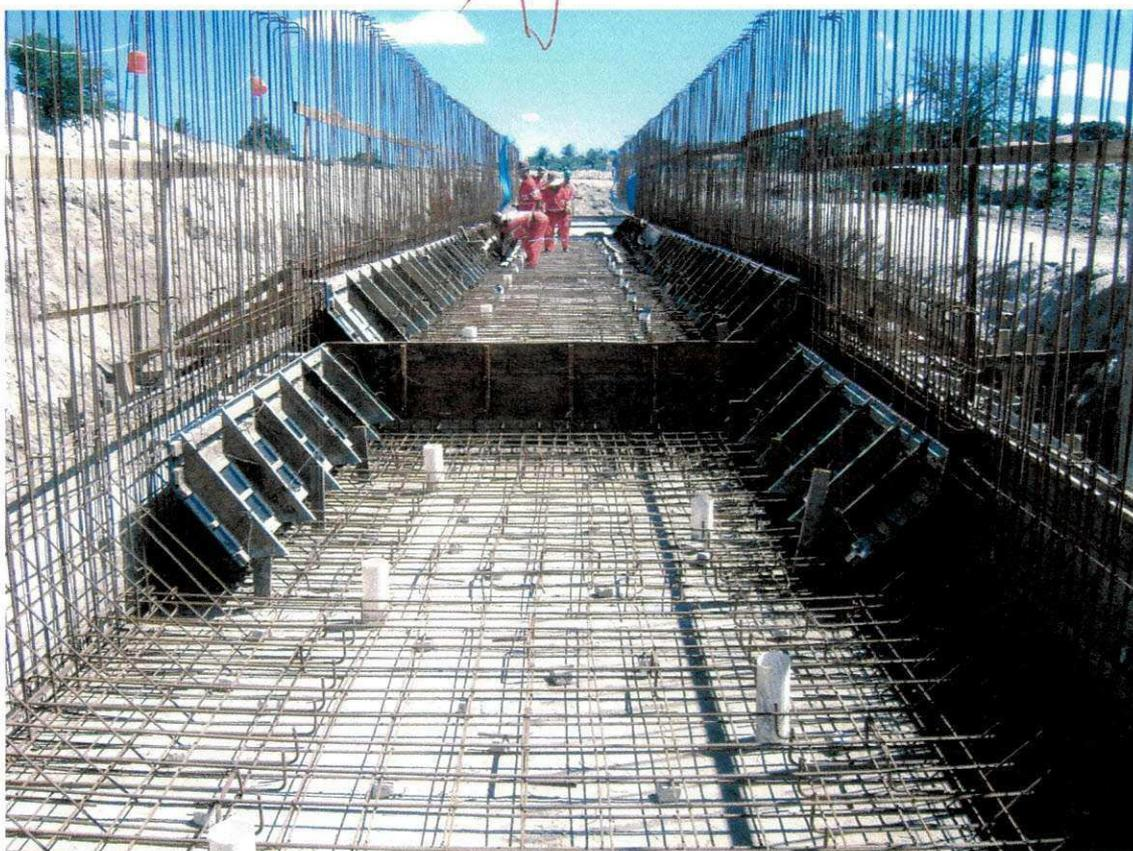
Figura 16: Detalhe da ferragem do canal
