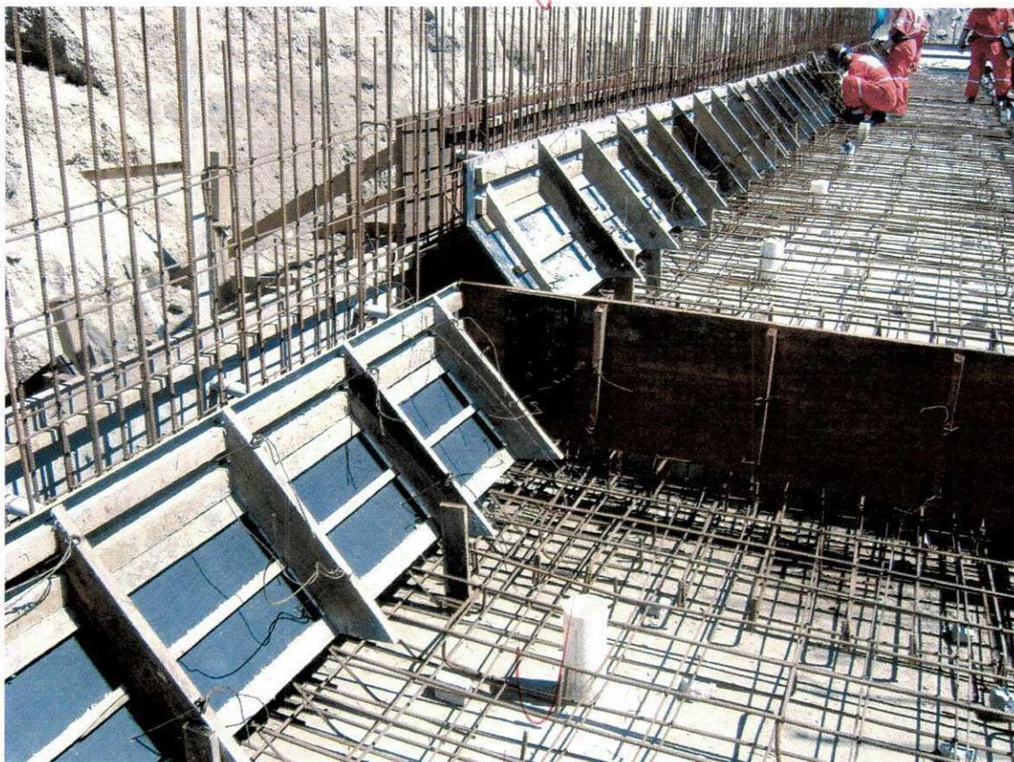
Figura 15: Detalhe das formas da mísula do canal
