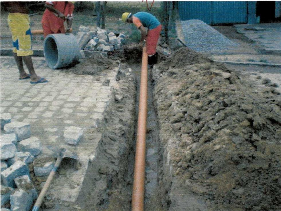
Figura 20: Escavação e assentamento de tubos de esgoto
