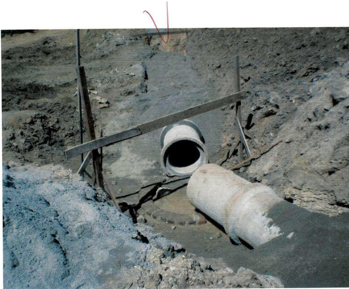
Figura 07: Encontro dos tubos de drenagem no poço de visita
