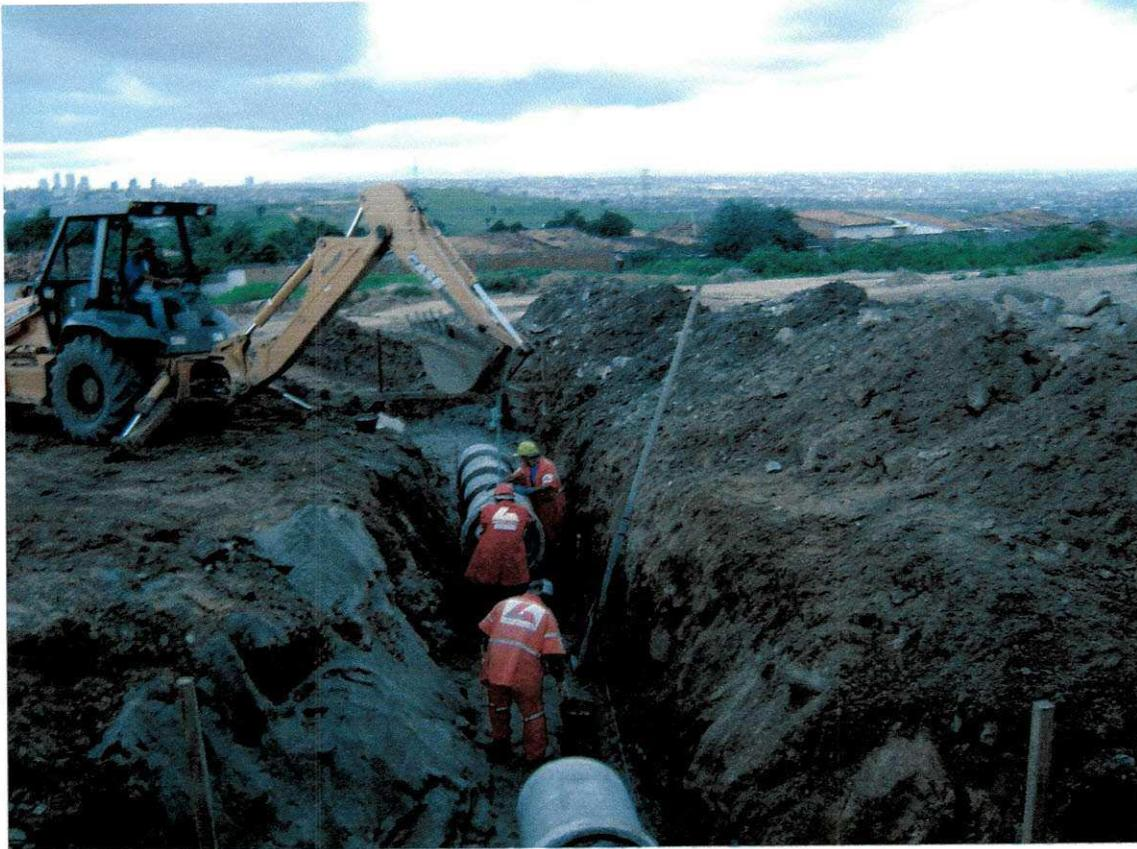
Figura 03: Colocação de tubos de concreto
