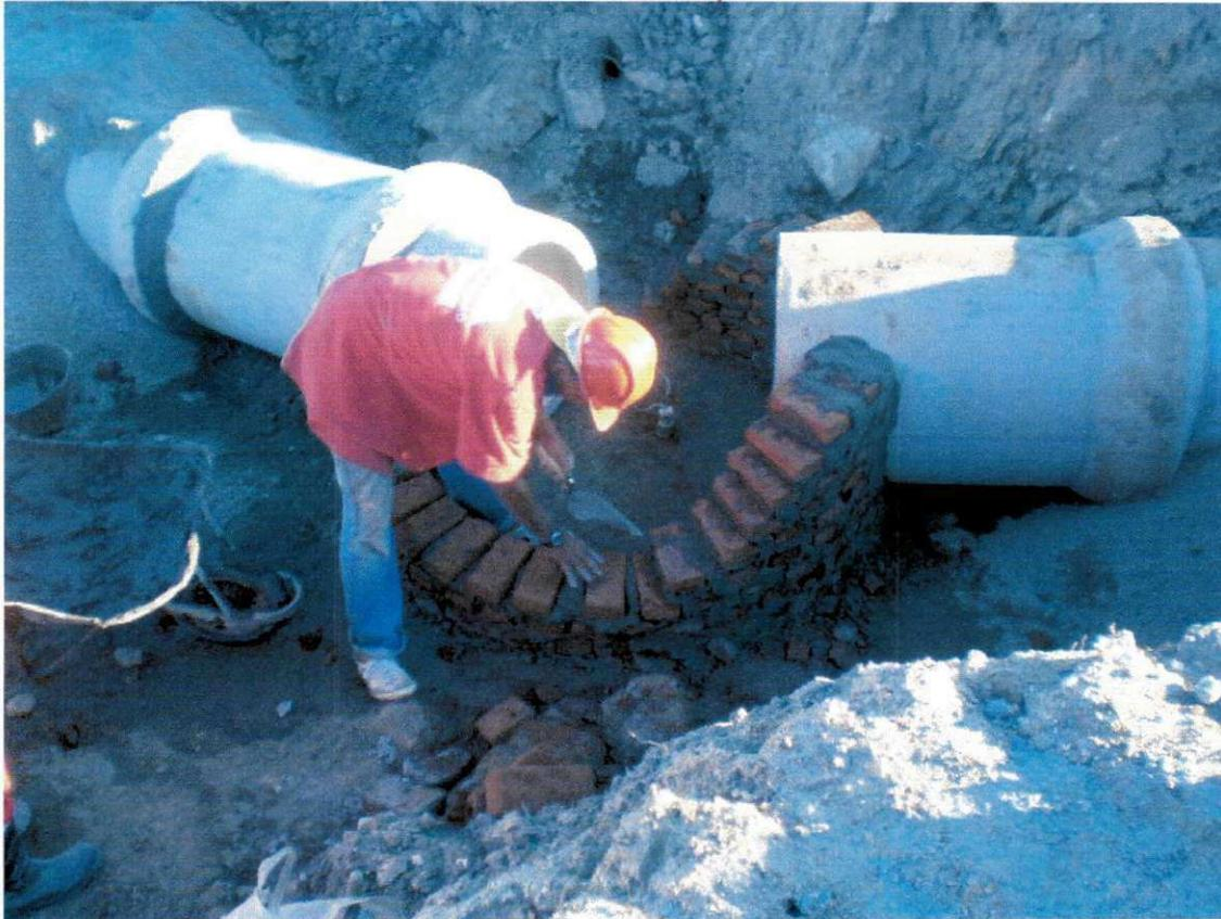
Figura 09: Construção do poço de visita
