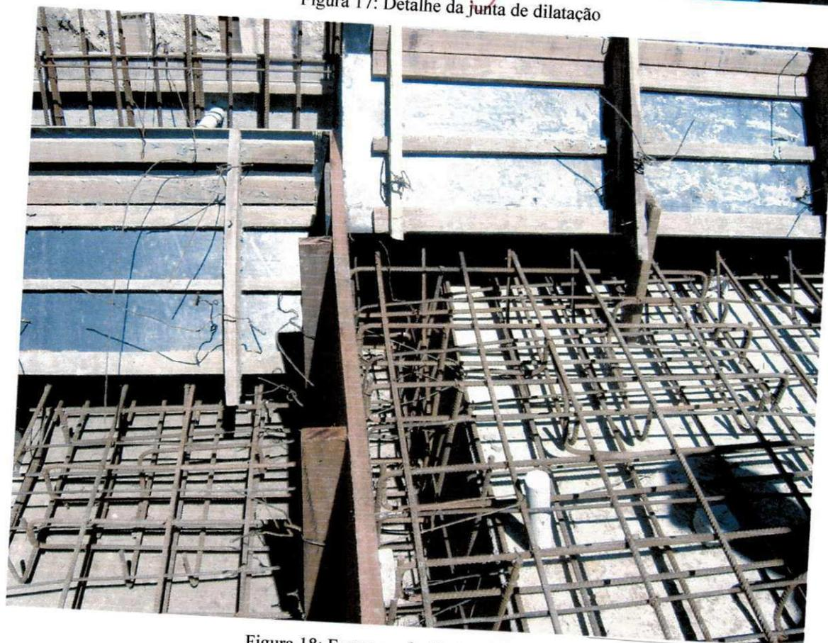
Figura 18: Ferragem do dissipador de energia
