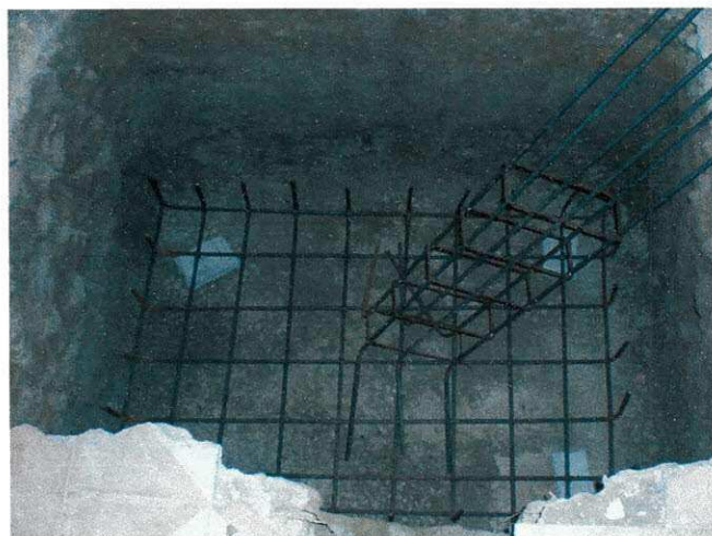
Figura 10 – Fuste do pilar sobre o leito da sapata
