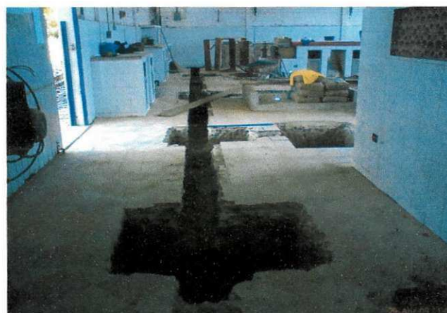
Figura 05 – Escavação das Sapatas e Vigas Baldrame
