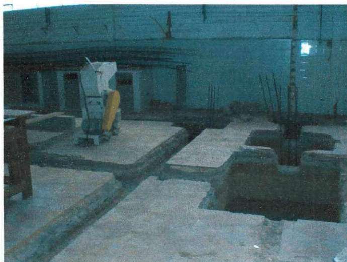
Figura 12 – Escavação de valas para a viga baldrame
