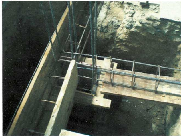
Figura 14 – Viga Baldrame com fôrma
