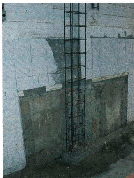
Figura 17 - Pilar aguardando as fôrmas
