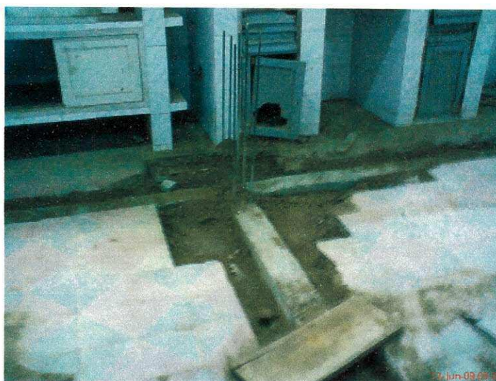
Figura 16 – Viga Baldrame concretada e conclusão do reaterro
