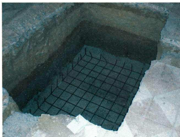
Figura 09 – Grelha sobre o concreto magro e a cocada
