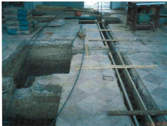
Figura 15 – Amarração para suspensão das vigas
