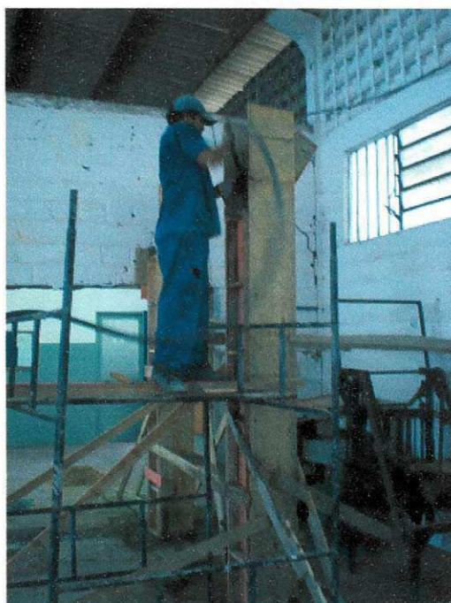
Figura 19 – Lançamento do concreto e adensamento com vibrador.
