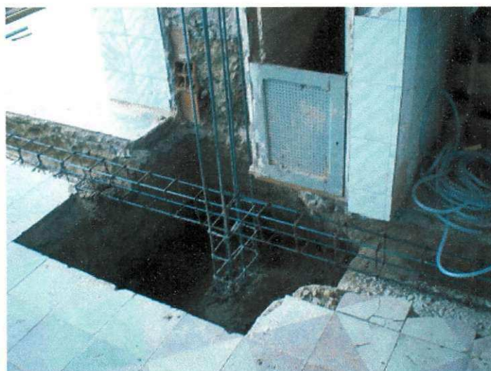
Figura 13 – Encontro do fuste do pilar com a viga baldrame
