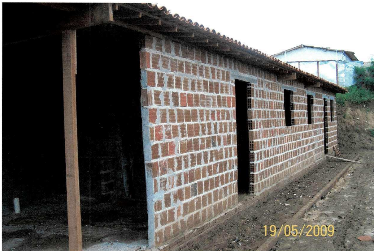
Figura 21 – Construção das instalações do canteiro.
