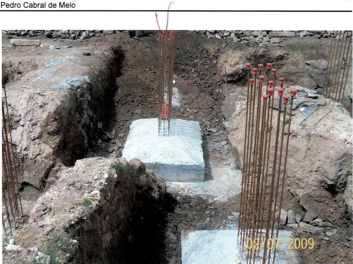
Figura 26 – Sapatas concretadas.
