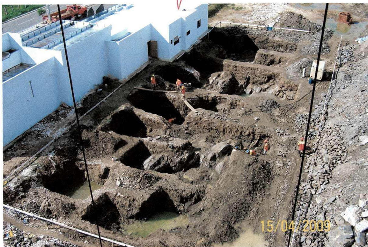
Figura 18 – Conjunto de valas da torre A.
