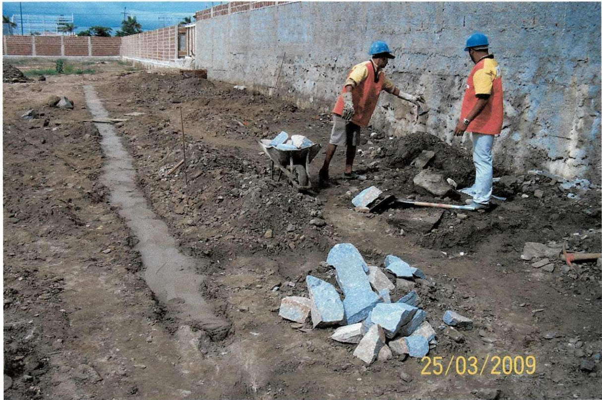
Figura 19 – Construção das instalações do canteiro.
