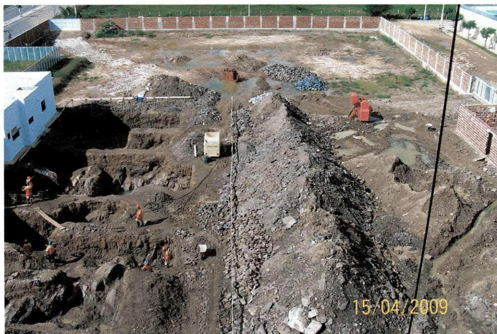
Figura 17 – Canteiro de obras após o final das escavações.
