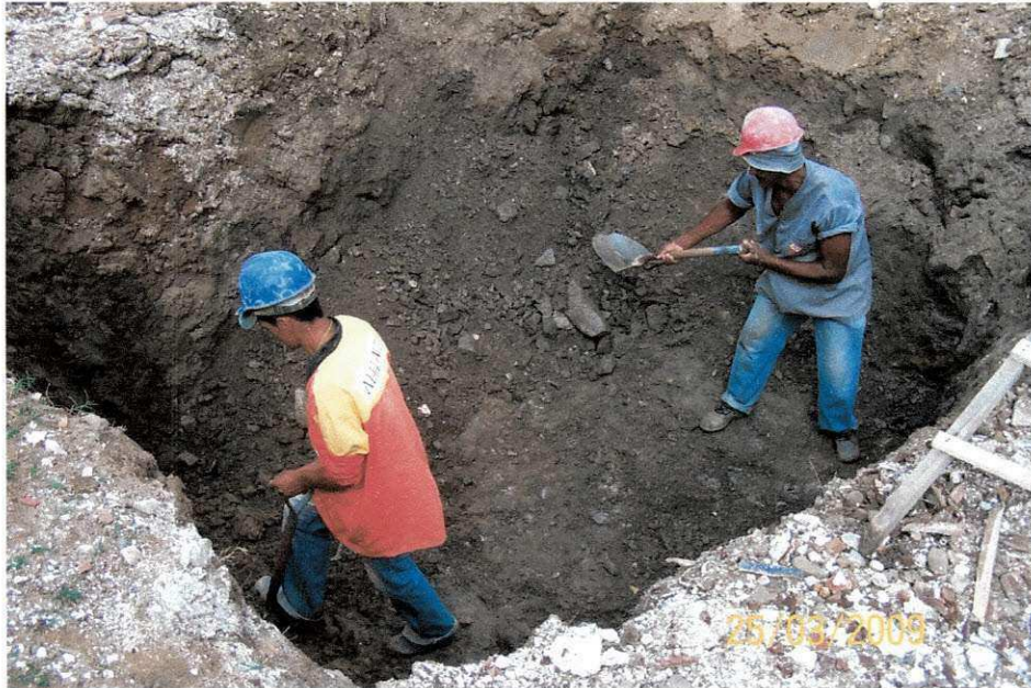
Figura 14 – Limpeza do fundo da vala.
