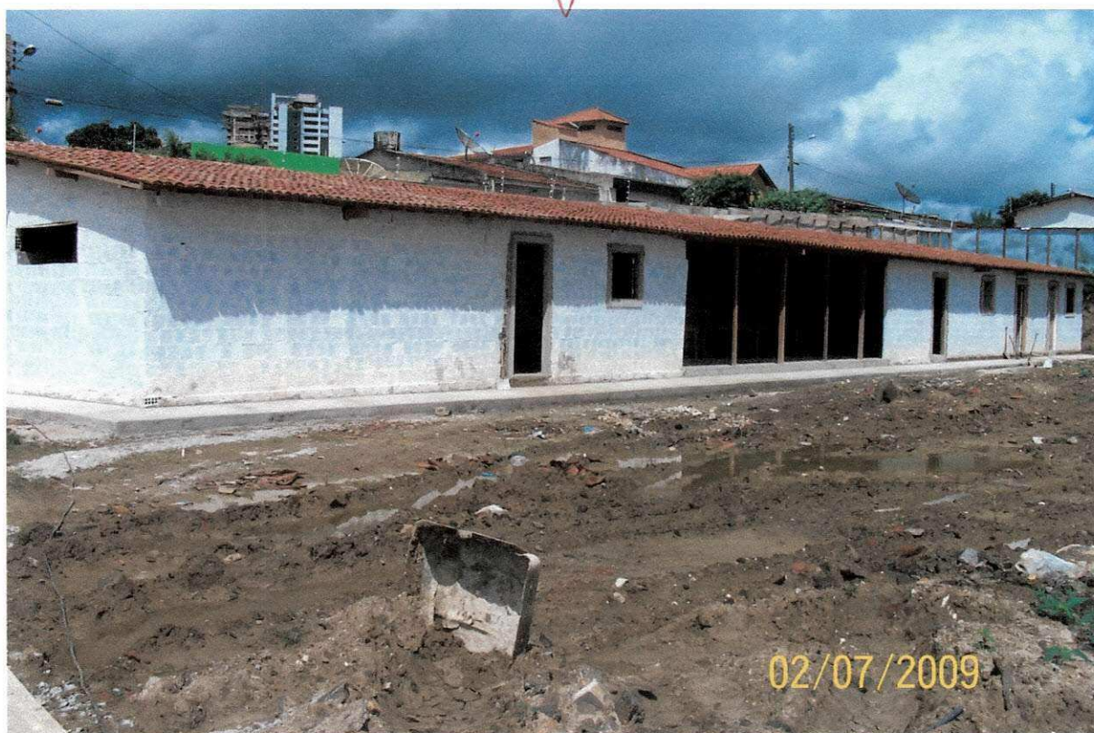
Figura 22 – Construção das instalações do canteiro.
