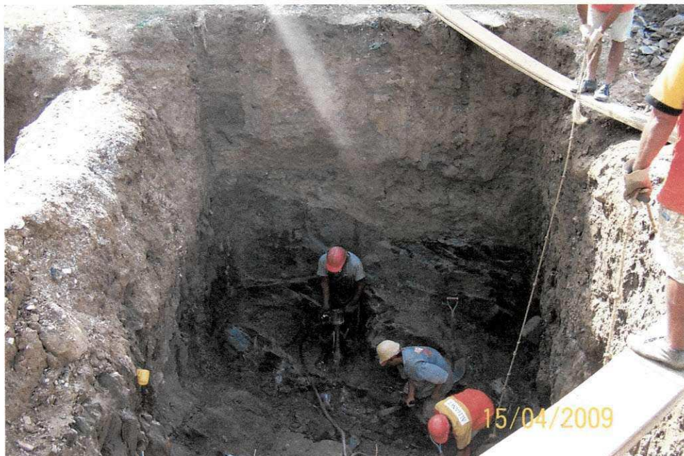
Figura 16 – Operário operando o rompedor.
