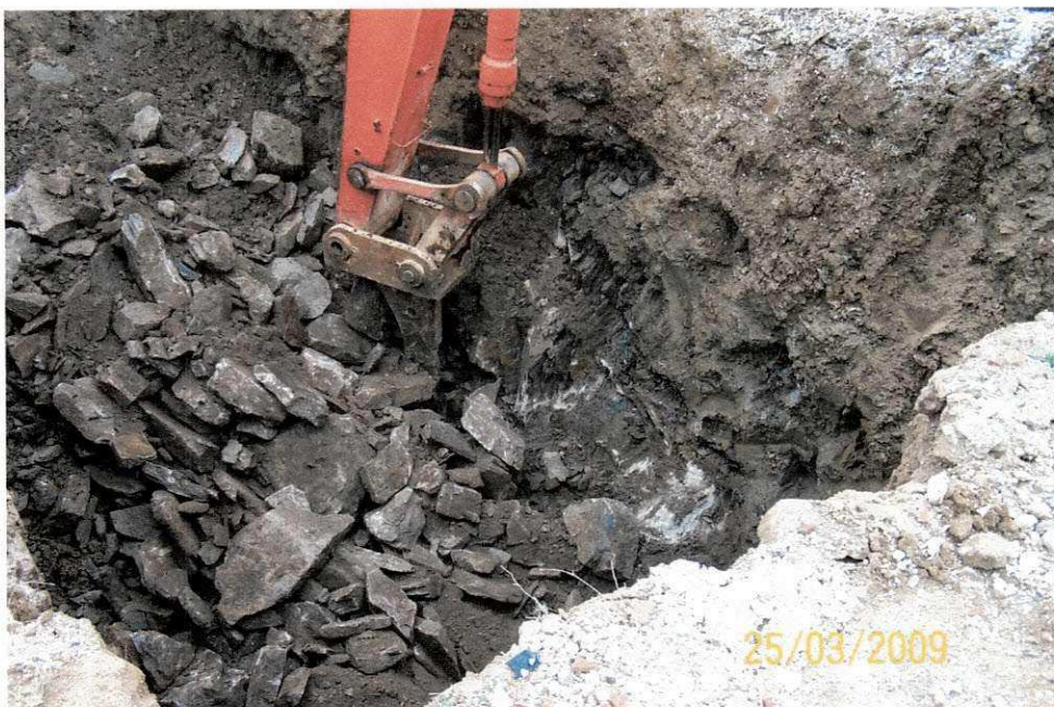
Figura 15 – Broca soltando rochas.
