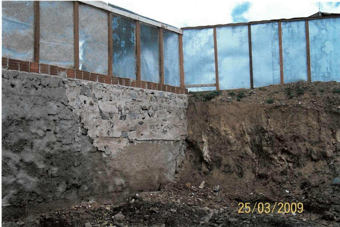
Figura 12 – Muro de arrimo.
