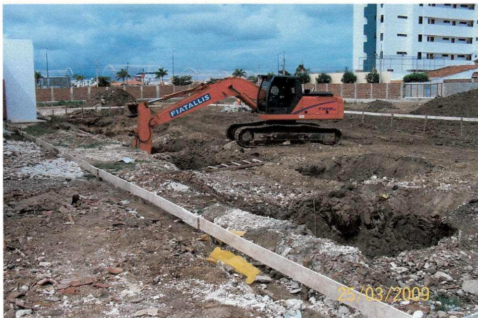
Figura 13 – Escavadeira retirando material solto.
