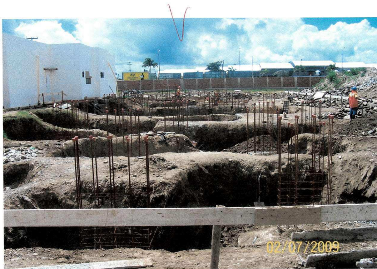
Figura 28 – Espera de aço para os pilares.
