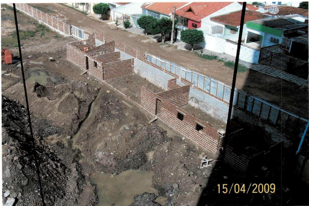
Figura 20 – Construção das instalações do canteiro.
