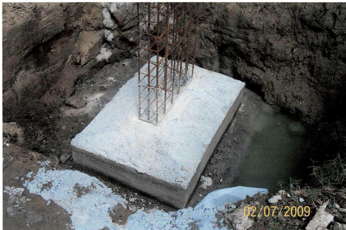
Figura 25 – Sapata concretada.
