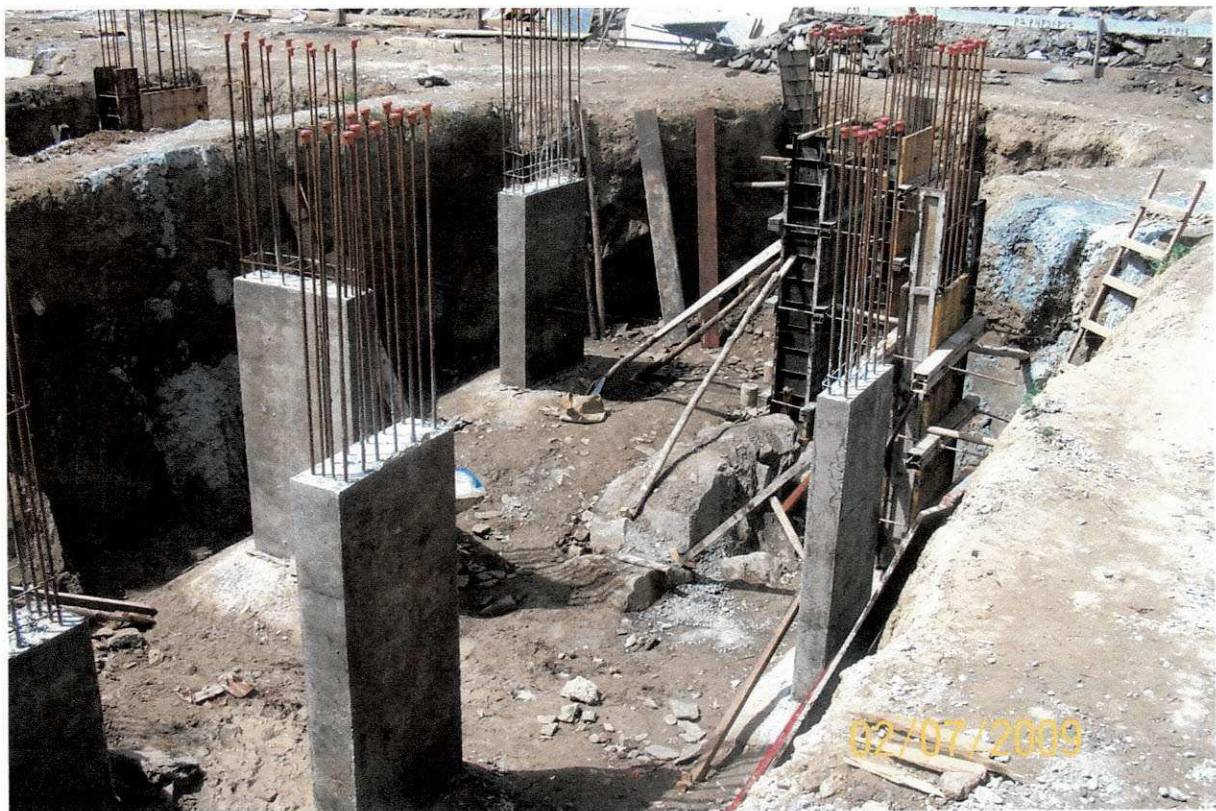
Figura 27 – Sapatas e arranques concretadas.
