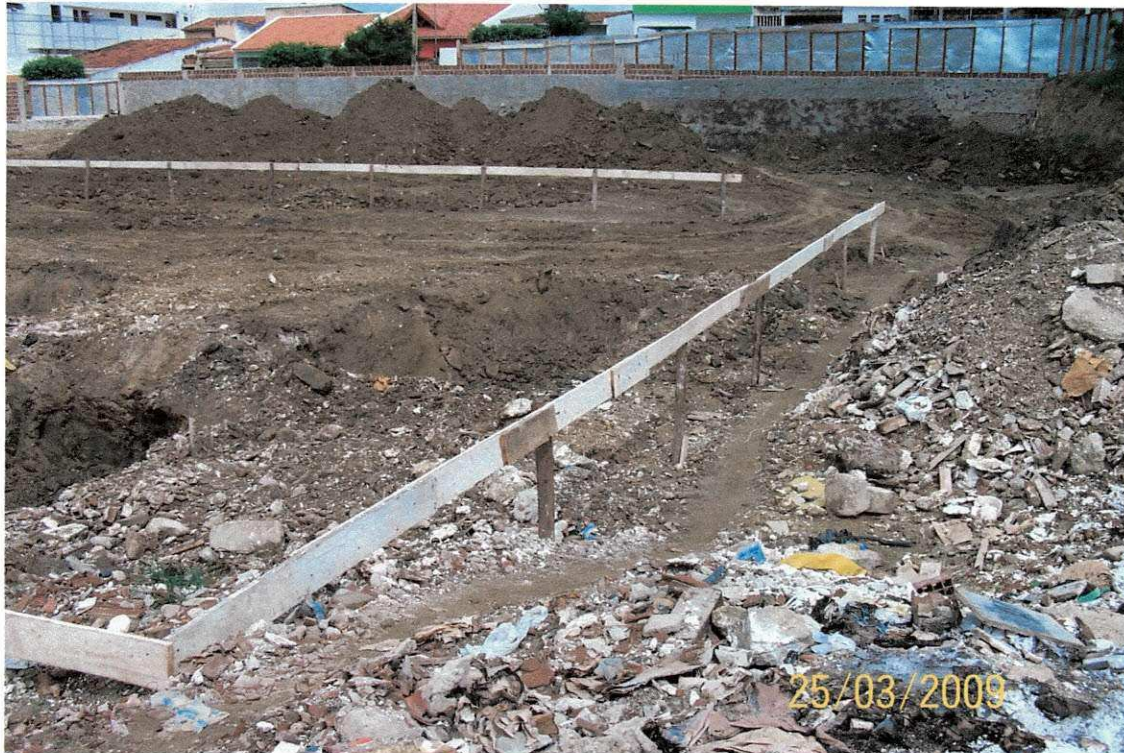
Figura 11 – Final da marcação do gabarito e início das escavações.
