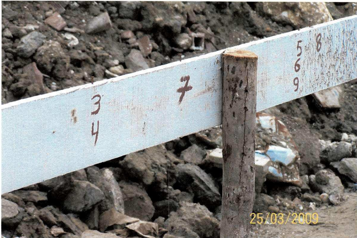
Figura 9 – Exemplo de marcação, na tabeira, de eixo de pilar.
