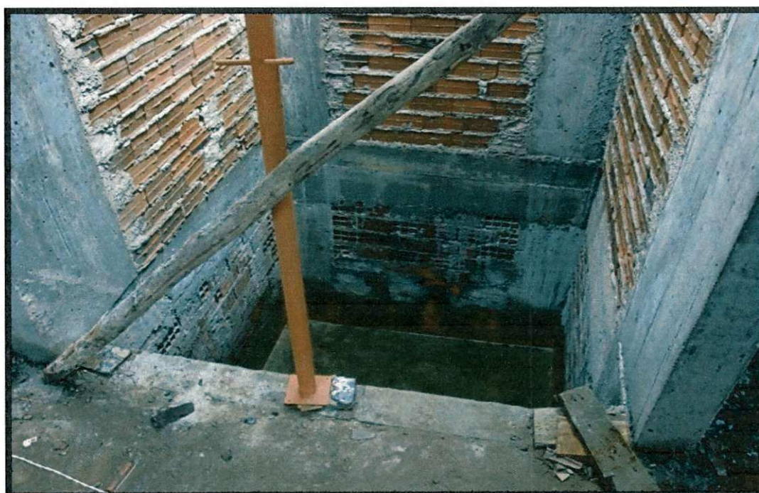
Figura 15 - Fechamento de alvenaria
