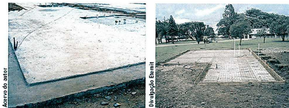
Figura 02 – Fundação rasa (radier)
