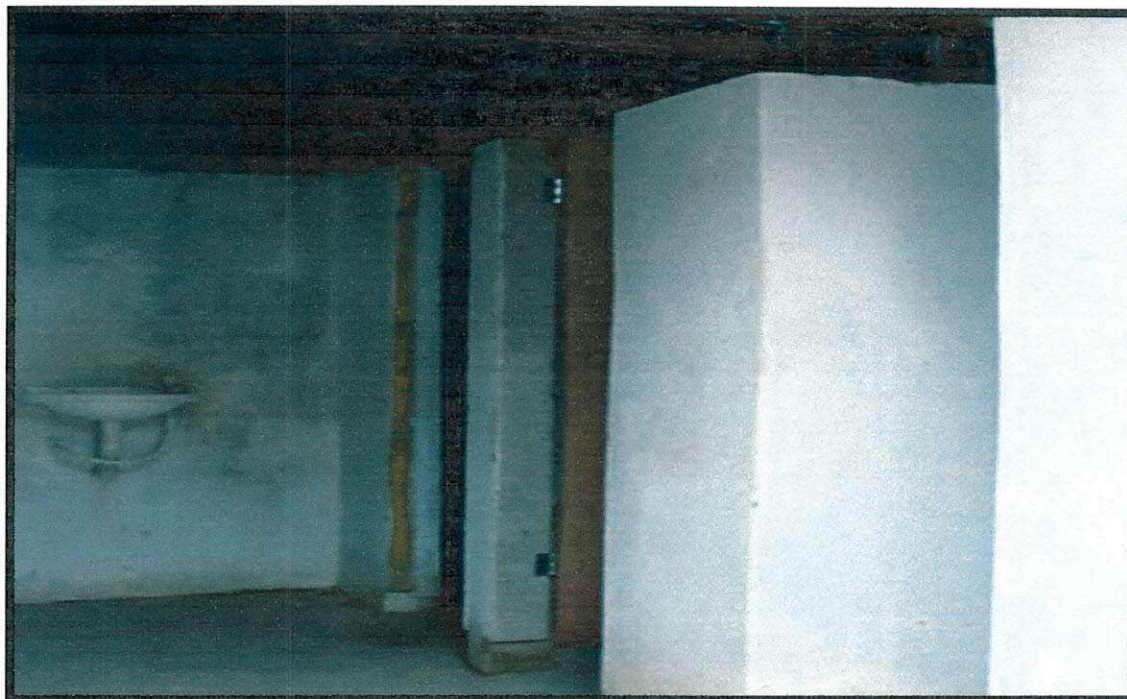
Figura 12 – Alojamento e sanitários
