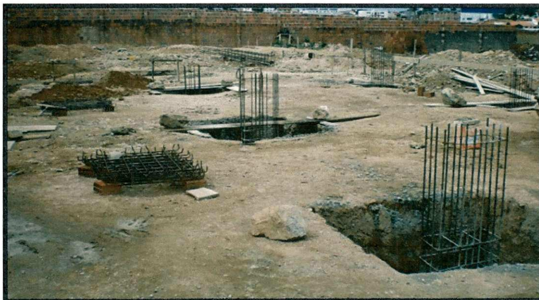
Figura 13 – Detalhes da fundação (sapata)
