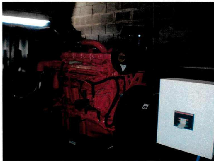
Figura 6 - Instalação da bomba – combate a incêndio
