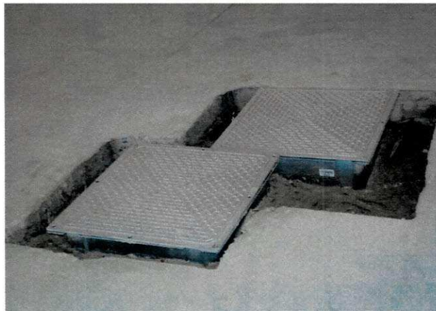
Figura 11 - Caixas de passagem para instalação dos cabos
