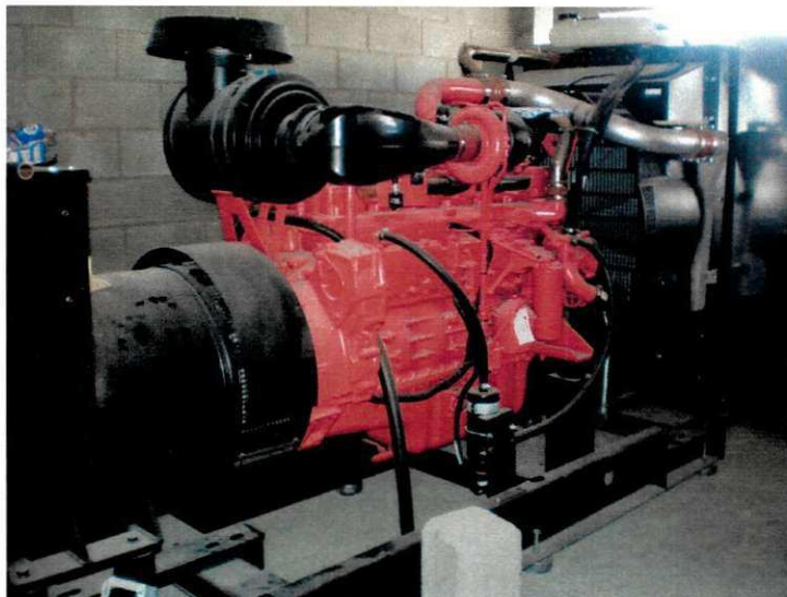
Figura 7 - Instalação da bomba – combate a incêndio
