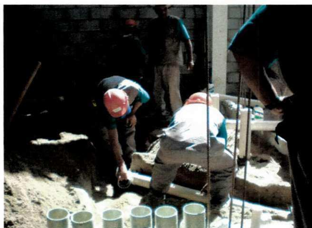
Figura 13 – Instalação da tubulação hidro-sanitária
