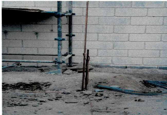
Figura 10 - Instalação dos cabos de aterramento
