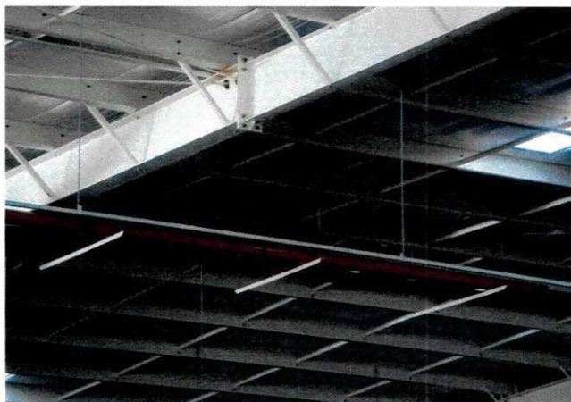
Figura 2 - Instalação da tubulação de combate a incêndio
