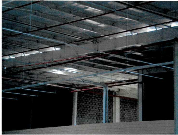
Figura 5 - Instalação da tubulação de combate a incêndio - rede de sprinkler
