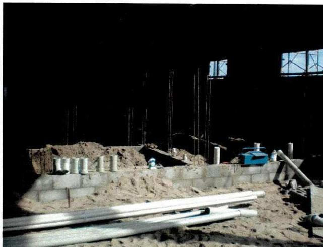
Figura 14 – Instalação da tubulação hidro-sanitária
