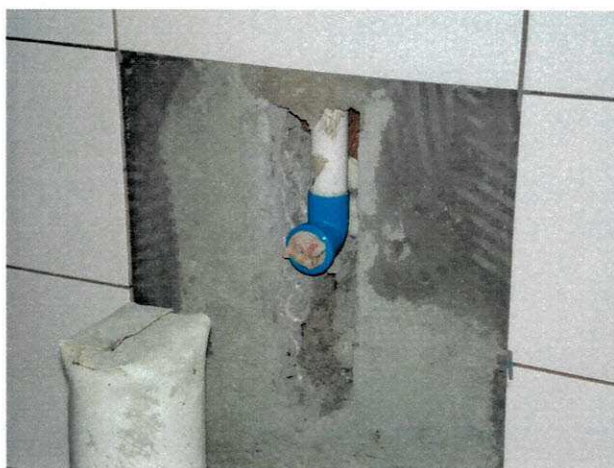
Figura 15 - Detalhe da instalação hidro-sanitária
