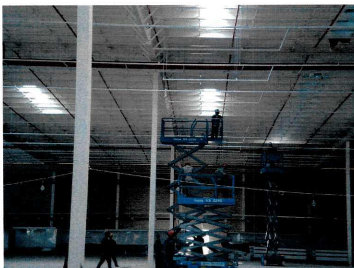
Figura 4 - Instalação da tubulação de combate a incêndio - rede de sprinkler
