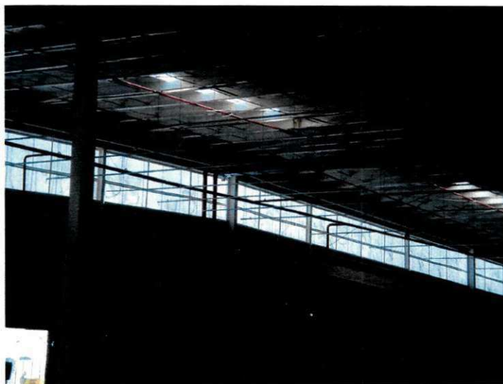
Figura 3 - Instalação da tubulação de combate a incêndio - rede de sprinkler
