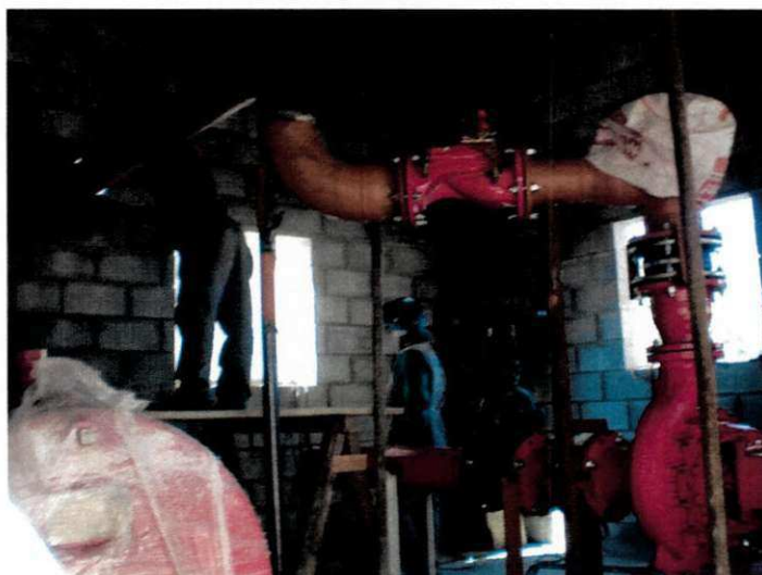
Figura 8– Instalação das conexões da bomba – casa de bombas
