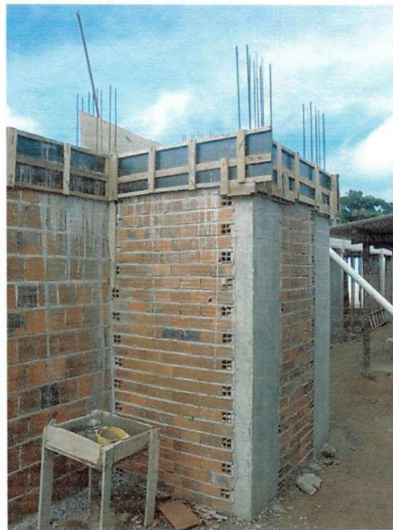
Figura 12 – Poço do elevador.
