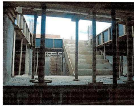
Figura 10 e Figura 11 – Fechamento de alvenaria do poço do elevador e escada.
