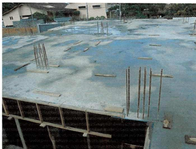
Figura 16, Figura 17 e Figura 18 – Laje concretada.
