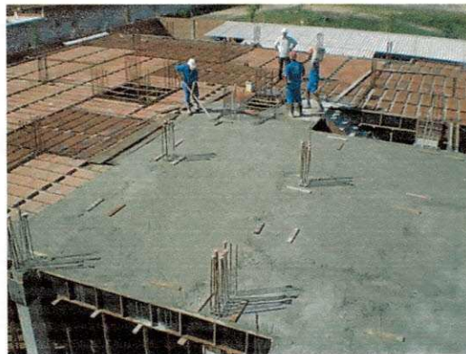
Figura 15 – Concretagem de laje.
