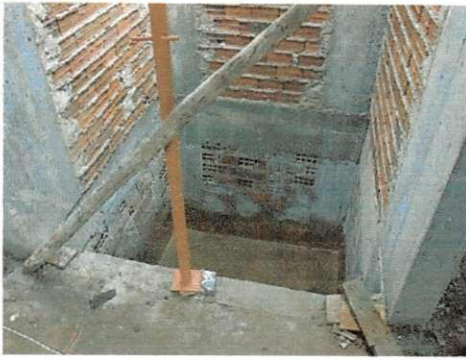
Figura 10 e Figura 11 – Fechamento de alvenaria do poço do elevador e escada.
