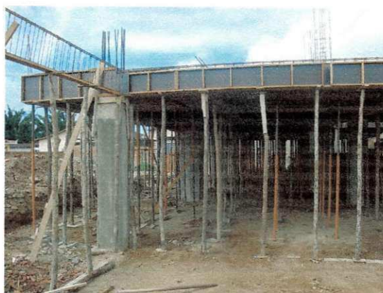
Figura 20 – Laje pré moldada ainda com o escoramento.
