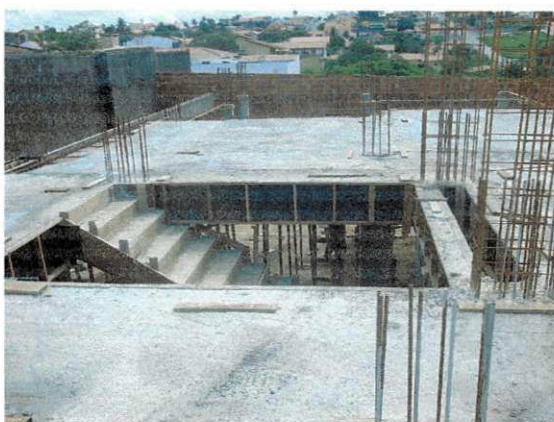
Figura 21 – Laje pré moldada e escada.
