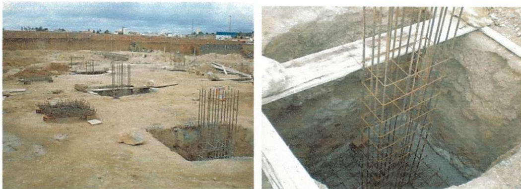
Figura 7 e Figura 8 – Disposição e detalhamento dos pilares.
