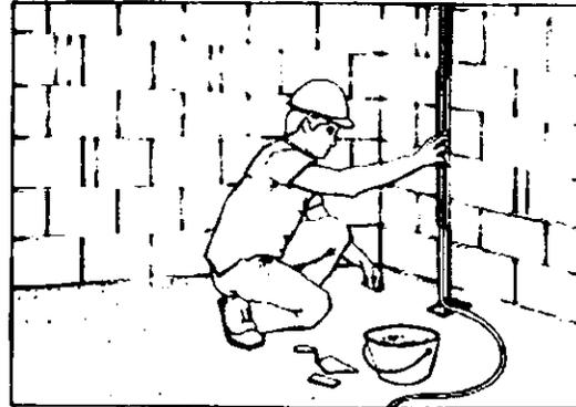
**Figura 10:** Aparelho de nível e assentamento de talisca empregando-se o aparelho de nível.
