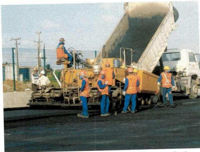
FOTO 33 – Vibro - acabadora e caminhão basculante
