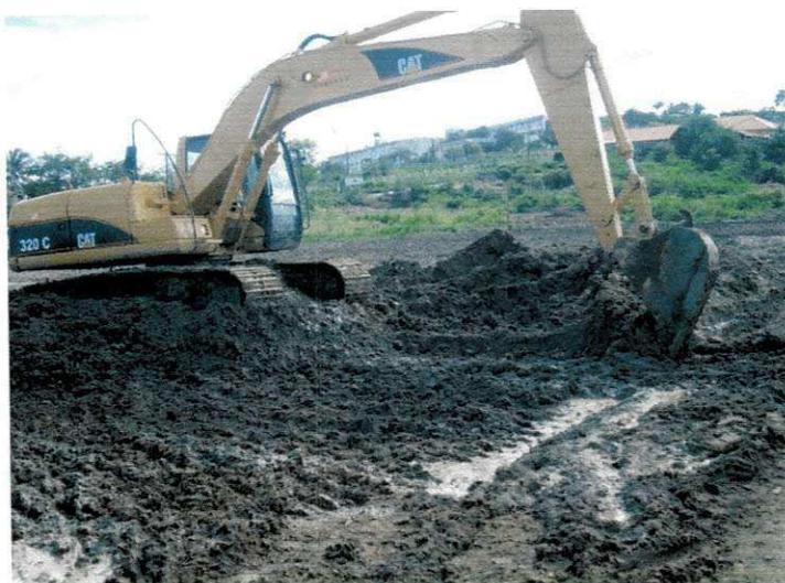
FOTO 17 - Escavação mecânica em lama
