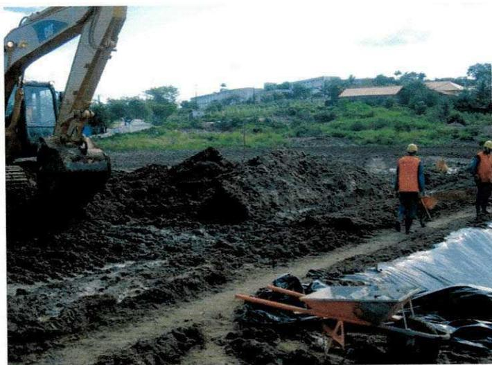
FOTO 16 - Escavação mecânica em lama
