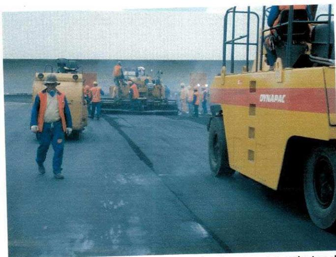
FOTO 34 - Vibro – acabadora, rolo de pneus e rolo tandem
