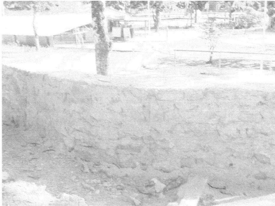
FIGURA 11 - Alvenaria de pedra argamassada (muro de arrimo).
