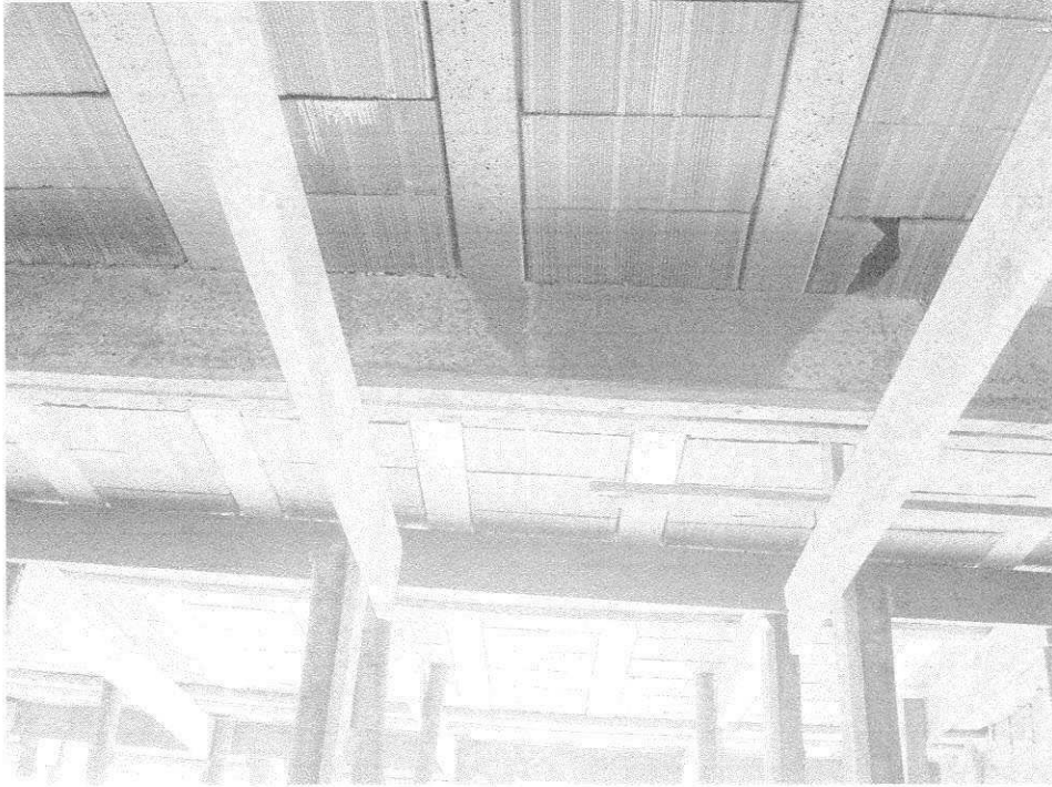
FIGURA 06 - Escoramento da laje pré-moldada do núcleo de apoio.
