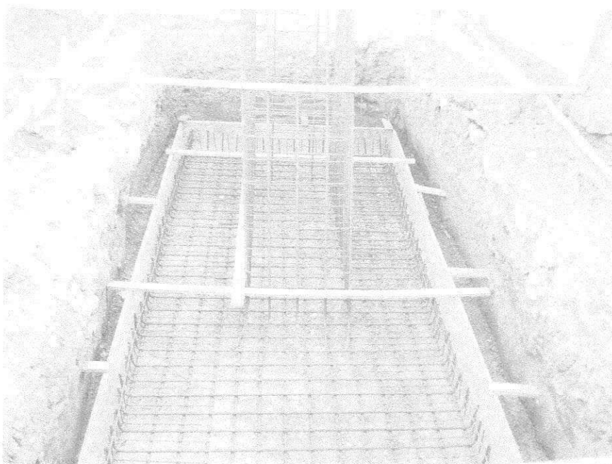
FIGURA 05 – Armadura da sapata da plataforma.
