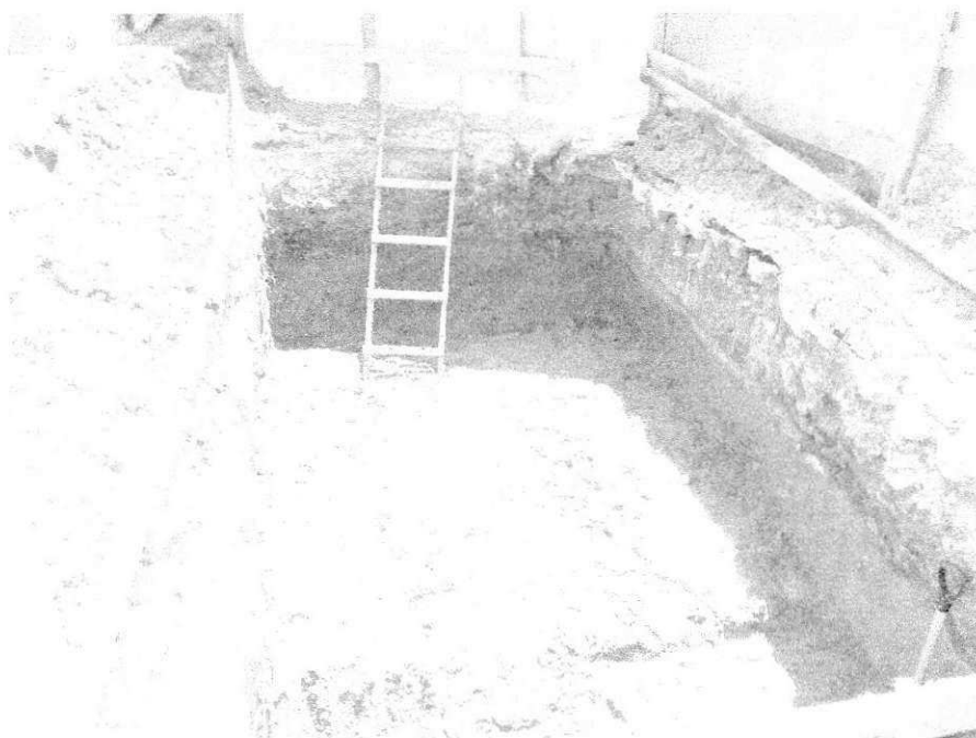
FIGURA 02 – Regularização de escavação em solo-cimento.
