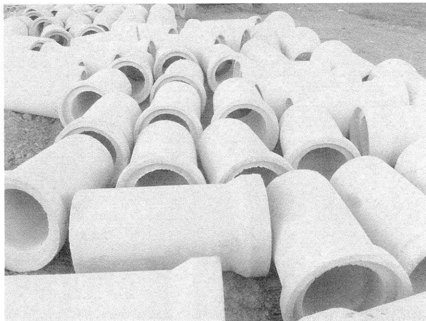
FIGURA 13 - Tubos em concreto armado utilizados rede de drenagem.
