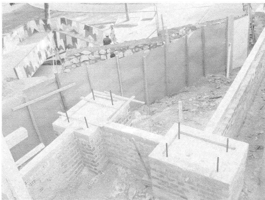
FIGURA 09 - Base para estrutura metálica para os pórticos do núcleo de apoio.
