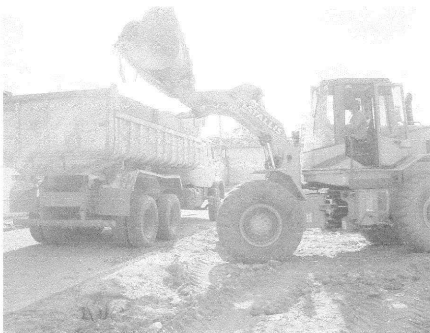
FIGURA 01 - Remoção de resíduos de demolição.
