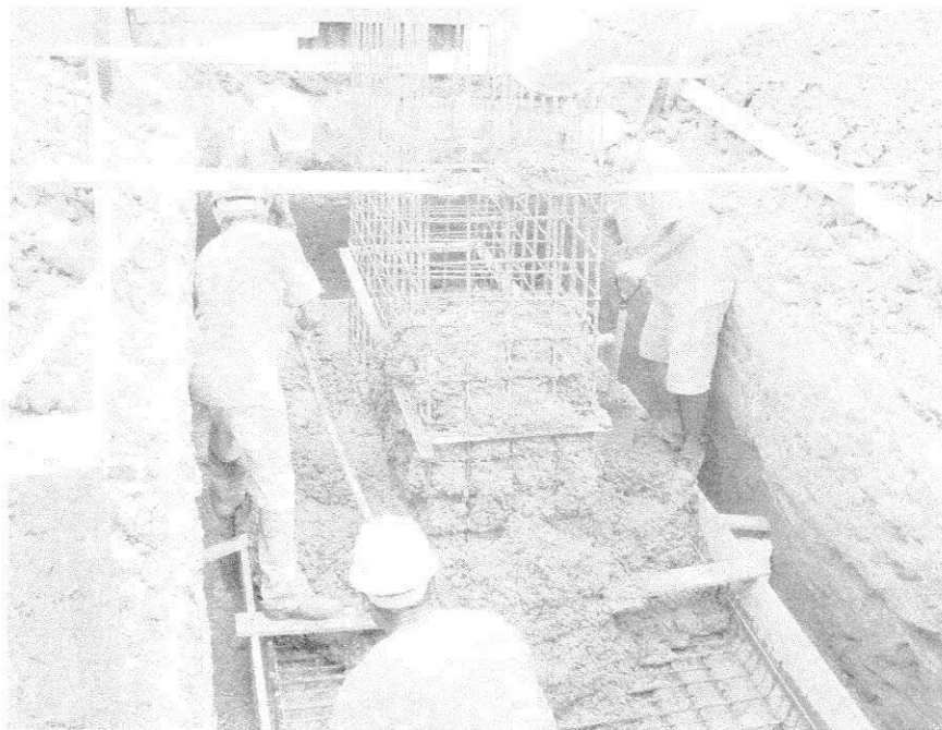
FIGURA 04 – Concretagem da sapata da plataforma.
