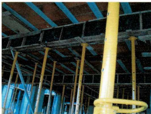
Figura 13 - Fôrmas e escoramentos para lajes e vigas
