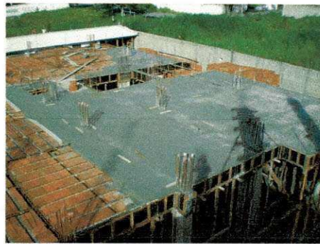
Figura 5 - Laje pré-fabricada durante a concretagem.
