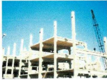
Figura 2 - Operação de montagem de painéis pré-fabricados (cortesia Rodrigues Lima)
