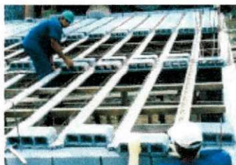
Figura 1 - Operação de alinhamento das vigotas e painéis treliçados (cortesia Lajes Anhanguera)
