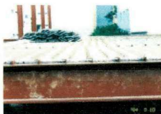
Figura 1 - Operação de alinhamento das vigotas e painéis treliçados (cortesia Lajes Anhanguera)
