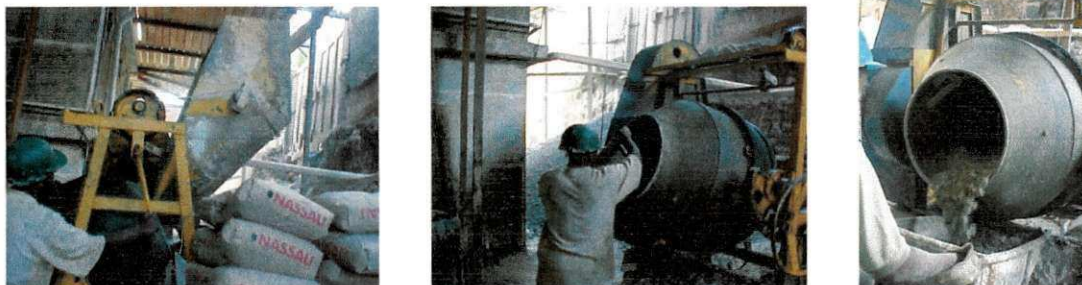
Figura 3 - Processo de fabricação do concreto in locu
