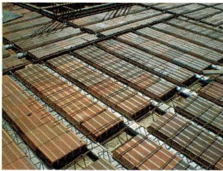
Figura 4 - Laje pré-fabricada antes da concretagem
