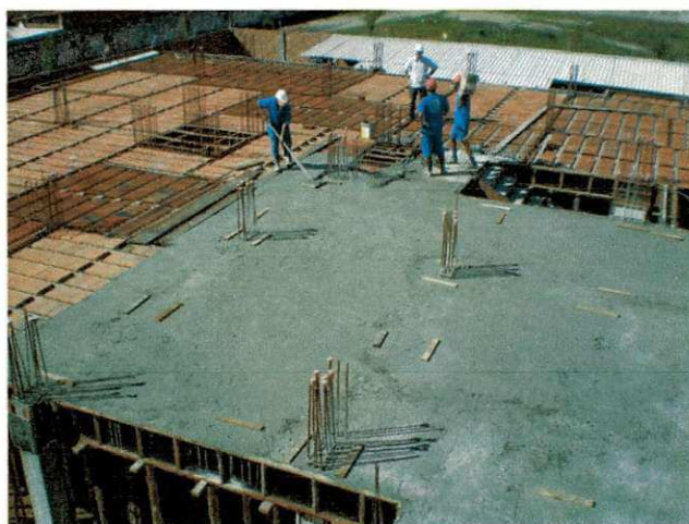
Figura 19 – Operários concretando laje
