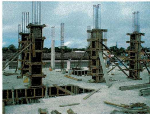
Figura 7 - Armadura à espera do concreto usinado
