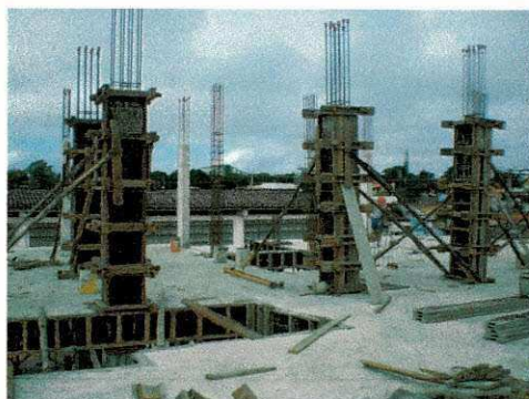
Figura 14 - Fôrmas e escoramentos para pilares
