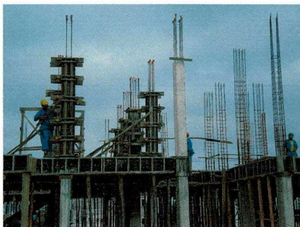
Figura 15- Pilar depois de retirada a fôrma
