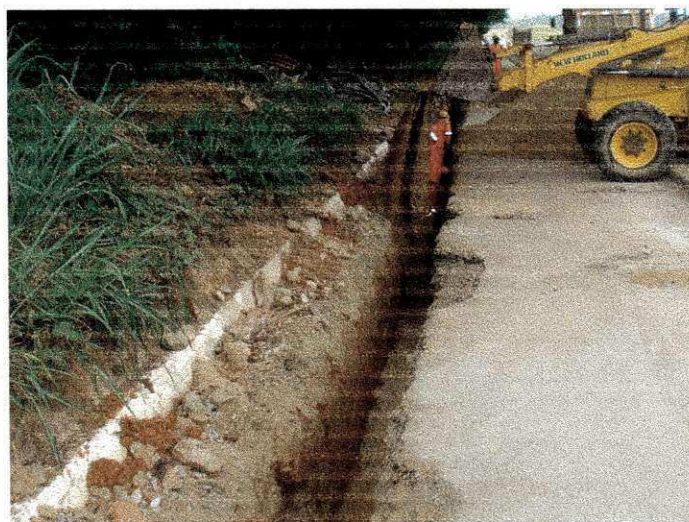
Figura 4.9 – Execução de dreno profundo simples
