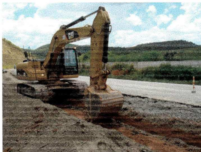
Figura 4.5 – Correção do afundamento no acostamento
