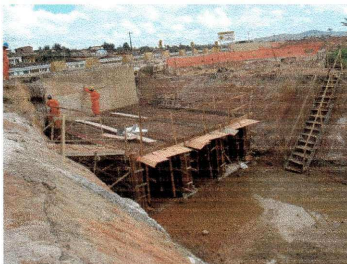
Figura 4.10 – Execução de bueiro celular de concreto
