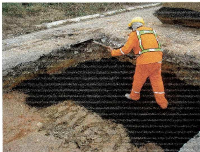
Figura 4.6 – Recuperação do pavimento existente
