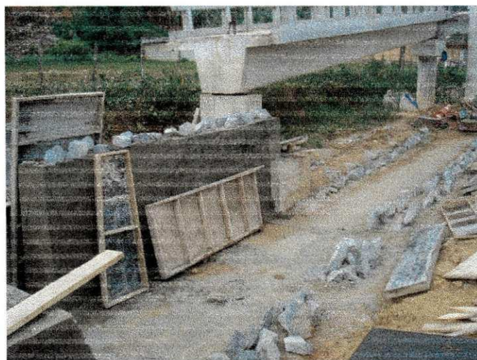
Figura 4.11 – Construção da rampa de acesso a passarela
