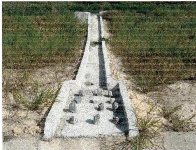
Figura 4.1 – Descida d'água com dissipador de energia
