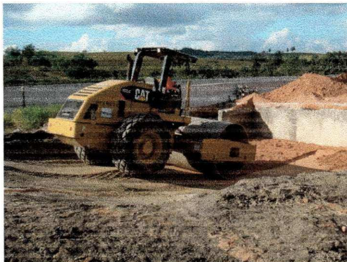
Figura 4.8 – Execução do aterro no encontro de ponte
