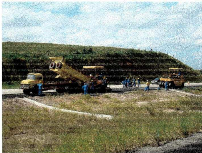
Figura 4.4 – Aplicação de CBUQ
