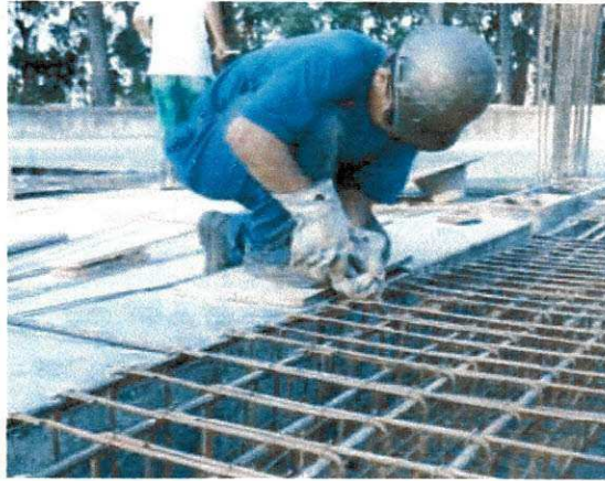
Figura 3.11-Armadura da laje
