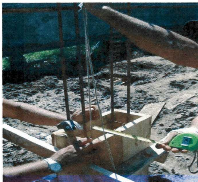
Figura 3.5- Colocação de fôrma e prumo no pilar
