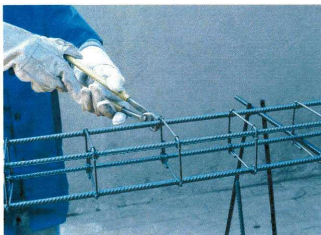
Figura 3.7- Armadura para viga
