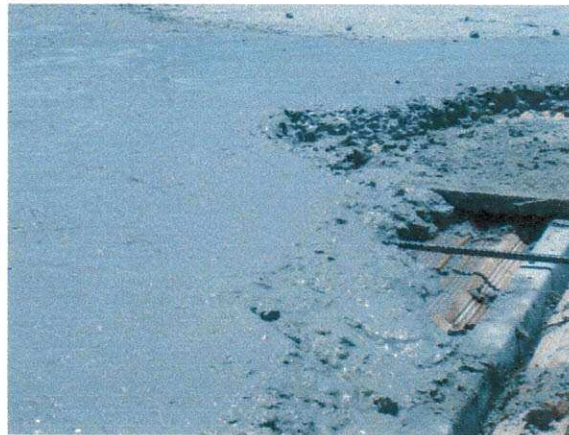
Figura 3.12- concretagem da laje
