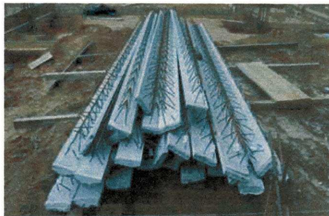
Figura 3.13- treliça para laje pré-moldada
