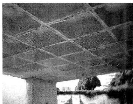
Solar das Acácias (4ª laje – Em processo de Cura e sendo Desinformada)
